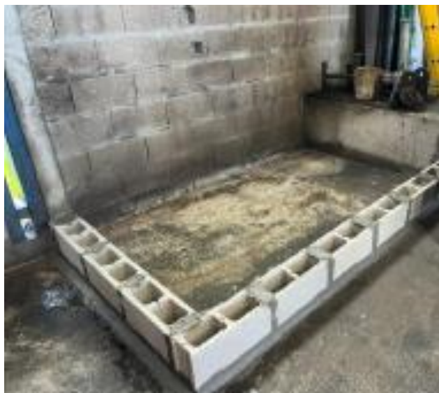
Foto 12.3-1, Obrador central de CVC SA, se construyó envallado estanco dentro del taller mecánico.
