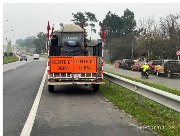
Foto 12.1-10, P05. Frente de obra, Ruta Interbalnearia progresiva 35K800 a (-). Mantenimiento de áreas verdes en ejecución, subcontratista Gadulir SA.
