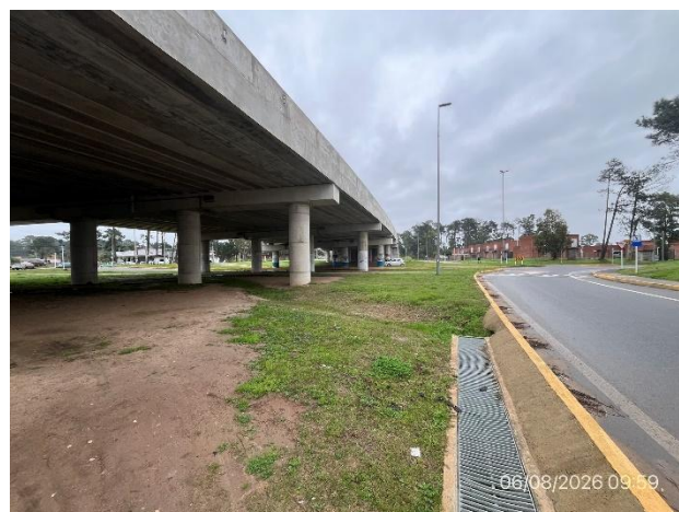
Foto 12.1-8, P04. Obra obligatoria terminada, nuevo intercambiador en desnivel, Parque del Plata. Ruta Interbalnearia progresiva 50K800.
