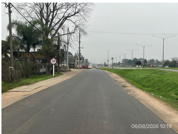
Foto 12.1-7, Ruta Interbalnearia. Obras complementarias de mantenimiento terminadas, calzada auxiliar en senda a (+) ejecutada.
