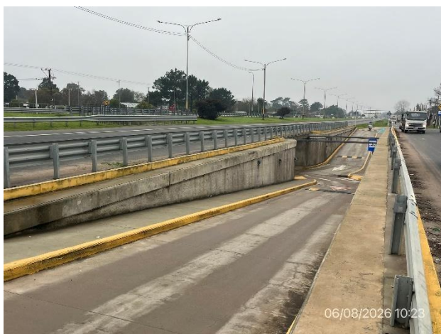
Foto 12.1-9, P03. Obra obligatoria terminada, túneles subterráneos en Pinamar. Ruta Interbalnearia progresiva 36K350.
