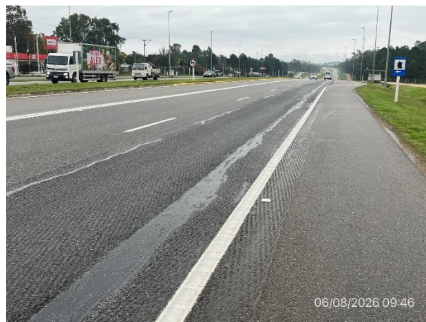
Foto 12.1-4, Ruta Interbalnearia. Obras de mantenimiento terminadas, fresados en calzada ejecutados.
