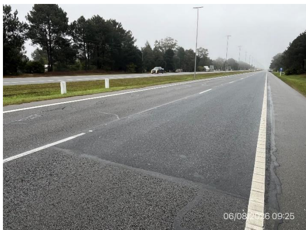
Foto 12.1-3, Ruta Interbalnearia. Obras de mantenimiento terminadas, bacheos en calzada ejecutados.
