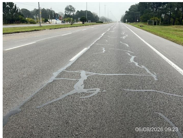
Foto 12.1-2, Ruta Interbalnearia. Obras de mantenimiento terminadas, sellados en calzada ejecutados.
