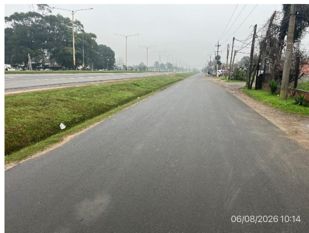
Foto 12.1-6, Ruta Interbalnearia. Obras complementarias de mantenimiento terminadas, calzada auxiliar en senda a (-) ejecutada.
