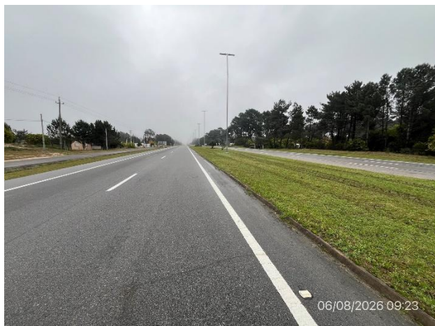
Foto 12.1-1, Ruta Interbalnearia. Obras obligatorias y complementarias de mantenimiento terminadas.
