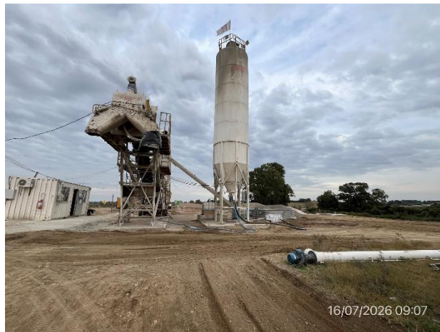
Foto 12.2-2, P05. Obrador, planta de hormigón.
