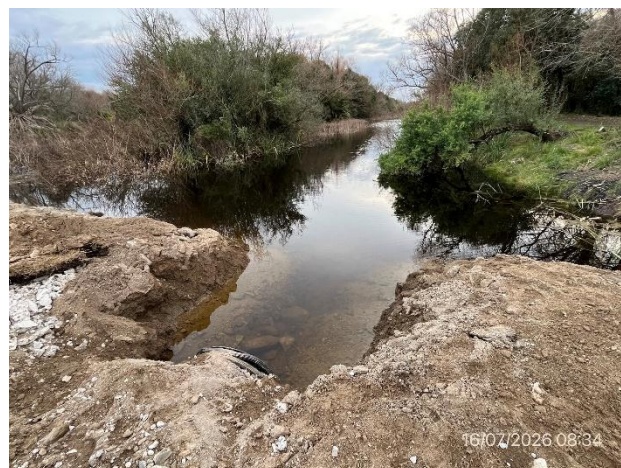
Foto 12.1-4, P01. Entubamiento del A° Pereira ejecutado.
