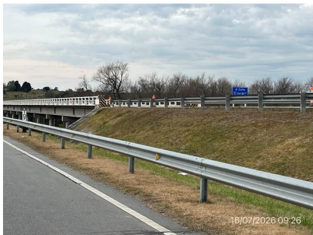
Foto 12.1-7, P04. Nuevo puente en obra sobre A° Cufre. Ruta 1 progresiva 106K820.
