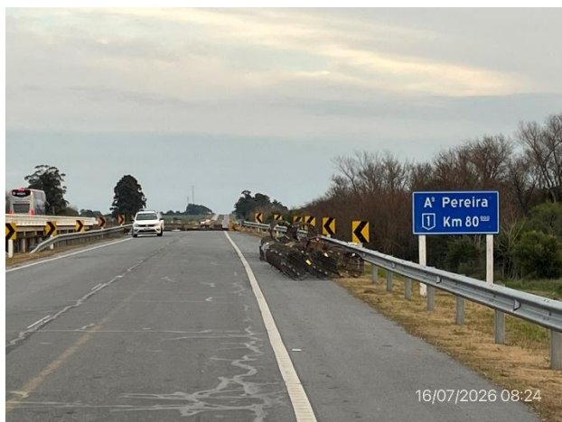
Foto 12.1-1, P01. Nuevo puente en obra sobre A° Pereira. Ruta 1 progresiva 79K920, senda a (+).
