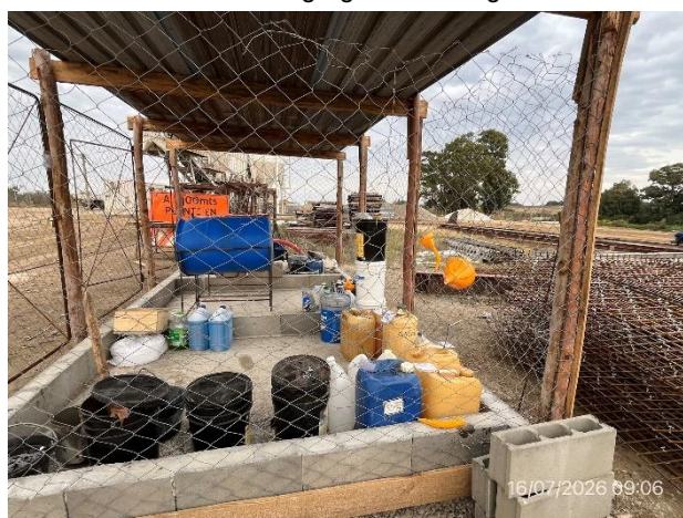
Foto 12.2-10, P05. Obrador, Acopio de lubricantes en uso en sector envallado y techado.
