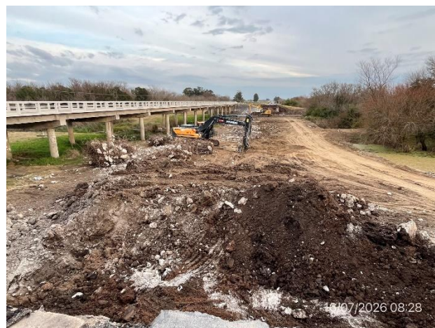
Foto 12.1-2, P01. Maquinaria ejecutando demolición del puente existente.
