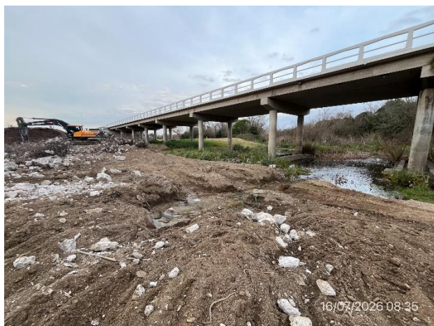
Foto 12.1-3, P01. Atagüa granular ejecutada.
