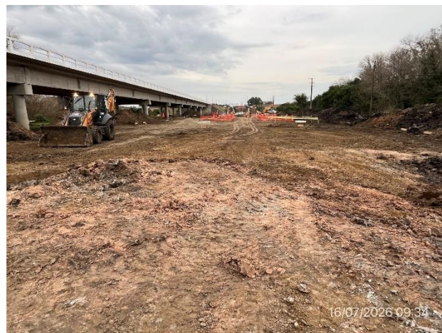
Foto 12.1-8, P04. Atagüía granular ejecutada.
