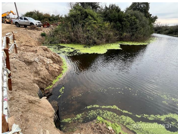
Foto 12.1-9, P04. Entubamiento del A° Cufre ejecutado
