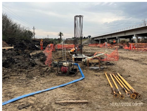
Foto 12.1-10, P04. Cabezales de pilotes en ejecución. Falta infraestructura para acopio temporal de residuos a pie de obra
