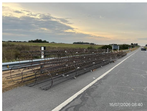
Foto 12.1-6, P01. Se utiliza la calzada de la senda a (+) para acopio de armaduras. Buenas condiciones de orden y limpieza.
