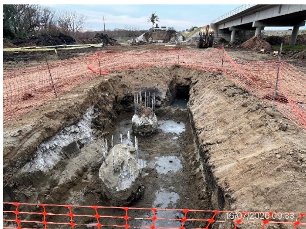
Foto 12.1-11, P04. Obras de pilotaje en proceso de ejecución.
