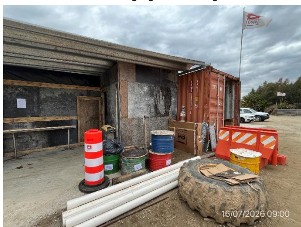
Foto 12.2-9, P05. Obrador, estación de acopio temporal de residuos segregados por corriente de generación.
