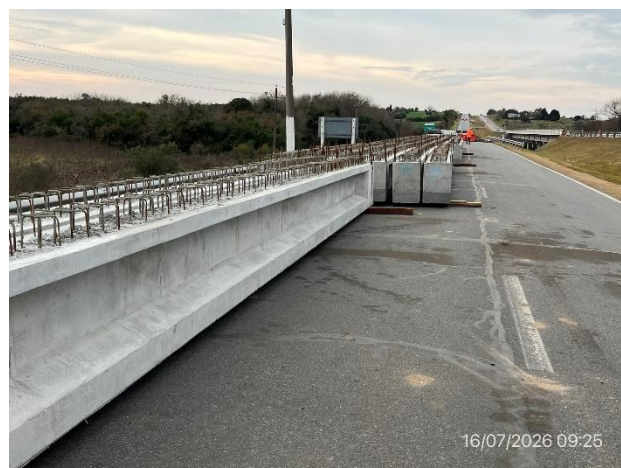
Foto 12.1-12, P04. Se utiliza la calzada de la senda a (+) para acopio de vigas prefabricadas. Buenas condiciones de orden y limpieza.
