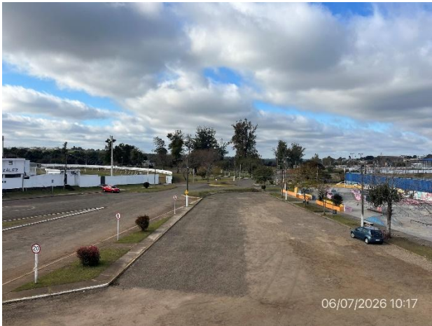
Foto 12.1-7, P02. Obrador provisorio desmontado. Padrón urbano N°3185 de la ciudad de Artigas.
