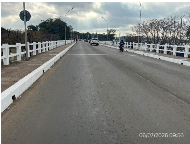
Foto 12.1-3, P01. Obras de recado terminadas, nueva carpeta de rodadura ejecutada.
