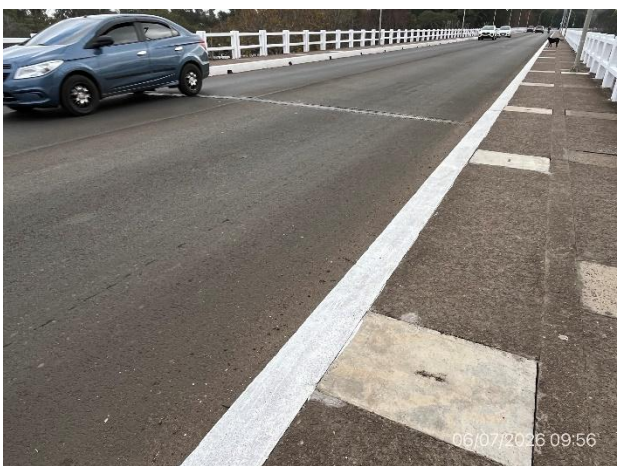
Foto 12.1-5, P01. Obras terminadas, rehabilitación de cámaras de instalaciones ejecutada.
