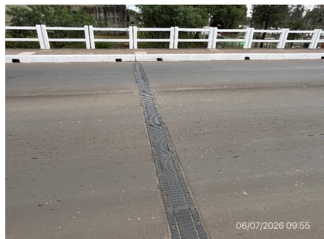
Foto 12.1-6, P01. Obras terminadas, sustitución de juntas transversales ejecutada.
