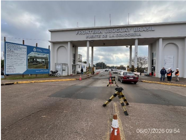
Foto 12.1-1, P01. Puente Internacional de la Concordia, Artigas – Quaraí. Acceso a ciudad de Artigas.
