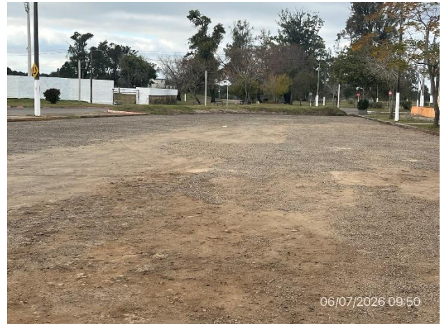
Foto 12.1-8, P02. Obrador desmontado, explanada con tratamiento bituminoso ejecutado permanece como mejora a conservar en beneficio de Intendencia de Artigas.
