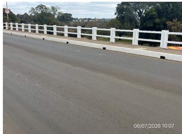
Foto 12.1-4, P01. Obras terminadas, rehabilitación de drenajes y pintura de barandas laterales ejecutadas.
