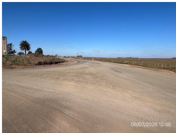
Foto 12.2-2, P03. Rotonda con base granular compactada ejecutada.
