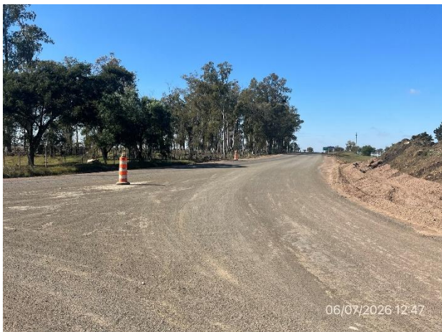
Foto 12.2-3, P03. Ramal de acceso al Ruta 30 con base granular compactada ejecutada.
