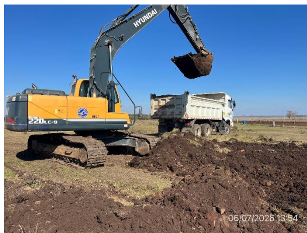
Foto 12.1-12, P06. Cantera granular, tareas de remoción de cobertura vegetal en ejecución.
