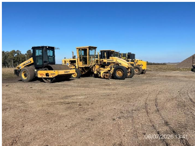
Foto 12.1-3, P06. Explanada para estacionamiento y maniobra de maquinaria. Buenas condiciones de orden y limpieza.
