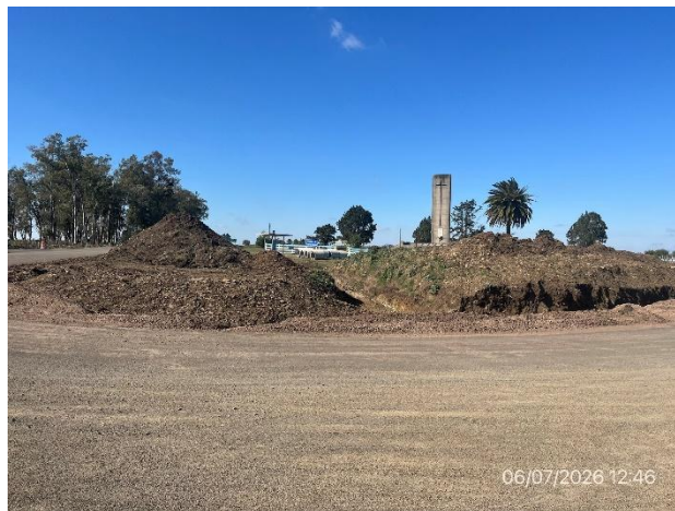
Foto 12.2-4, P03. Acopio de suelo pasto en faja pública para futura restauración ambiental de cunetas.
