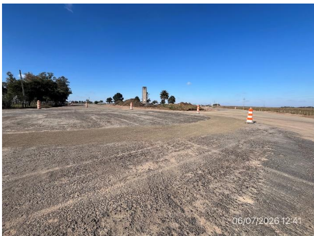
Foto 12.2-1, P03. Ramal Ruta 30, rotonda Itacumbú en ejecución.
