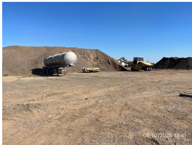
Foto 12.1-2, P06. Explanada para acopio de áridos. Buenas condiciones de orden y limpieza.
