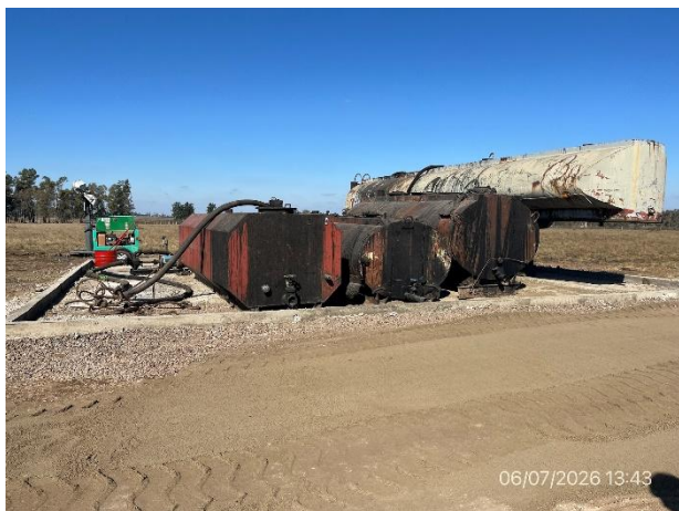
Foto 12.1-7, P06. Explanada de estacionamiento de cisternas de asfalto y emulsiones asfálticas.
