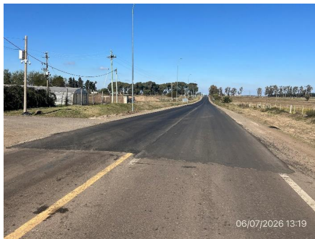
Foto 12.3-2, P01. Acceso a Tomás Gomensoro, tramo con carpeta de rodadura en carpeta asfáltica ejecutada.
