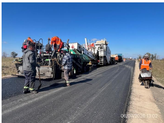
Foto 12.3-7, P05. Frente de obras, cuadrilla de tendido de mezcla asfáltica.
