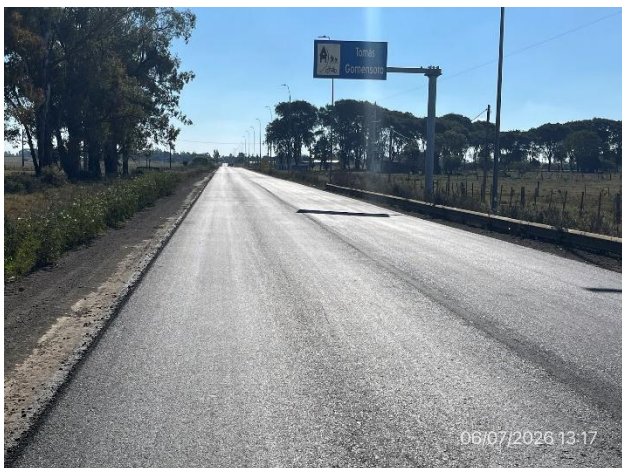
Foto 12.3-1, P01. Inicio de obras en Ramal Ruta 30, acceso a Tomás Gomensoro.
