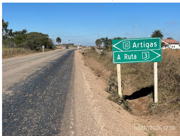
Foto 12.3-10, P02. Fin del tramo. Ramal Ruta 30, empalme con Ruta 30, Paraje Itacumbú.
