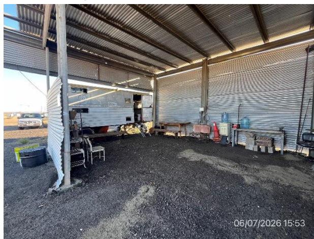
Foto 12.2-4, P04. Taller mecánico techado, está dotado de infraestructura para acopio de residuos.
