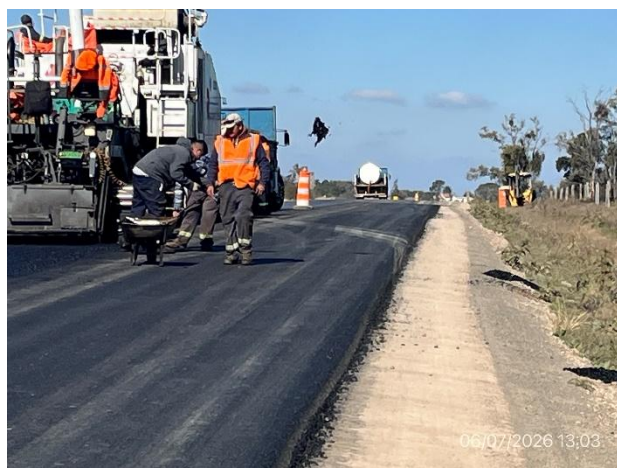
Foto 12.3-8, P05. Frente de obras. La cuadrilla de tendido retira al voleo los sobrantes de mezcla asfáltica, con escaso control de la zona de acopio de los sobrantes.
