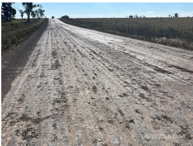
Foto 12.3-3. Ramal Ruta 30, tramo con base granular compactada cementada.
