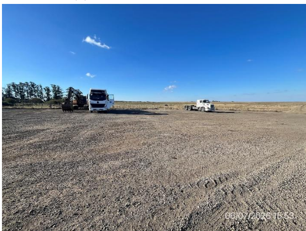
Foto 12.2-3, P04. Explanada de maniobras y estacionamiento de maquinaria, buenas condiciones de orden y limpieza.
