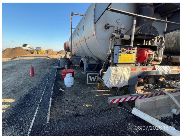
Foto 12.2-10, P04. Planta asfáltica, cuenta con envallado perimetral estanco, y pavimento de base granular.
