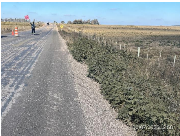
Foto 12.3-5, P05. Frente de obras. Ramal Ruta 30, progresiva 22K600.
