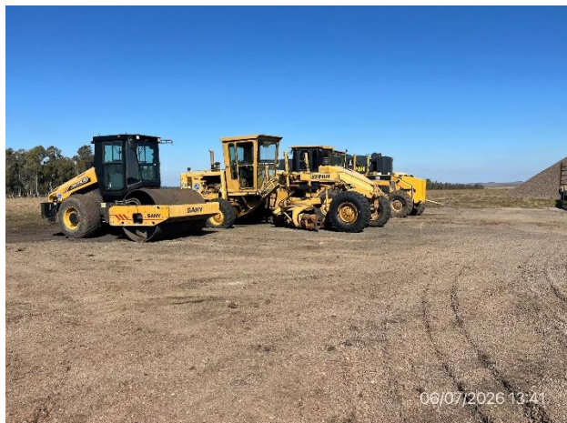
Foto 12.1-3, P03. Explanada para estacionamiento y maniobra de maquinaria. Buenas condiciones de orden y limpieza.
