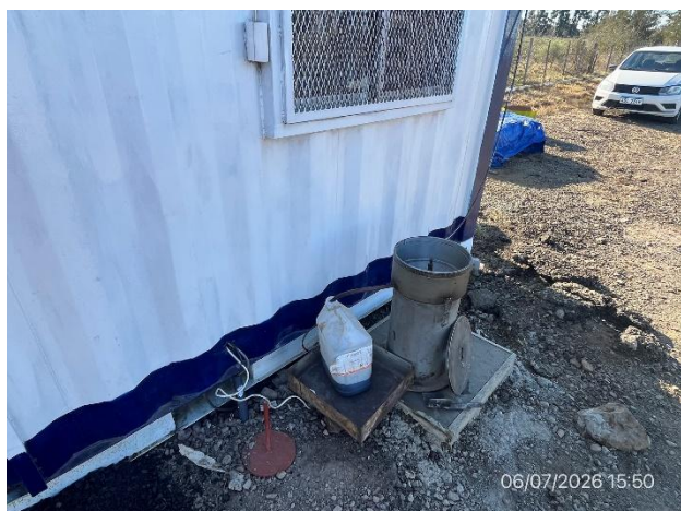
Foto 12.2-7, P04. Laboratorio de asfalto, la extracción de asfalto se hace sobre bandejas estancas, pero a la intemperie.
