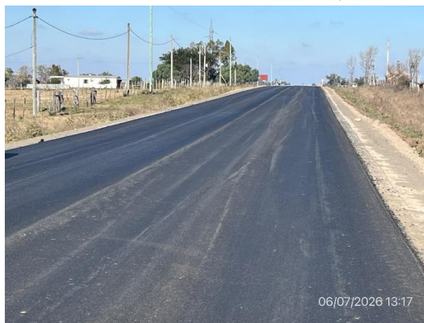
Foto 12.3-4. Ramal Ruta 30, tramo con carpeta de rodadura ejecutada en mezcla asfáltica.
