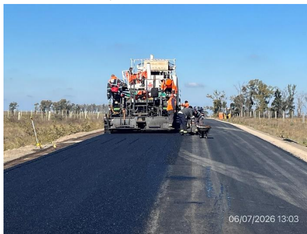
Foto 12.3-6, P05. Frente de obras, tendido de mezcla asfáltica en ejecución.
