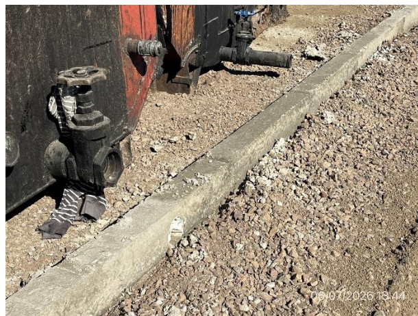
Foto 12.1-8, P03. Las cisternas de asfalto y emulsiones asfálticas están en un recinto con un envallado con desagües abiertos y con un pavimento permeable.
