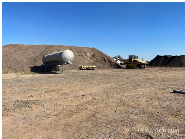
Foto 12.1-2, P03. Explanada para acopio de áridos. Buenas condiciones de orden y limpieza.
