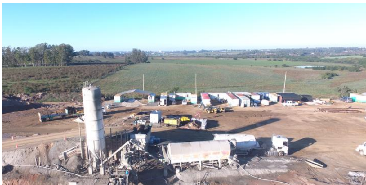
Obrador de mantenimiento padrón N°4.061
