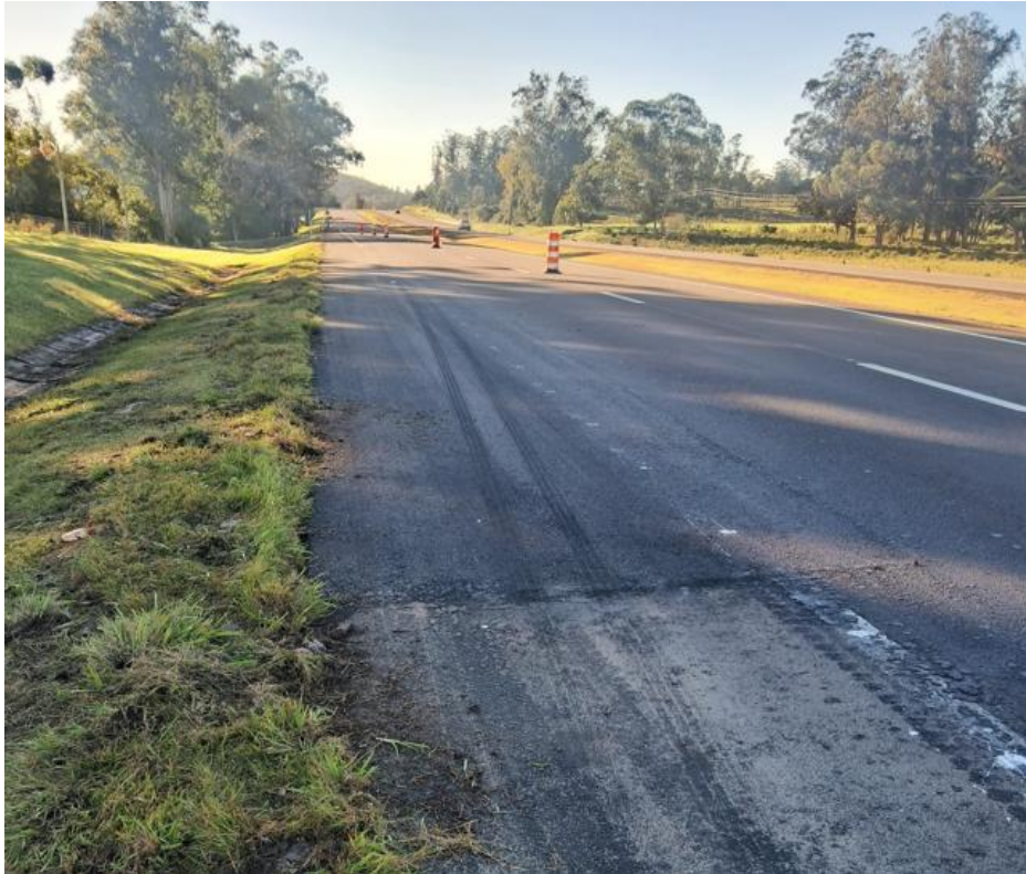
Ilustración 5: Bacheo en mezcla asfáltica, R9 km128.
