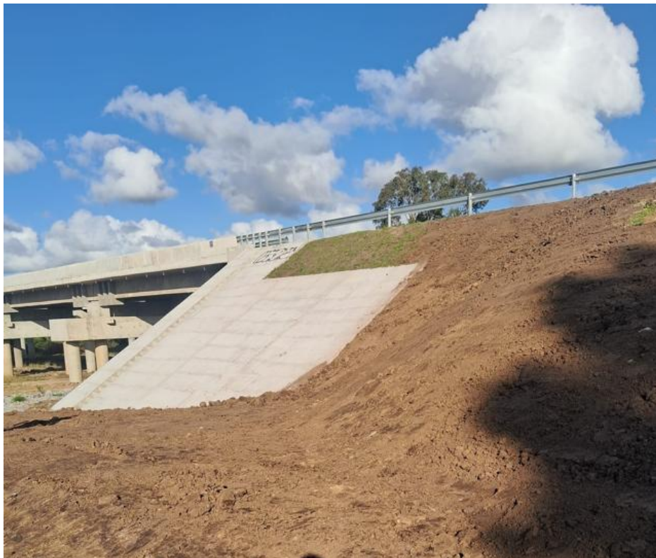
Ilustración 6: Taludes en puente A° San Carlos, R9 km139.400.
