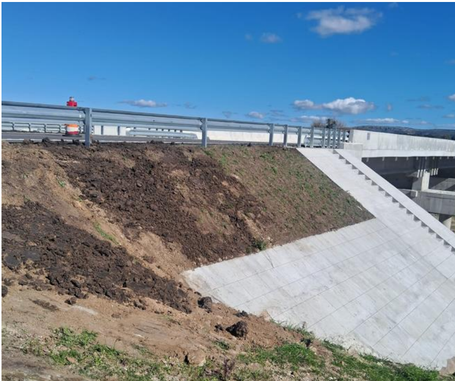
Ilustración 8: Taludes en puente A° Maldonado, R9 km133.900.
