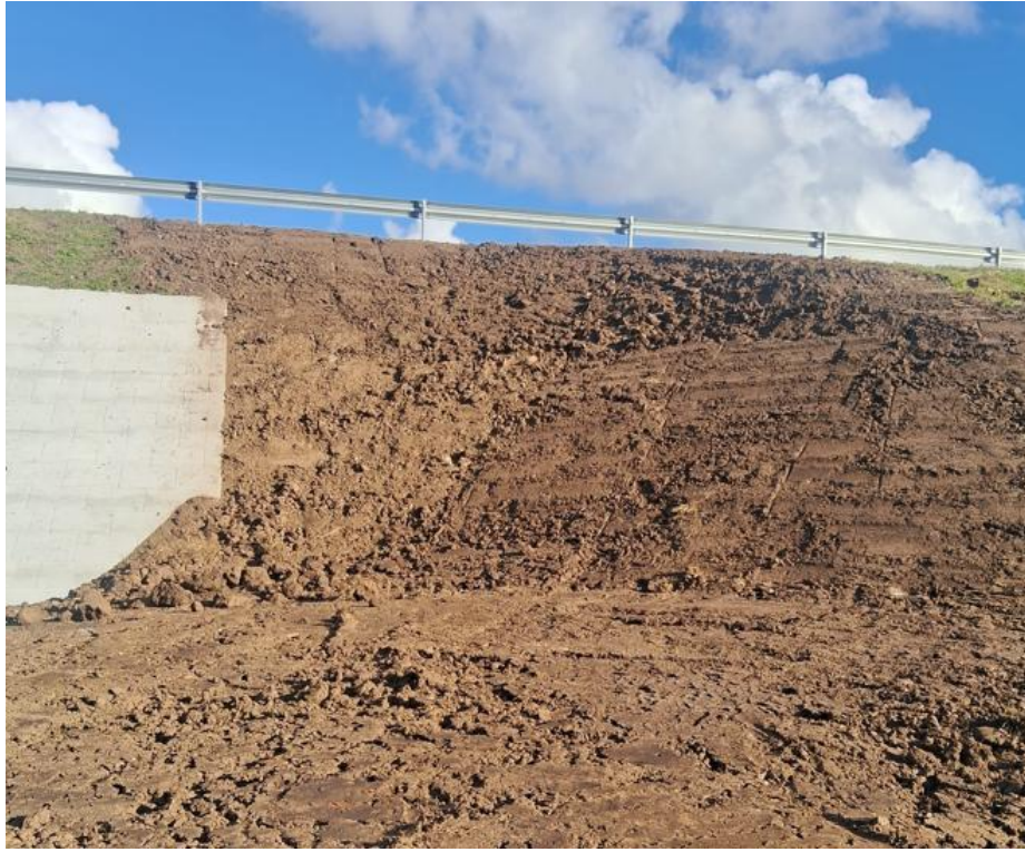
Ilustración 7: Taludes en puente A° San Carlos, R9 km139.400.
