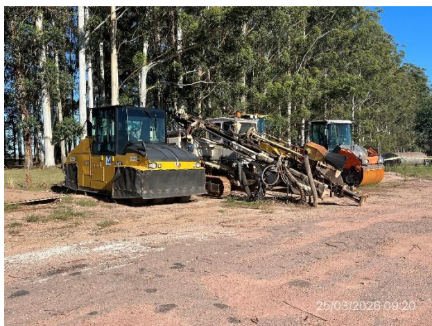
Foto 12.1-3, P03. Obrador sin actividad, estacionamiento de maquinaria ordenado sin residuos.
