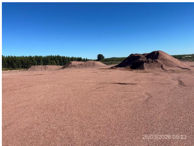
Foto 12.1-5, P03. Obrador. Acopio de material triturado para futuras tareas.
