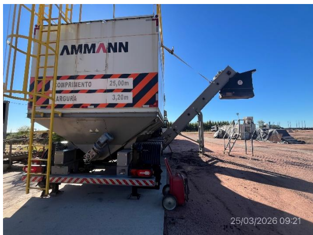
Foto 12.1-7, P03. Planta asfáltica, plataforma de acceso y maniobras limpia y ordenada.
