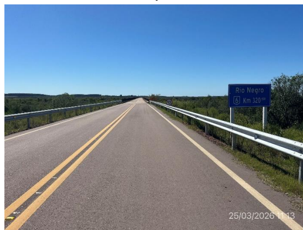
Foto 12.2-7, P02. Fin del tramo, Ruta 6 progresiva 320K000.
