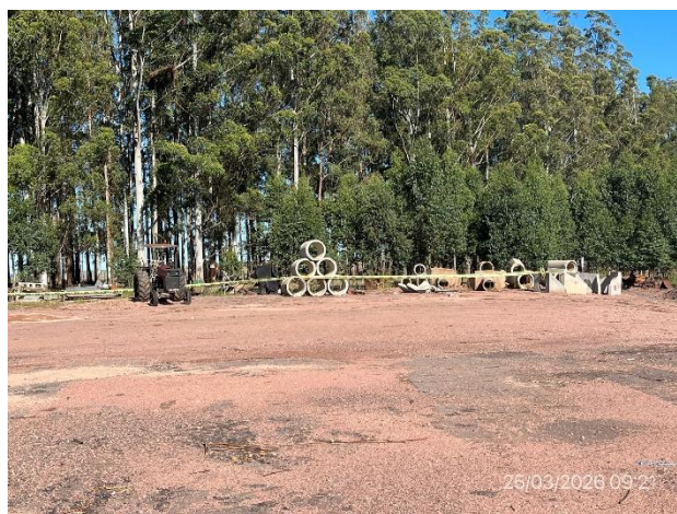
Foto 12.1-4, P03. Obrador, plataforma de maniobras en buenas condiciones.
