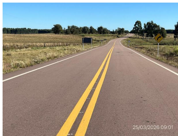
Foto 12.2-2, Ruta 6. Obras terminadas, carpeta asfáltica ejecutada.
