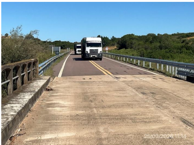
Foto 12.2-8, P02. Fin del tramo, acceso Sur al puente del Km. 329 sobre el Río Negro, abierto al tránsito pesado.
