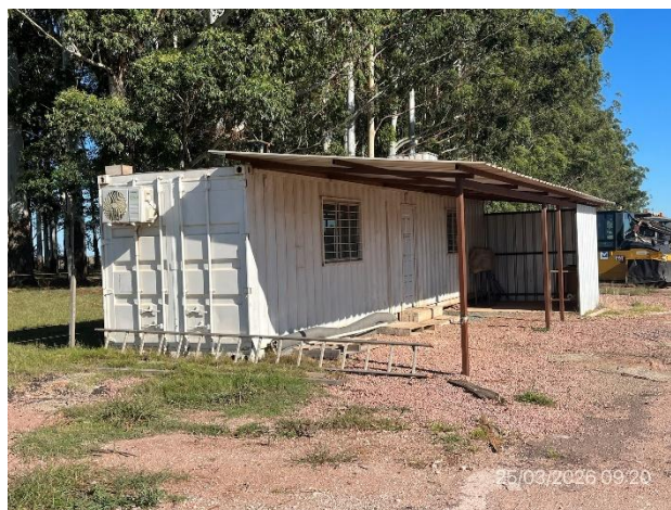
Foto 12.1-2, P03. Obrador sin actividad, sector limpio y ordenado.
