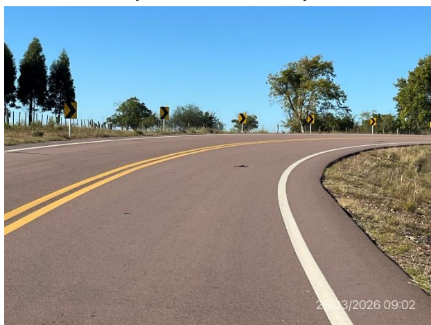
Foto 12.2-5, 6, Ruta 6. Obras terminadas, señalización vertical ejecutada.
