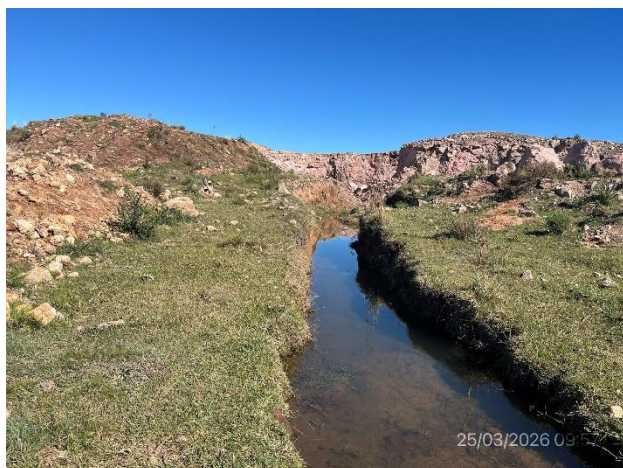
Foto 12.1-11, P04. Cantera de piedra, drenaje de pluviales hacia tajamar natural.
