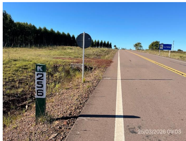
Foto 12.2-4, Ruta 6. Obras terminadas, señalización vertical ejecutada.
