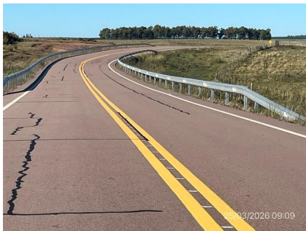
Foto 12.2-3 Ruta 6. Obras terminadas, señalización horizontal y defensas metálicas ejecutadas.
