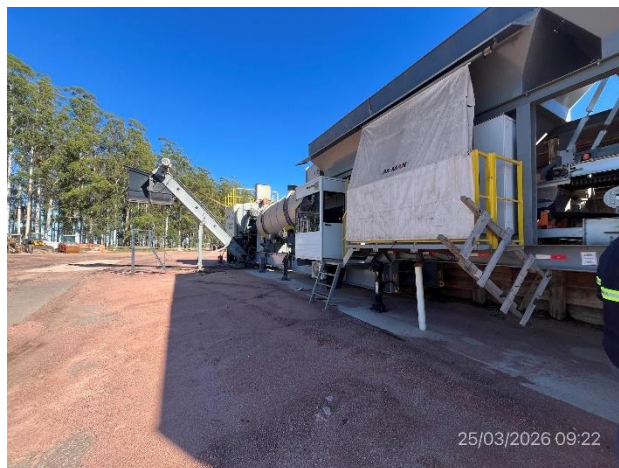
Foto 12.1-6, P03. Planta asfáltica sin actividad.
