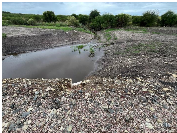
Foto 12.1-5, P08. Alcantarilla en Ruta 26 progresiva 415K100.
