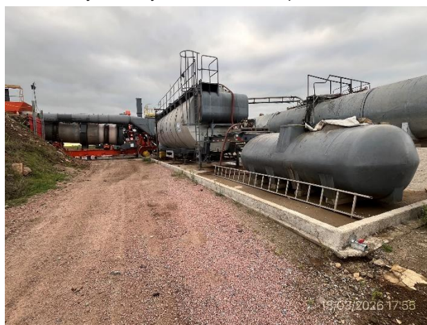
Foto 12.2-10, P03. Planta asfáltica. Envallado perimetral correcto en torno a cisternas de asfalto.
