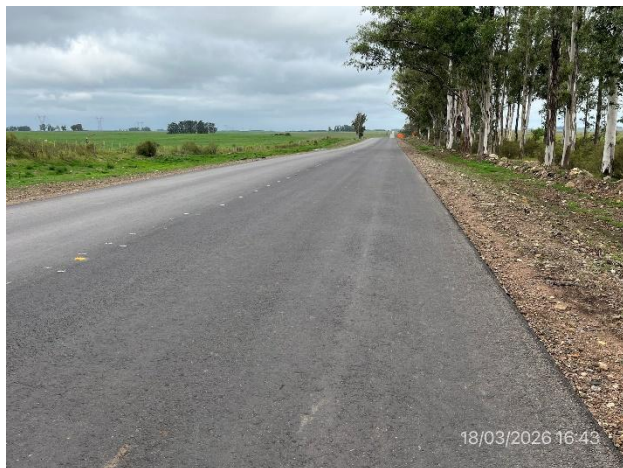
Foto 12.1-1, P01. Inicio de tramo, Ruta 26 progresiva 398K000.
