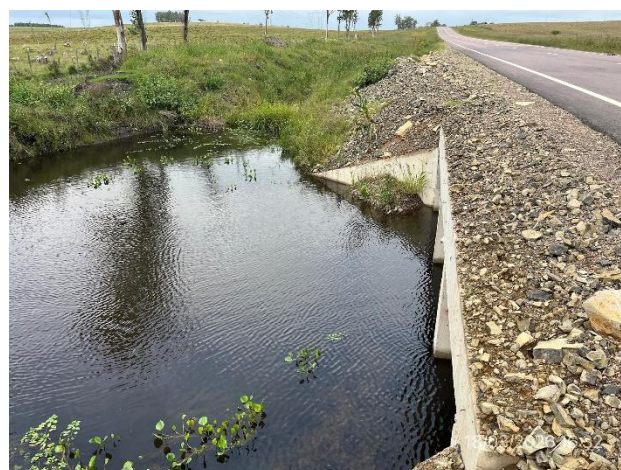
Foto 12.1-10, P05. Alcantarilla abierta al tránsito. Ruta 26 progresiva 407K000.
