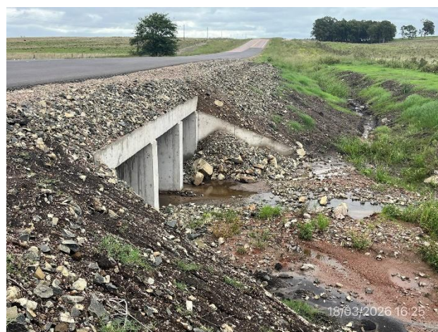
Foto 12.1-8, P06. Alcantarilla abierta al tránsito. Ruta 26 progresiva 411K200.
