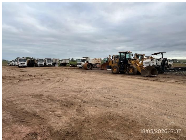
Foto 12.2-2, P03. Obrador, explanada de maniobras y estacionamiento de maquinarias.
