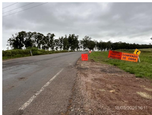
Foto 12.1-12. P02. Fin del tramo, Ruta 26 Progresiva 417K000. Empalme con Ruta 7.
