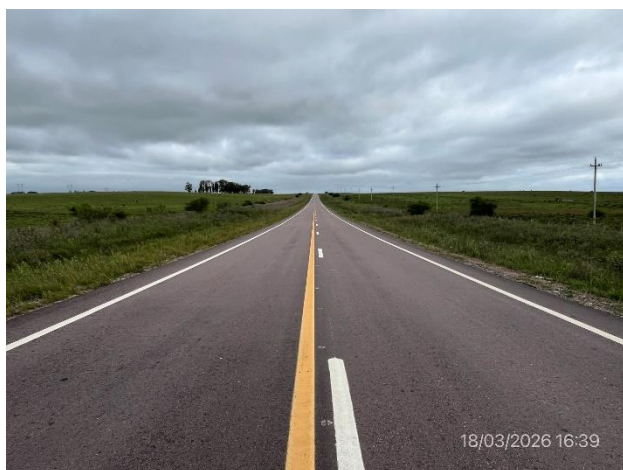
Foto 12.1-3. Sector de Ruta 26 con señalización horizontal terminada.
