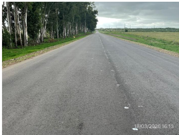
Foto 12.1-2, Ruta 26. Obra terminada con nueva calzada ensanchada en mezcla asfáltica.
