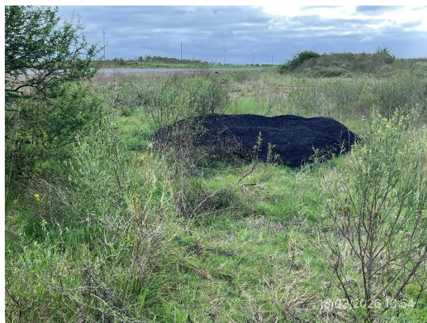
Foto 12.1-6, Faja pública de Ruta 26. Se descargó mezcla asfáltica sobre el suelo natural.
