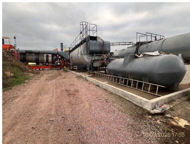
Foto 12.2-10, P03. Planta asfáltica. Envallado perimetral correcto en torno a cisternas de asfalto.
