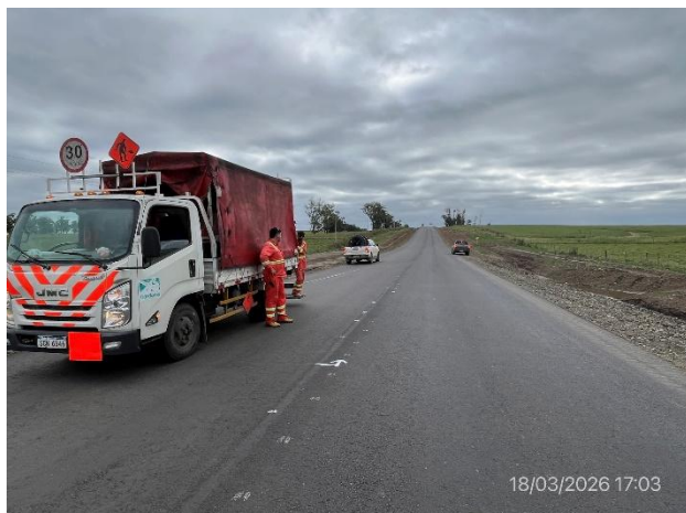
Foto 12.1-7, P05. Frente de obras de señalización horizontal, Ruta 26 progresiva 387K400.
