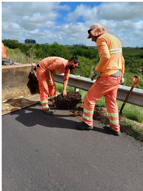
Foto 12.3-1, Faja Pública de Ruta 26. La empresa retiró los restos de mezcla asfáltica en la faja pública bajo los flex beam.
