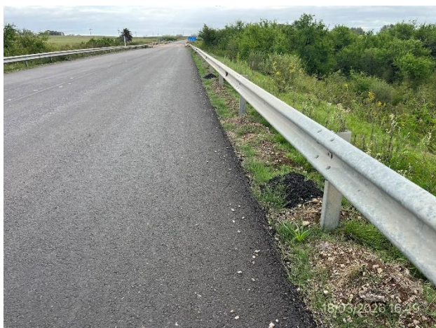
Foto 12.1-5, Ruta 26. Tramo con defensas metálicas instaladas, hay restos de mezcla asfáltica sobre el suelo natural, pendiente de disposición final.
