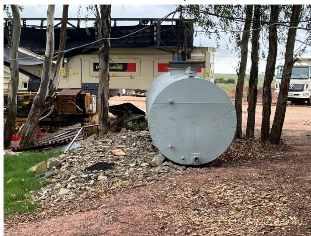
Foto 12.2-6, P03. Obrador, reservorio de agua potable proveniente de agua de libre disponibilidad de tajamar.
