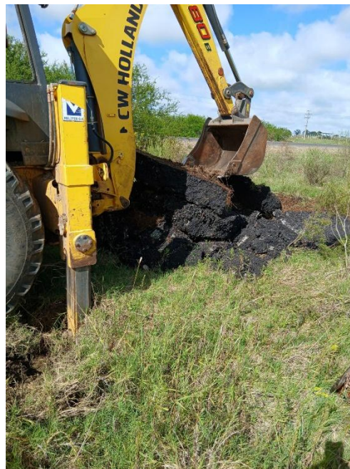
Foto 12.3-2, Faja pública de Ruta 26. La empresa retiró los restos de mezcla asfáltica en la faja pública sobre suelo vegetal
