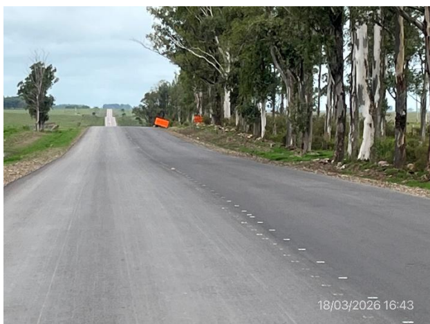
Foto 12.1-3. Sector de Ruta 26 con calzada en mezcla asfáltica ejecutada.
