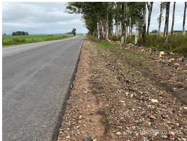
Foto 12.1-2, Ruta 26. Tramo con calzada ejecutada, banquetas pendientes de ejecución.
