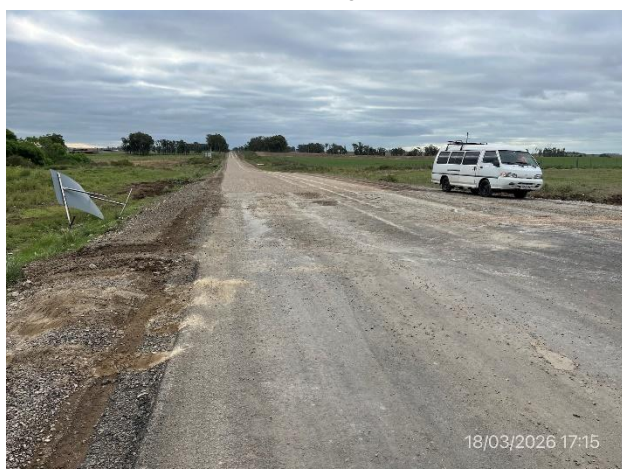
Foto 12.1-9, P01. Inicio de tramo, Ruta 26 progresiva 383K300.
