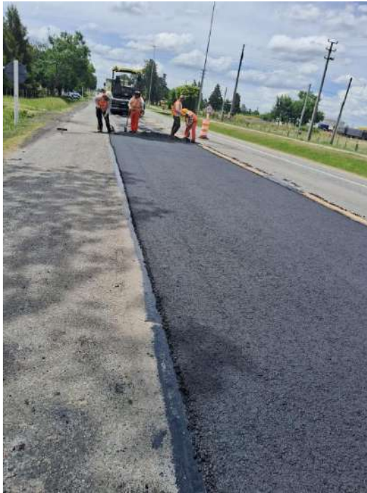
Imagen N°6 y 7: Reparaciones por rotura de calzada.
