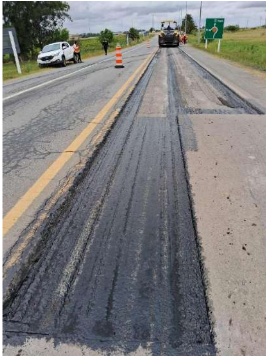
Imagen N°10 y 11: Bacheo parcial en calzada de rutas 2. Tareas extraordinarias de mantenimiento (TEM).
