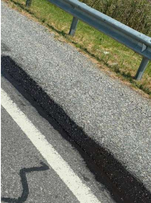
Imagen N°14 y 15: Reparaciones de banquina puntuales con tratamiento bituminoso simple en Ruta 2.
