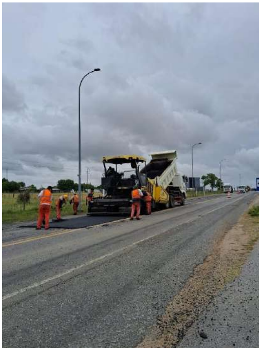
Imagen N°8 y 9: Reparaciones por rotura de calzada.
