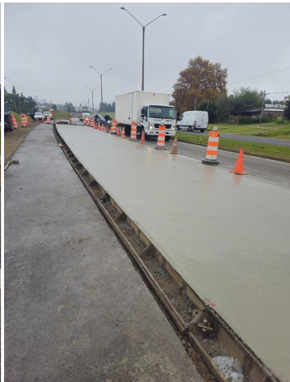
Bacheo de hormigón (R8 km 18) y corte de paso (ruta 102 km 39) - Registro fotográfico realizado por personal de Colier 05/2026.
