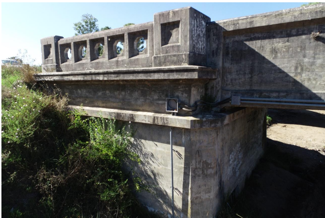
Figura 3-10: Puente arroyo José Ignacio previo a su demolición. Febrero 2024.
