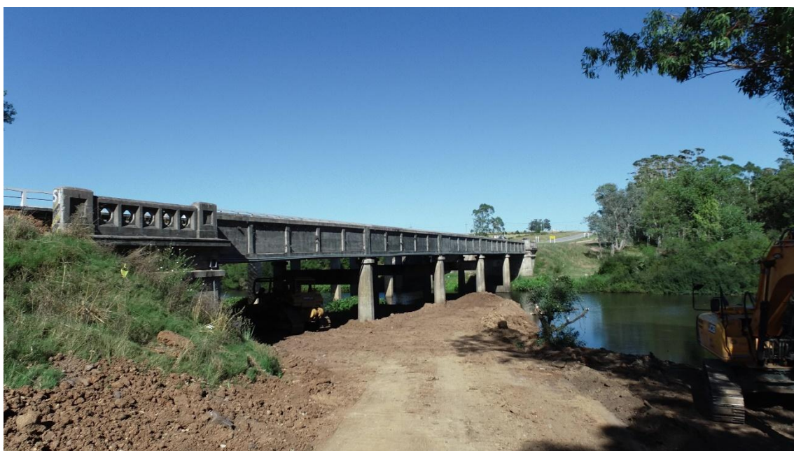
Figura 3-9: Puente arroyo José Ignacio previo a su demolición. Febrero 2024.
