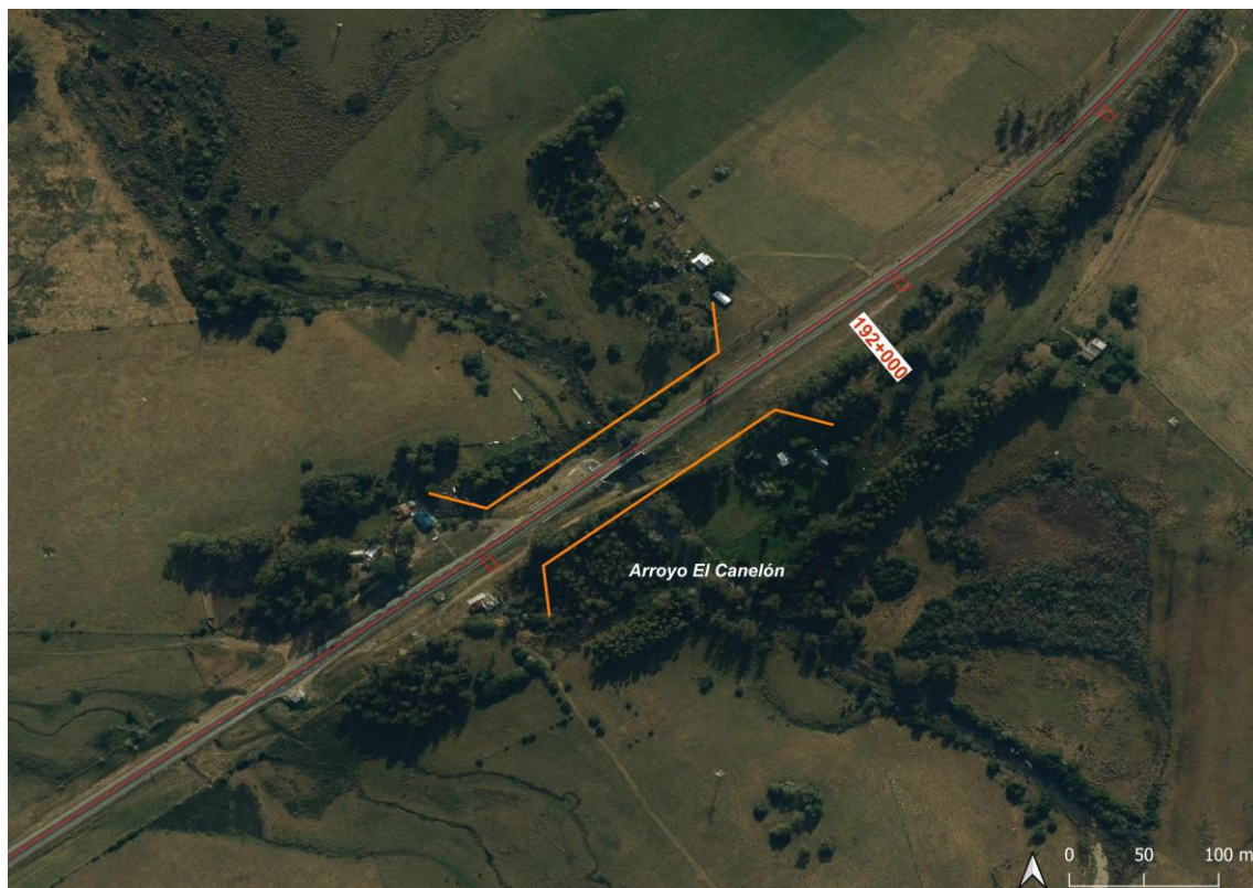
Figura 3-16: Puente arroyo El Canelón
