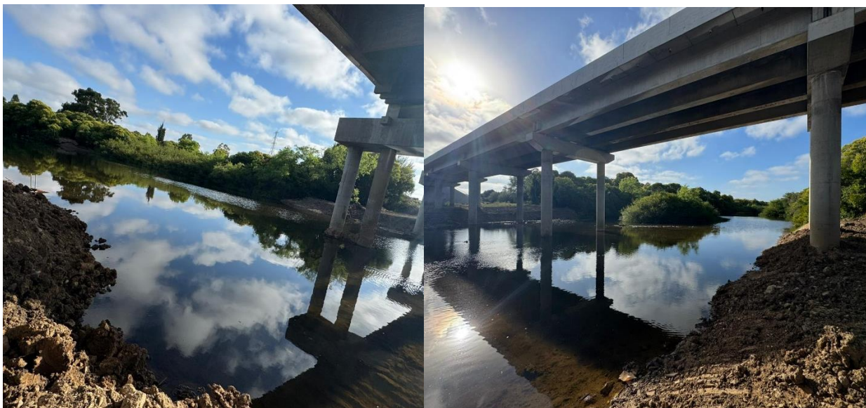
Registro fotográfico aguas arriba y aguas abajo del cauce de Arroyo San Carlos.
