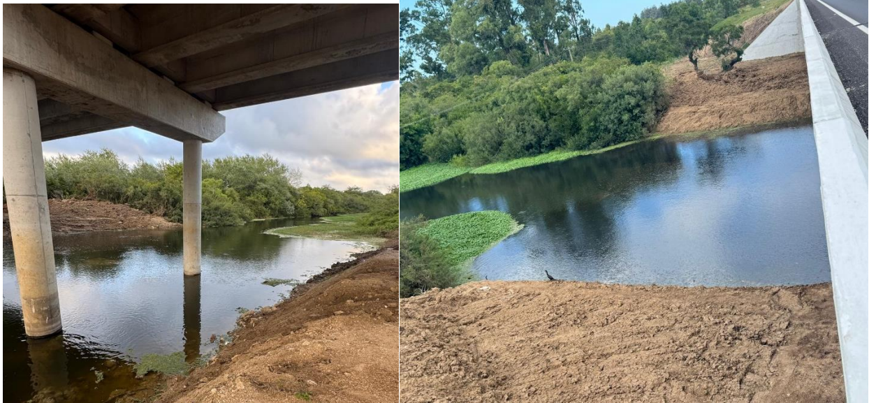
Registro fotográfico aguas arriba y aguas abajo del cauce de Arroyo Rocha.
