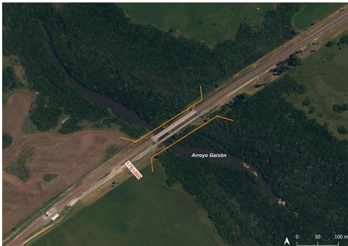
Figura 3-12: Puente arroyo Garzón.
