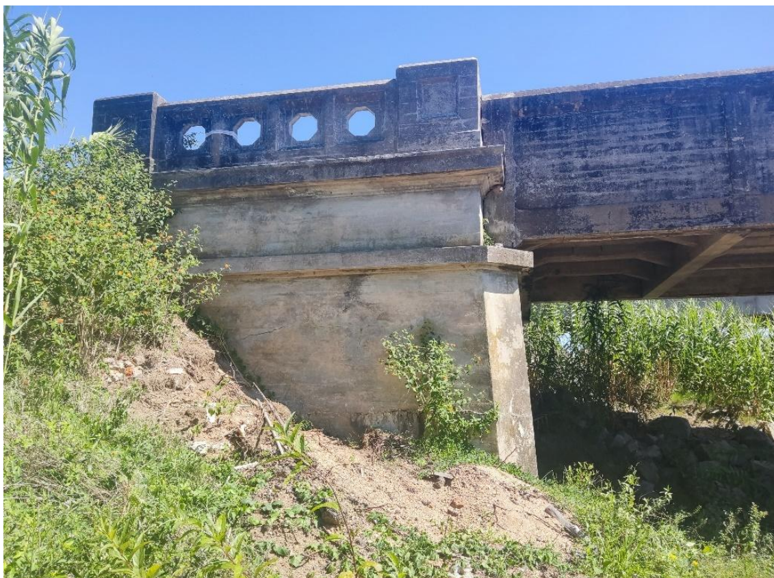
Figura 3-14: Puente arroyo José Garzón previo a su demolición.
