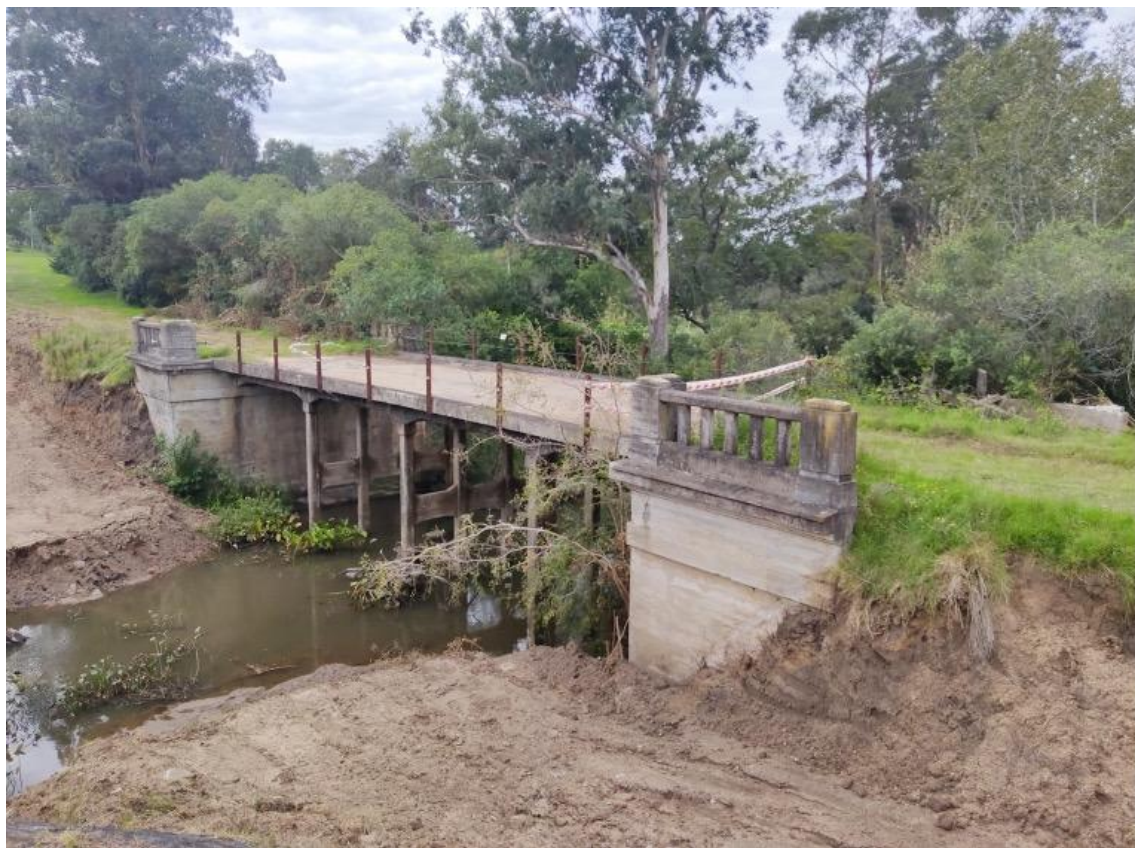
Figura 3-17: Vista de puente viejo en arroyo El Canelón en progresiva 191.800. 11 de abril de 2023.
