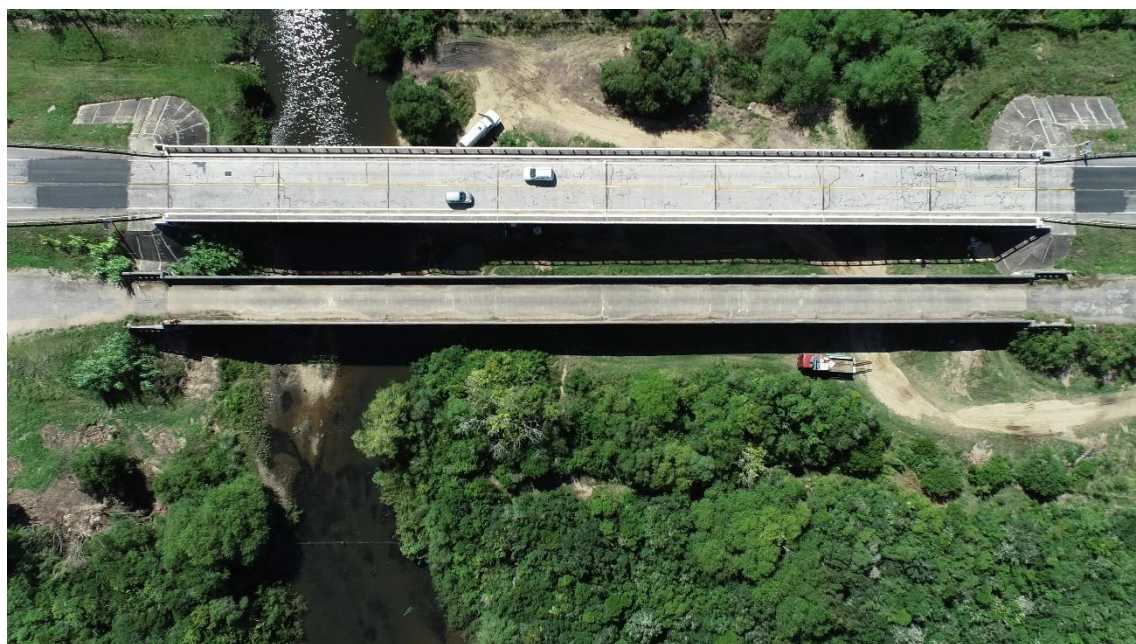
Figura 3-13: Puente arroyo José Garzón previo a su demolición (puente inferior de la imagen).
