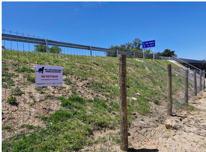
Ilustración 4: Vallado puente sobre A° José Ignacio.
