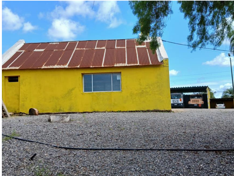
Ilustración 5: Retiro de contenedores de oficina y laboratorio.
