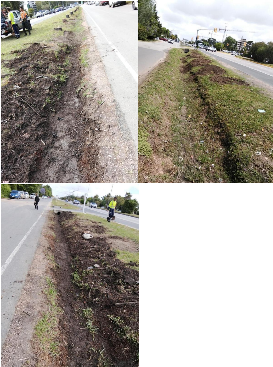
Reacondicionamiento de cuneta en Av. De las Américas – Noviembre 2025 / enero 2026
