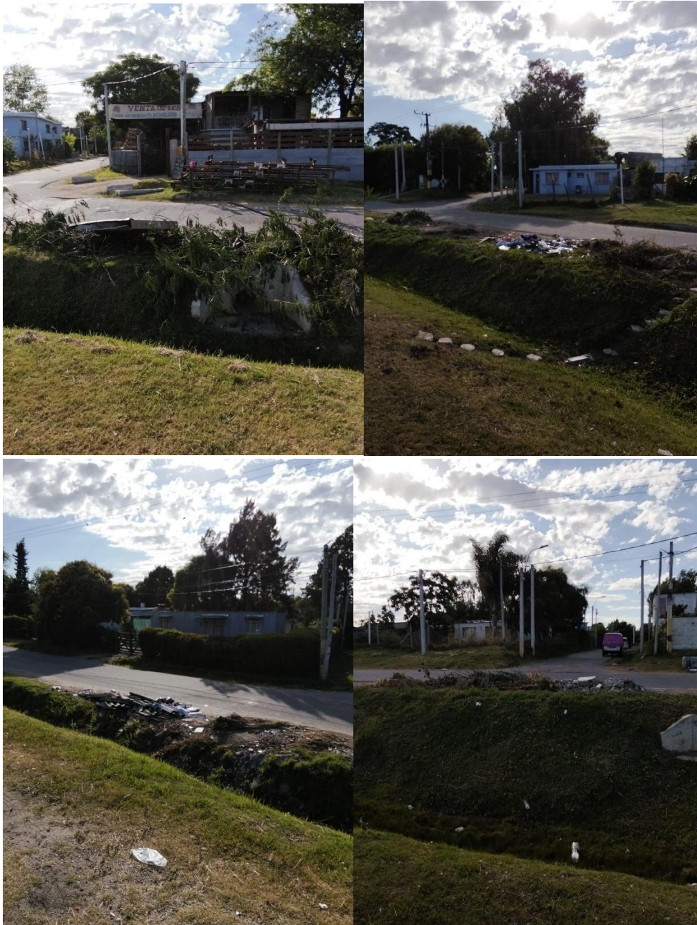
Limpieza de basural informal sobre lateral de Ruta Interbalnearia – Noviembre 2025 / enero 2026
