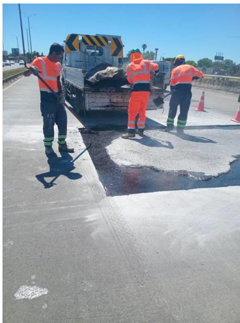
Colocación de mezcla asfáltica sobre calzada de puente
