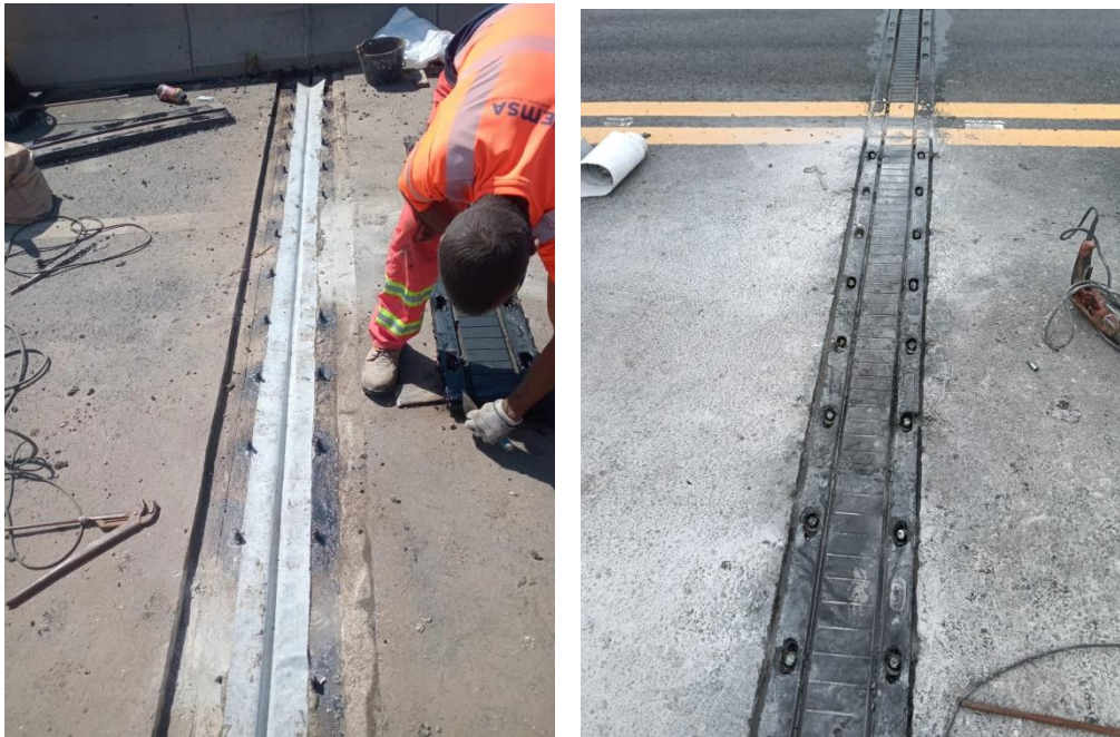
Mantenimiento de junta de dilatación en puente
