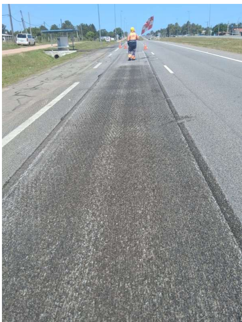
Fresado de huellas
