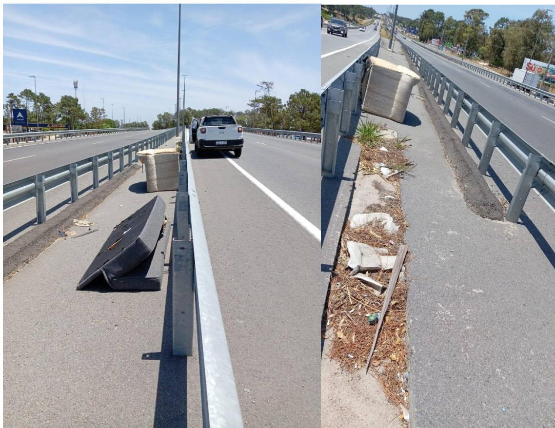
Retiro de residuos voluminosos en faja y calzada de la Ruta Interbalnearia – noviembre 2025 / enero 2026.
