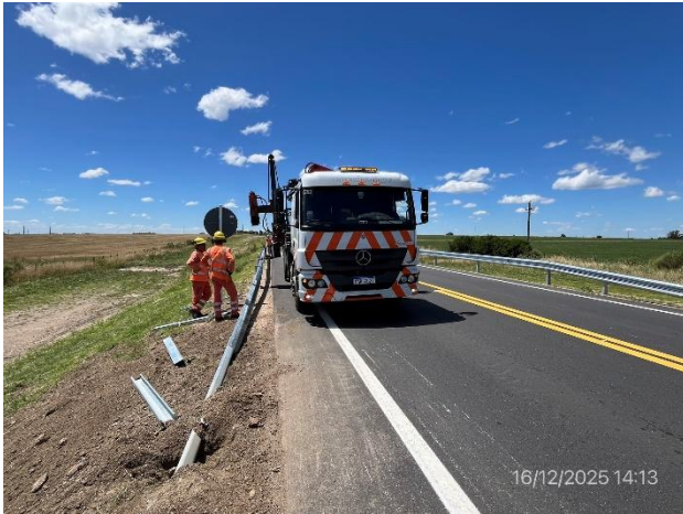
Foto 12.1-7, P06. Frente de obra de señalización. Ruta 45 progresiva 70K100 a (-). Ejecución de defensas metálicas en proceso.
