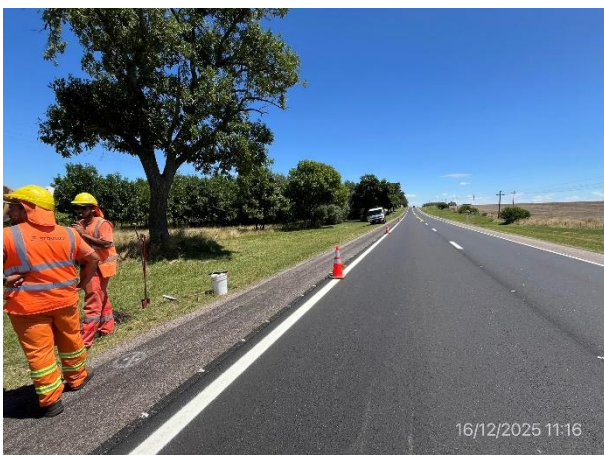
Foto 12.1-5, P04. Frente de obras, buenas condiciones de orden y limpieza.
