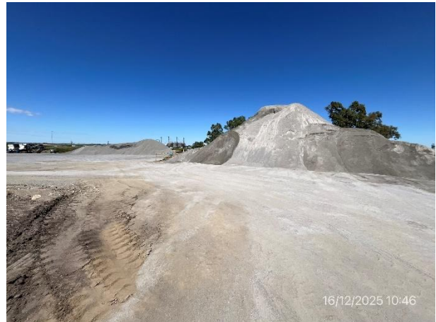
Foto 12.2-2, P03. Explanada para acopio de áridos. Buenas condiciones de orden y limpieza.
