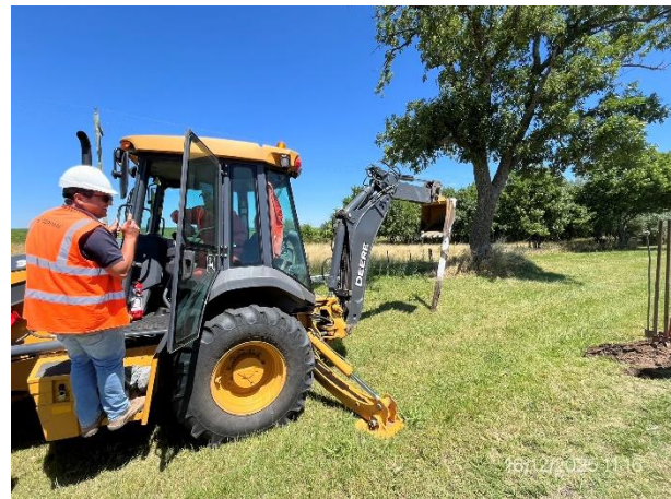
Foto 12.1-4, P04, Ruta 2 progresiva 199K900. Frente de obras de señalización vertical.
