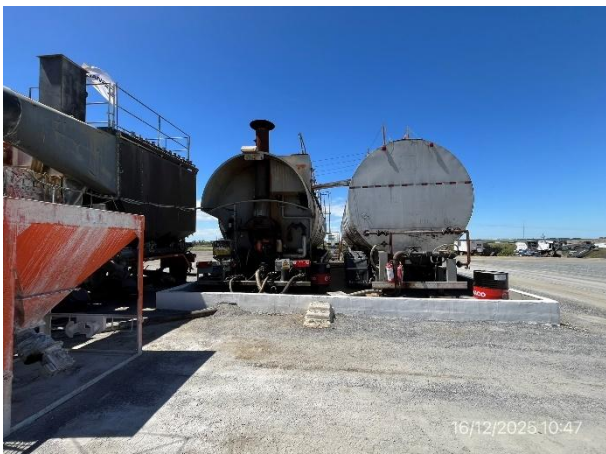
Foto 12.2-5, P03. Planta de asfalto, sistemas de asfalto con envallado perimetral correcto
