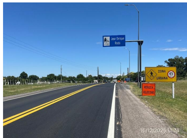
Foto 12.1-6, P02. Fin del tramo, acceso Sur a J.E. Rodó. Ruta 2 progresiva 207K000.
