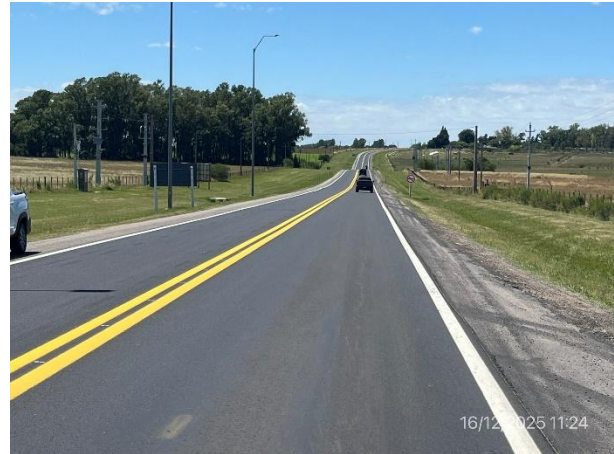
Foto 12.1-2. Tramo de Ruta 2 con recapado terminado en calzada y obras de señalización terminadas.
