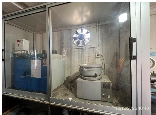
Foto 12.2-6, P03. Planta de asfalto, laboratorio de asfalto. Sector de recuperación de asfaltos alojado en recinto estanco.
