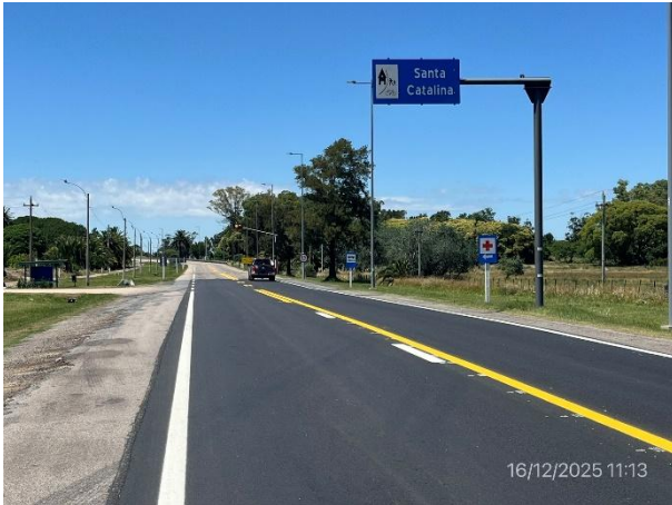
Foto 12.1-1, P01. Inicio de tramo, acceso Norte a Sta Catalina. Ruta 2 progresiva 197K600.
