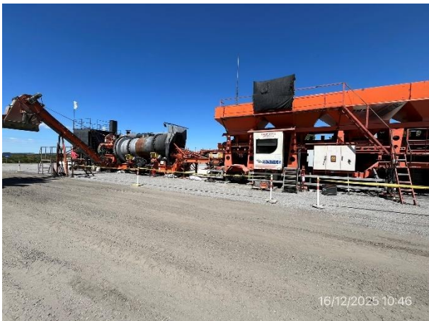
Foto 12.2-3, P03. Planta asfáltica, buenas condiciones de orden y limpieza. La zona está libre de derrames.
