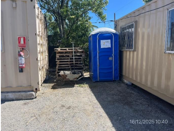
Foto 12.2-7, P03. Obrador, servicios higiénicos temporales.
