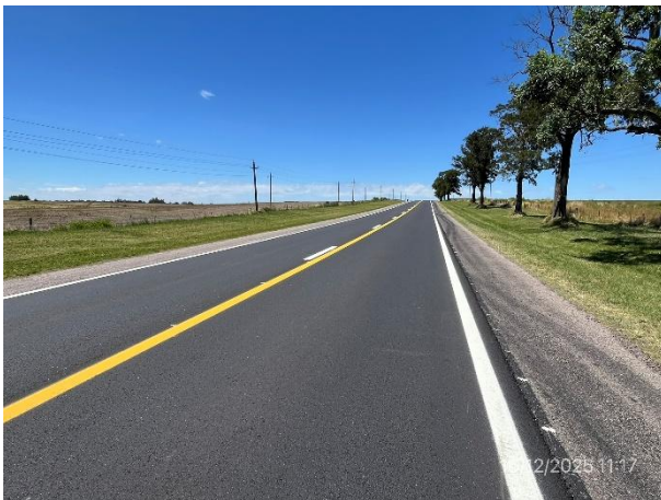
Foto 12.1-3. Tramo de Ruta 2, drenaje de banquina correctamente conformado. La faja pública está en buenas condiciones.
