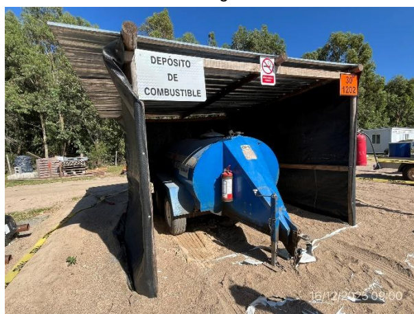
Foto 12.2-6, P03. Obrador, recinto envallado y techado alojando tanque móvil de combustible.
