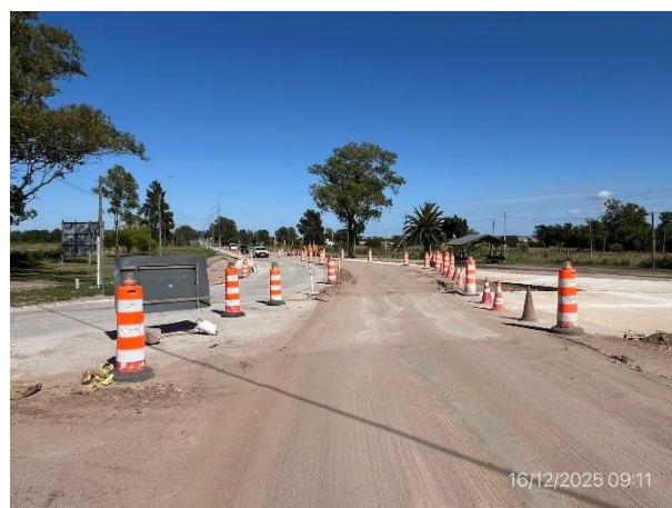
Foto 12.1-6, P02. Fin del tramo, nueva rotonda en construcción. Señalización provisoria correcta.
