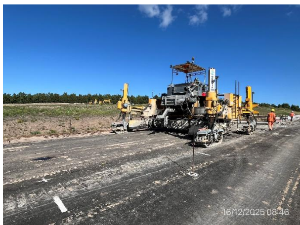
Foto 12.1-3, P05. Frente de obra, bypass de Ruta 3, progresiva 190K000. actividades preparatorias de tendido de calzada de hormigón. Zona limpia, libre de residuos.
