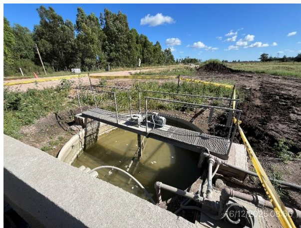
Foto 12.2-4, P03. Planta de hormigón, tanque de recirculación de aguas de lavado de camiones de hormigón
