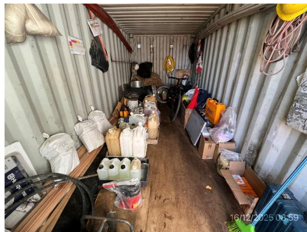
Foto 12.2-8, P03. Obrador, recinto cerrado con lubricantes alojados sobre bandejas estancas.
