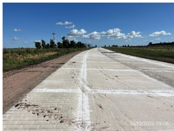
Foto 12.1-4. Nuevo bypass, tramo con calzada y banquetas en hormigón ejecutadas.
