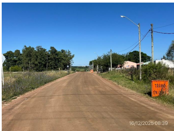
Foto 12.1-1, P01. Inicio de tramo, acceso Sur al bypass de Ruta 3. Tramo con subbase granular ejecutada
