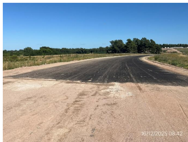
Foto 12.1-2. Nuevo bypass, tramo con base granular cementada, preparada para ejecutar calzada en hormigón.
