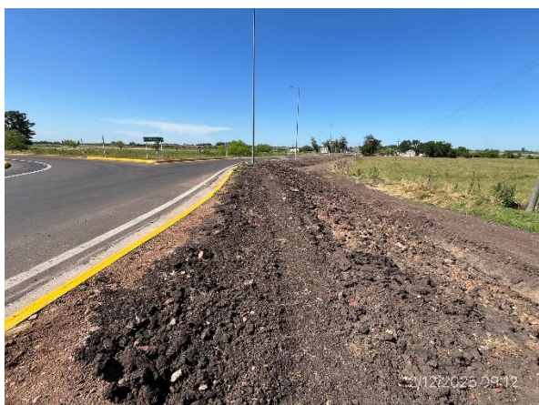
Foto 12.1-5, P01. Accesos a puente sobre A° Pedernal, faja pública a (-), drenaje y conformación correctos.
