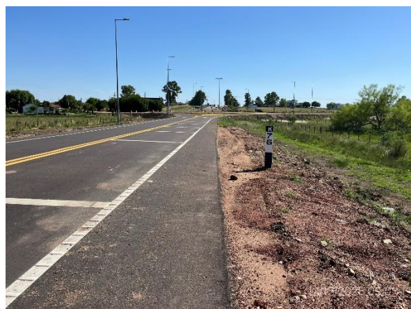
Foto 12.1-6, P01. Accesos a puente sobre A° Pedernal, faja pública a (+), falta culminar conformación de cuneta.
