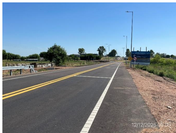
Foto 12.1-8, P01. Accesos a puente sobre A° Pedernal, carpeta de rodadura en mezcla asfáltica y obras de señalización terminadas.
