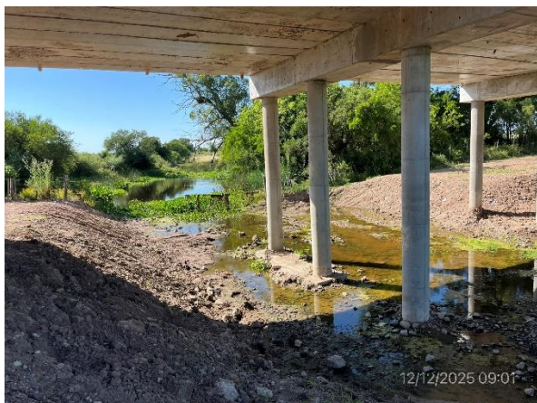
Foto 12.1-3, P01. La ataguía provisional fue removida. A° Pedernal con escurrimiento reducido durante el estío.
