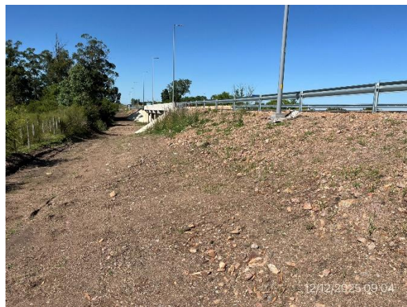
Foto 12.1-4, P01. Taludes de acceso con pendientes suaves y empastado vegetal en crecimiento.
