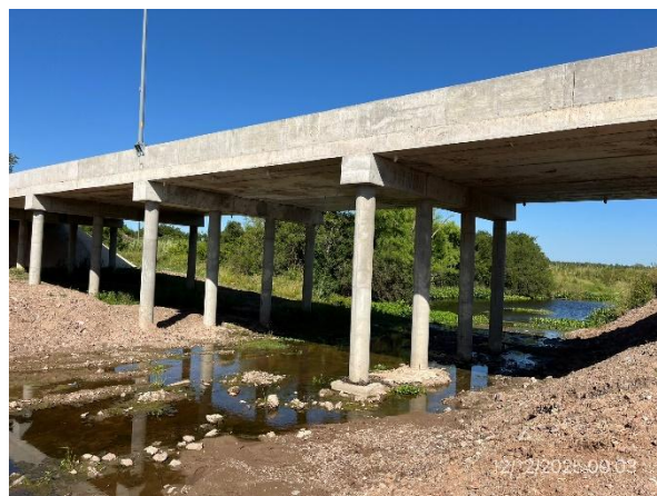
Foto 12.1-2, P01. Estructura en hormigón armado del puente sobre A° Pedernal terminada.
