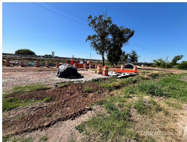
Foto 12.2-6, P02. Se colocó cerramiento superior desmontable en pileta de lavado de camiones mixer previamente vaciada.
