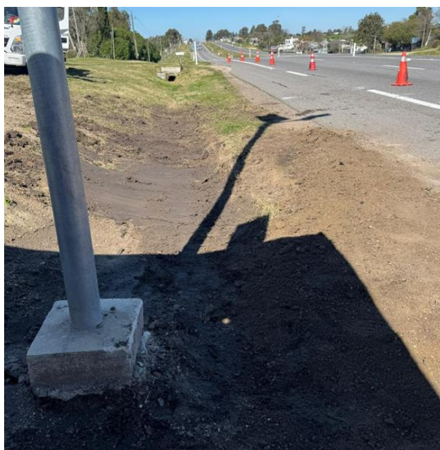
Ilustración 2: Limpieza de cuneta.
