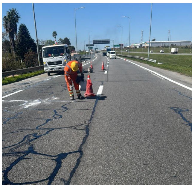
Ilustración 1: Sellado de fisuras.
