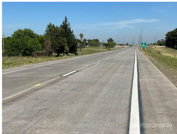
Foto 12.3-4, Av. de las Américas. Tramo en vía simple con calzada en Whitetopping terminada.
