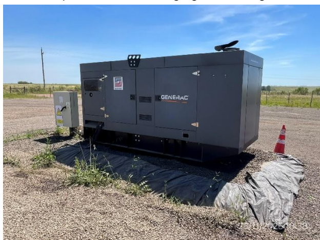
Foto 12.2-9, P04. Planta asfáltica, el generador tiene su envallado perimetral correcto.
