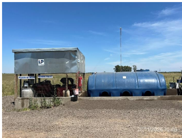
Foto 12.2-8, P04. Planta asfáltica, tanque de combustible y acopio de lubricantes con envallados correctos y parcialmente techado.
