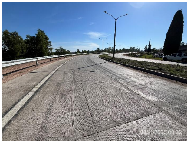
Foto 12.3-2, Av. de las Américas. Tramo en doble vía con calzada en Whitetopping terminada en ambas sendas.
