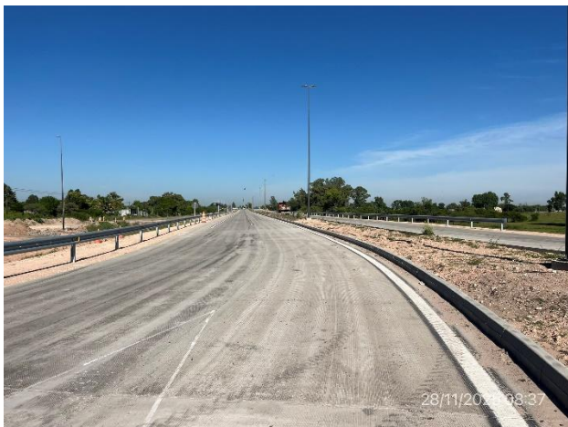
Foto 12.3-3, Av. de las Américas. Obras de señalización y de defensas metálicas ejecutadas.
