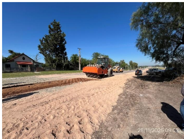
Foto 12.3-8, P07. Frente de obras en calle lateral. Tareas de recargo granular y compactación en ejecución.
