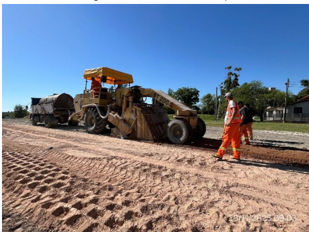
Foto 12.3-9, P07. Frente de obras en calle lateral, cementado de base granular en ejecución.
