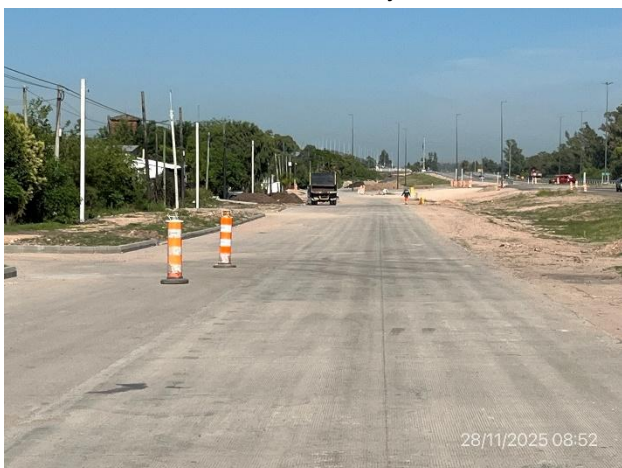
Foto 12.3-5, Av. de las Américas. Tramo de calle lateral senda a (-) con calzada en hormigón terminada.
