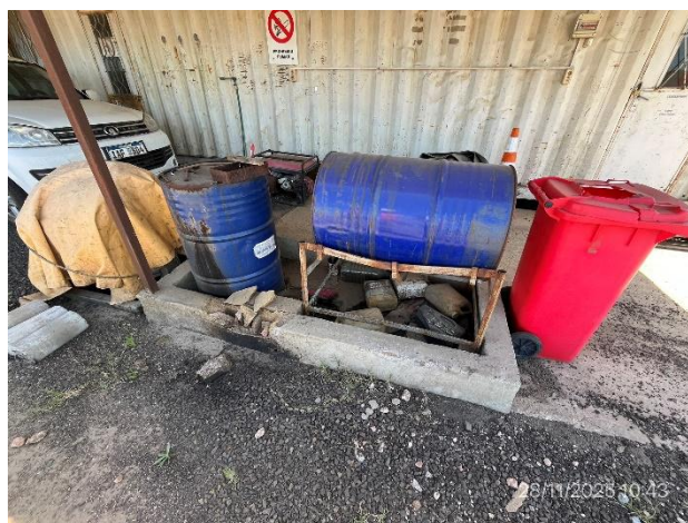
Foto 12.2-12, P04. Laboratorio de asfaltos, el envallado perimetral de acopio de productos químicos está dañado.
