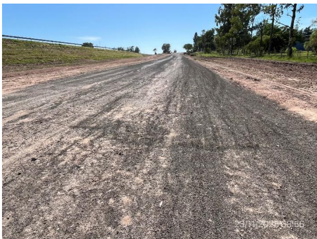
Foto 12.3-7, P07. Frente de obras en calle lateral. Sector con base granular cementada e imprimada.
