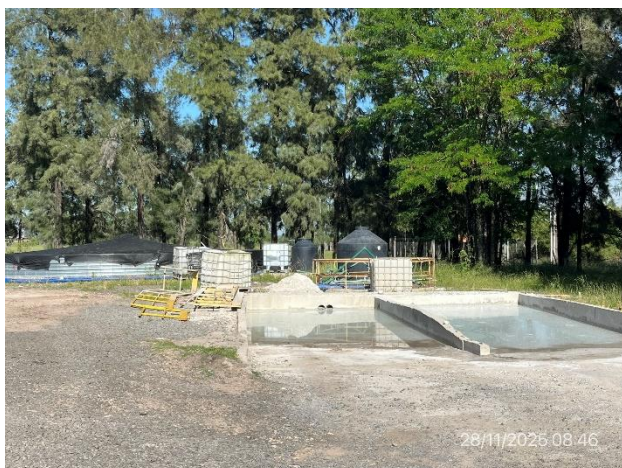
Foto 12.1-5, P03. Pileta de lavado de camiones a demoler. Está pendiente la recuperación ambiental del predio
