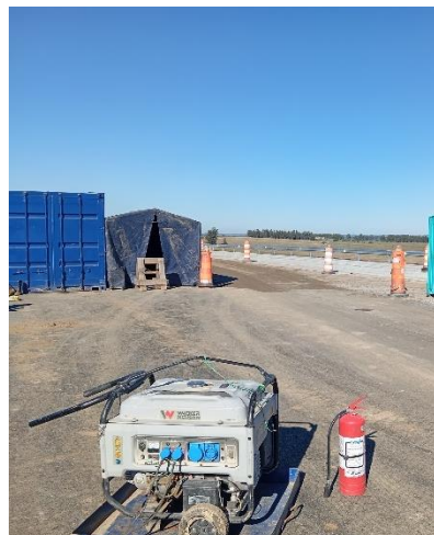
Figura 3-11 Imágenes de kit antiderrame y generadores sobre bandejas de contención.
