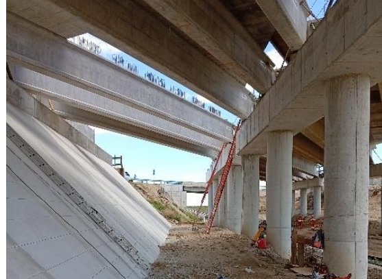
Figura 2-7 Imágenes de las tareas de construcción de bases, pilares, dinteles y montaje de vigas en el puente definitivo.
