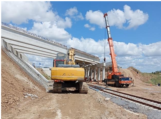
Figura 2-7 Imágenes de las tareas de construcción de bases, pilares, dinteles y montaje de vigas en el puente definitivo.
