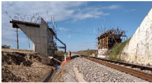
Figura 2-5 Imágenes de las tareas de construcción de bases y muros en el puente provisorio.
