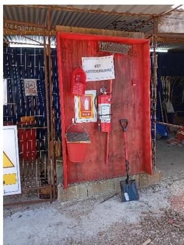
Figura 3-11 Imágenes de kit antiderrame y generadores sobre bandejas de contención.
