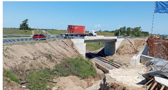
Figura 2-5 Imágenes de las tareas de construcción de bases y muros en el puente provisorio.
