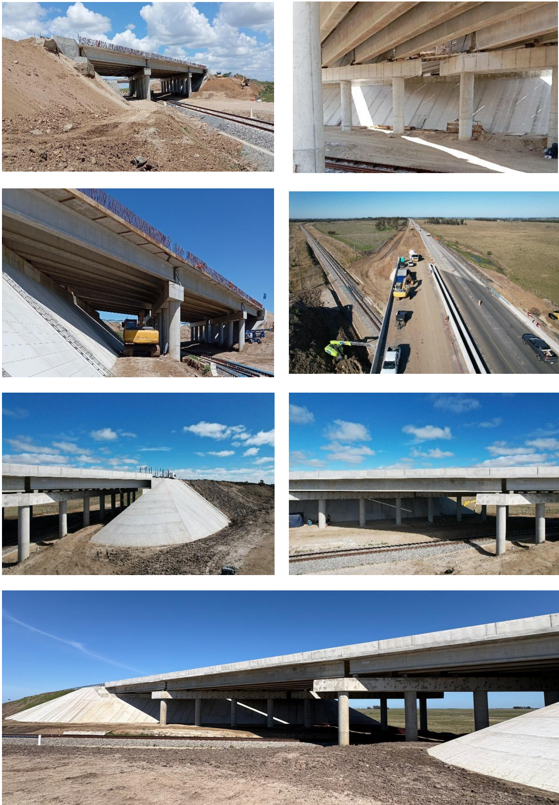
Figura 2-8 Imágenes de las obras: barrera New Jersey de hormigón, cuarto de cono, acabados finales, y el puente definitivo ya terminado.
