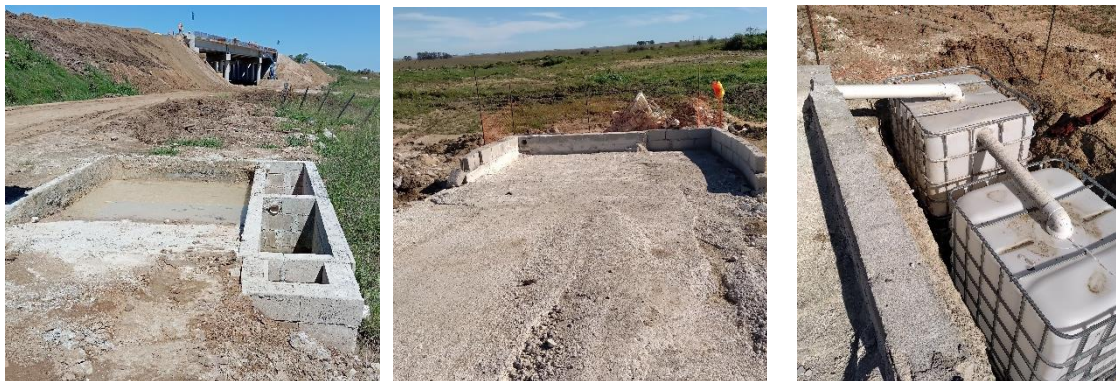
Figura 3-9 Sistemas de lavado de herramientas que hayan estado en contacto con hormigón.
