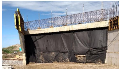
Figura 2-5 Imágenes de las tareas de construcción de bases y muros en el puente provisorio.
