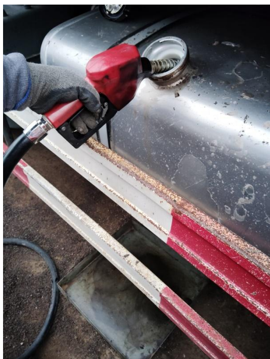
Foto 12.3-3, P03. Se realiza la maniobra de recarga de combustible a la maquinaria con ayuda de bandeja de contención para eventuales derrames.
