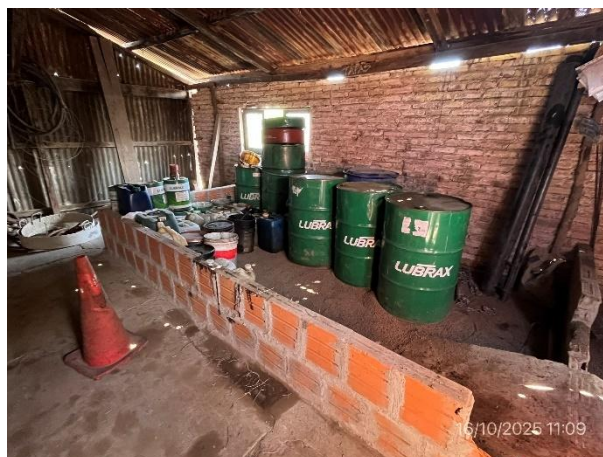
Foto 12.2-4, P03. Obrador, recinto cerrado techado y envallado para alojar tarrinas con hidrocarburos.
