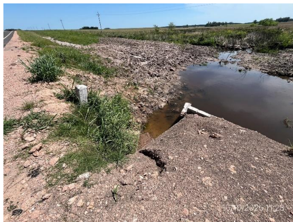
Foto 12.1-4, Alcantarilla de Ruta 90 progresiva 45K700. Conformación de taludes incompleta, sujeta a ocurrencia de erosiones.
