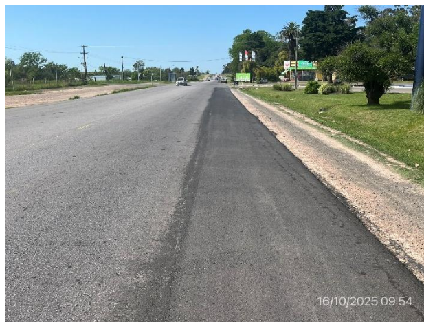
Foto 12.2-2, Ruta 3. Tramo con banquetas en mezcla asfáltica ejecutadas.
