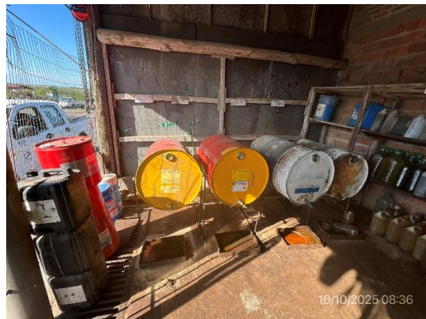
Foto 12.1-2, P05. Acopio de lubricantes. Envallado perimetral correcto y bandejas para manipulación.
