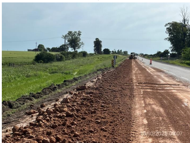
Foto 12.2-3, P06. Frente de obras, Ruta 3 progresiva 396K600. Recargo de banquetas de senda (-) en ejecución.
