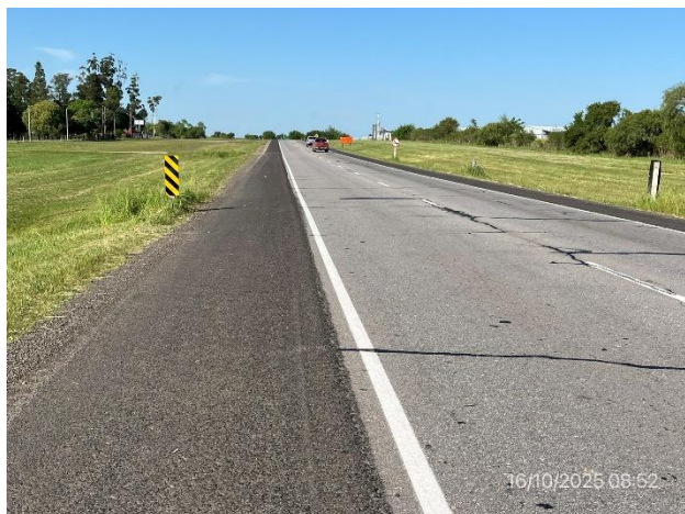
Foto 12.2-1, Ruta 3. Tramo con banquetas en tratamiento bituminoso ejecutadas.
