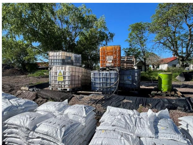
Foto 12.1-5, P04. Obrador, recinto envallado para acopio de tanques con productos químicos.
