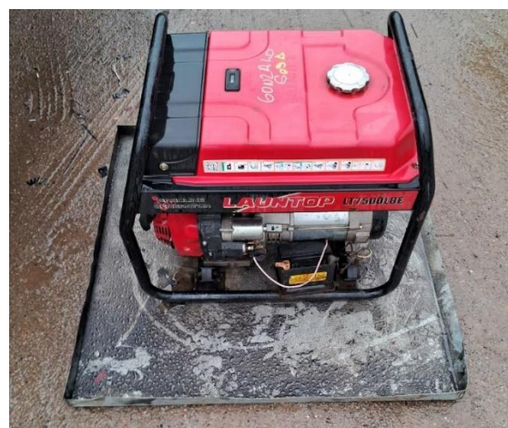
Foto 12.3-4, alcantarilla de Ruta 63 progresiva 1K500. Se dotó al frente de obras con una bandeja estanca para alojar el generador eléctrico.
