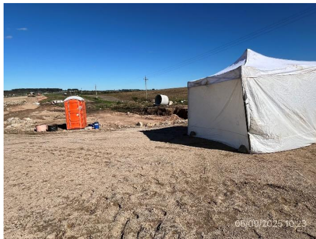
Foto 12.1-12, P08. Campamento provisorio, servicios de confort para operarios y estación correcta para acopio de residuos segregados desde origen.
