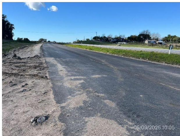
Foto 12.1-8, Bypass de Ruta 1. Tramo parcial con base negra ejecutada.
