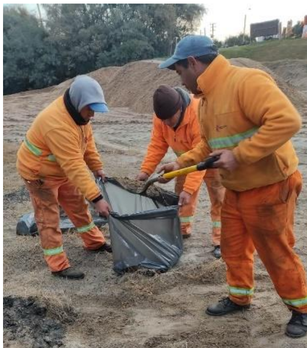
Foto 12.3-3, P03. Se recupera el suelo contaminado y se almacena a la espera de ser retirado por Afrecor.
