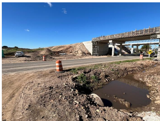
Foto 12.1-6, P06. Campamento provisorio, pendiente recomposición de cunetas circundantes.
