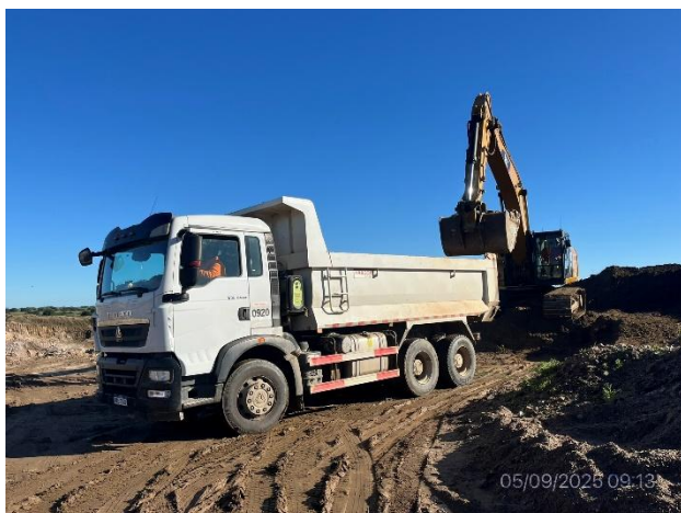
Foto 12.2-3, P05. Proceso de arranque y carga en ejecución.
