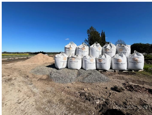
Foto 12.1-10, P07. Acopio en faja pública, insumos para cementado de base granular.
