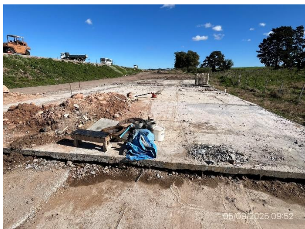
Foto 12.1-5, P06. Campamento provisorio, pendiente definición de desmontado total de explanadas.
