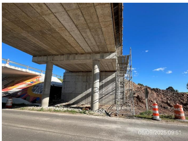
Foto 12.1-3, P06. Obras en puente sin actividad.
