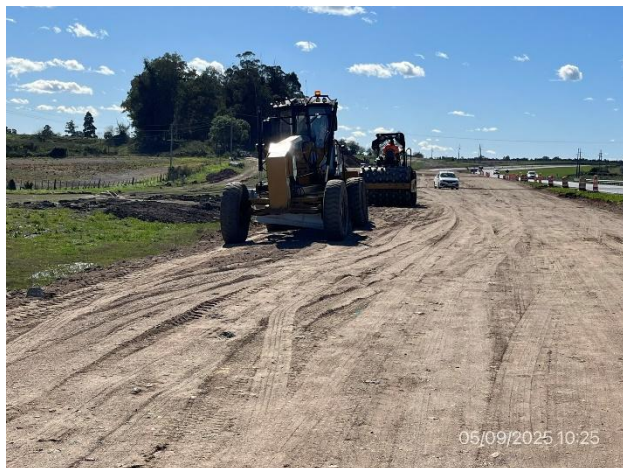
Foto 12.1-11, P08. Frente de obras de movimiento de suelos. Bypass Ruta 1 progresiva 126K100.
