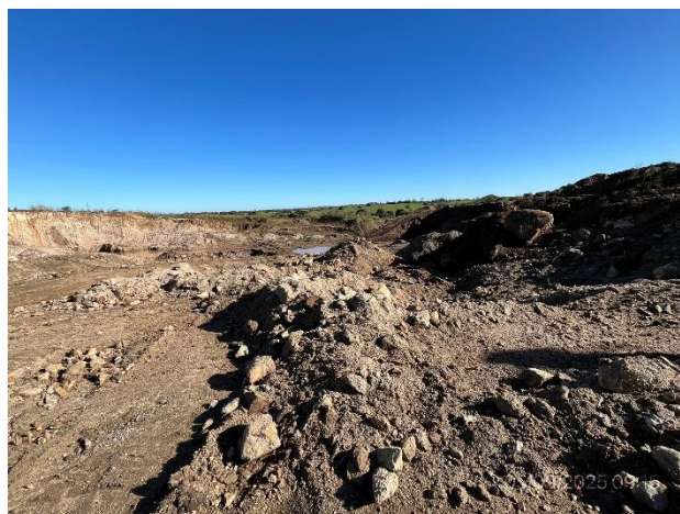
Foto 12.2-4, P05. En el frente de arranque y carga no están presentes los servicios de bienestar ni la infraestructura para el acopio segregado de residuos.
