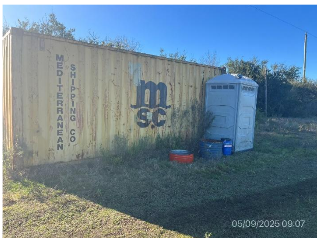
Foto 12.2-5, P05. Están mal localizados los servicios de bienestar y la infraestructura para el acopio segregado de residuos, sumamente alejados del frente de trabajo.
