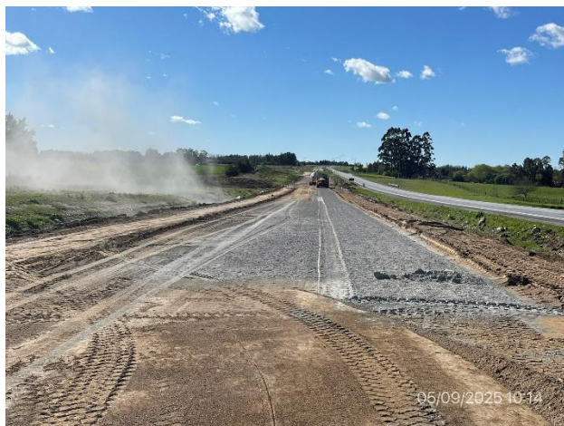
Foto 12.1-9, P07. Frente de obras de cementado de base granular. Bypass Ruta 1 progresiva 123K600.
