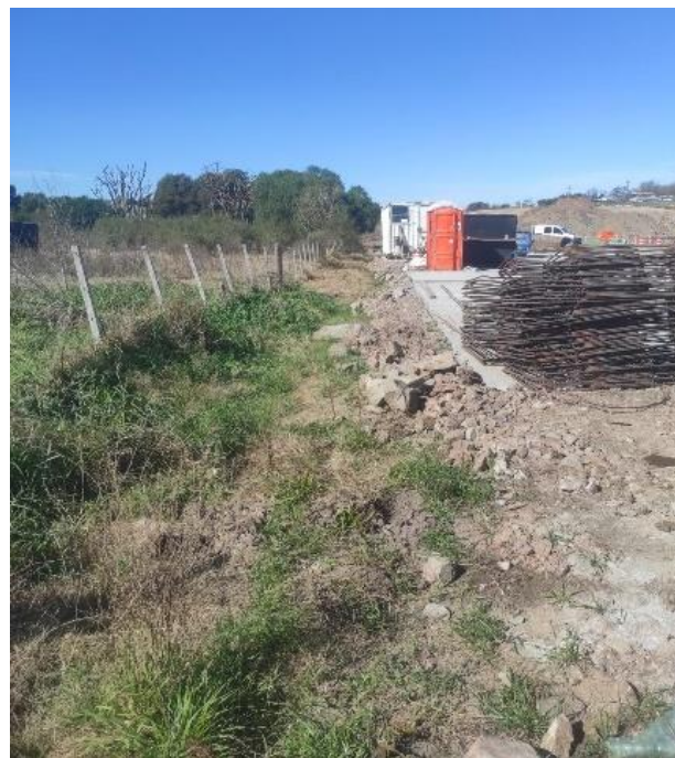
Foto 12.3-4, campamento provisorio, Bypass de Ruta 1 en Colonia Valdense, progresiva 120K000 a (+). Se retiran los acopios mal ubicados y se reconfirmó la cuneta existente.
