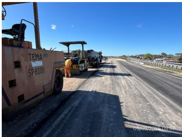
Foto 12.1-7, P06. Frente de tendido de base negra de carpeta asfáltica en accesos al puente del intercambiador. Sin actividad.
