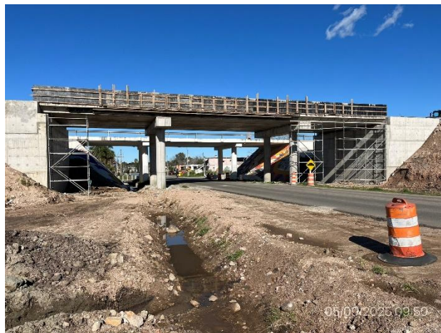
Foto 12.1-2, P06. Frente de obra, Bypass Ruta 1 progresiva 120K700. Intercambiador con Ruta 52
