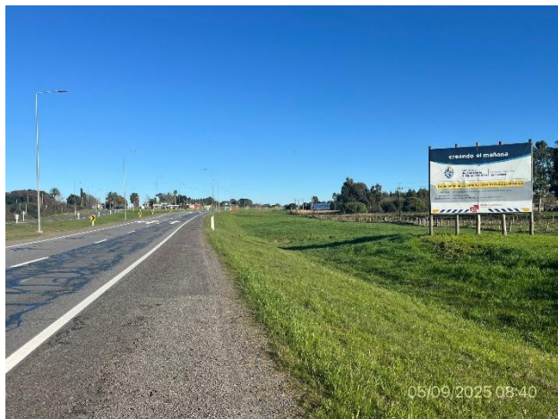
Foto 12.1-1, P01. Inicio de tramo. Bypass Ruta 1 progresiva 119K800.
