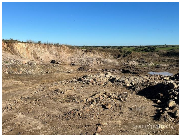
Foto 12.2-2, P05. Frente de explotación.
