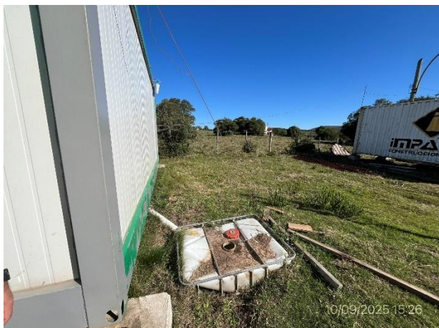
Foto 12.1-5, P03. Obrador, depósito impermeable para retención de aguas servidas.
