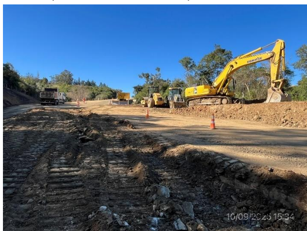
Foto 12.2-9, P05. Recargo granular para ajuste planialtimétrico de los accesos al puente sobre el A° Matajojo en ejecución.
