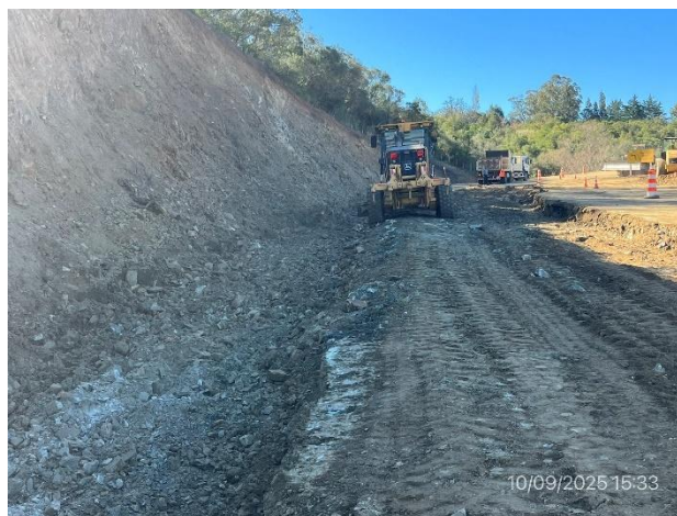
Foto 12.2-8, P05. Desmante para ajuste planialtimétrico de los accesos al puente sobre el A° Matajojo en ejecución.
