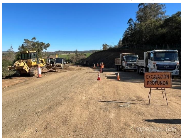
Foto 12.2-10, P05. Obra vial de acceso al puente sobre A° Matajojo. Recargo y perfilado de base granular en ejecución.
