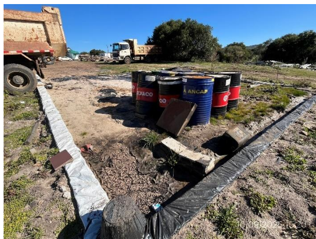
Foto 12.1-8, P03. Obrador, el sector de acopio de tarrinas de emulsión tiene un envallado impermeable correcto, pero hay derrames pendientes de disposición final.
