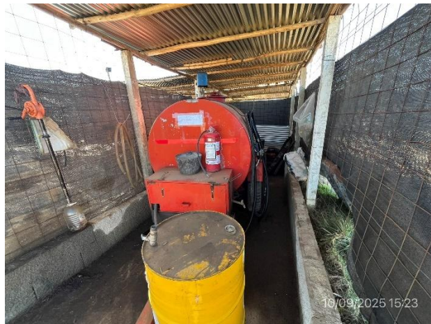
Foto 12.1-2, P03. Obrador, sector techado y con envallado impermeable y bandejas para alojar combustibles
