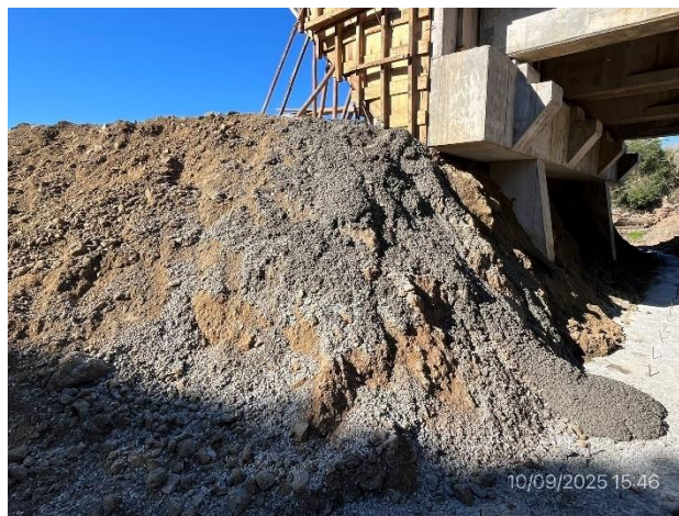
Foto 12.2-4, P05. Hay derrames de hormigón pendientes de reúso o disposición final.
