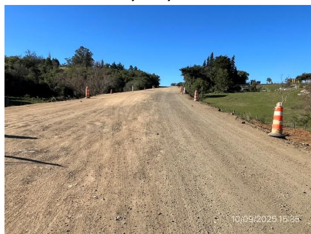
Foto 12.2-11, P05. Obra vial de acceso al puente sobre A° Matajojo. Tramo de Ruta 12 con base granular perfilada.
