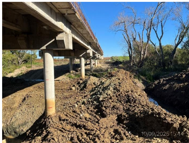
Foto 12.2-2, P05. Superestructura inferior construida. Está correctamente demarcada la cota de máxima inundación.
