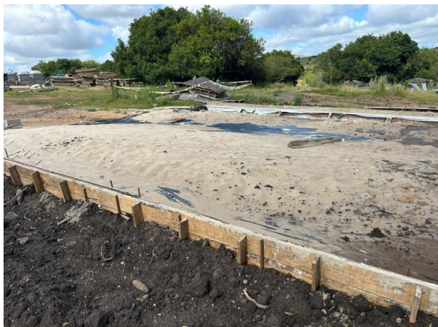
Foto 12.3-1, P03. Se construyó nueva contención lateral en hormigón. La misma luego fue revestida lateralmente con material impermeable y cubierta de arena
