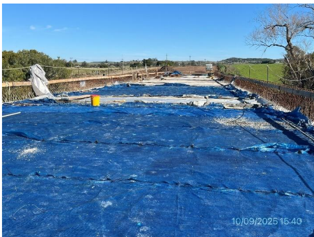
Foto 12.2-3, P05. Se coló el hormigón del tablero del puente. Buenas condiciones de orden y limpieza.
