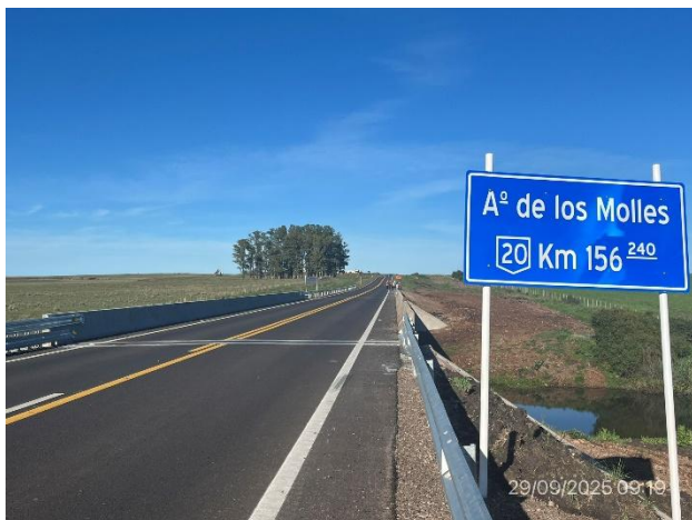
Foto 12.1-1, P01. Puente terminado sobre A° Molles. Ruta 20 progresiva 145K150.
