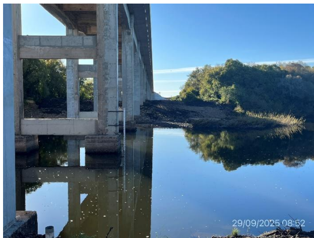
Foto 12.2-6, P02. Estructuras terminadas. Curso de agua en buenas condiciones de escurrimiento.
