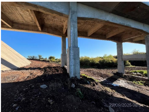
Foto 12.2-5, P02. Permanecen algunos ROCs pendientes de retiro y disposición final.
