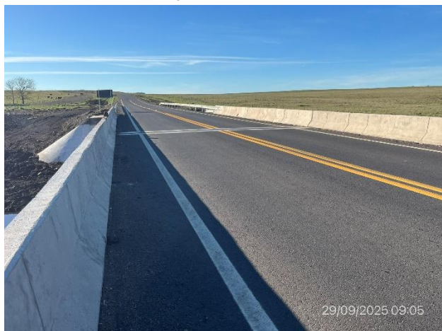
Foto 12.3-5, P03. Puente abierto al tránsito y con señalización definitiva
