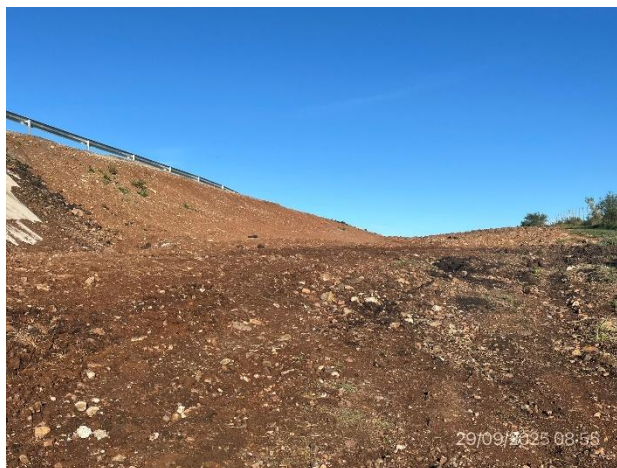
Foto 12.2-4, P02. Taludes de acceso con empastado vegetal incipiente.
