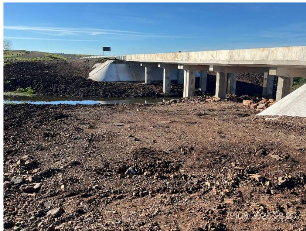
Foto 12.3-2, P03. Estructuras terminadas. Zona de campamento provisional abandonada, libre de ROCs u otro tipo de residuos.
