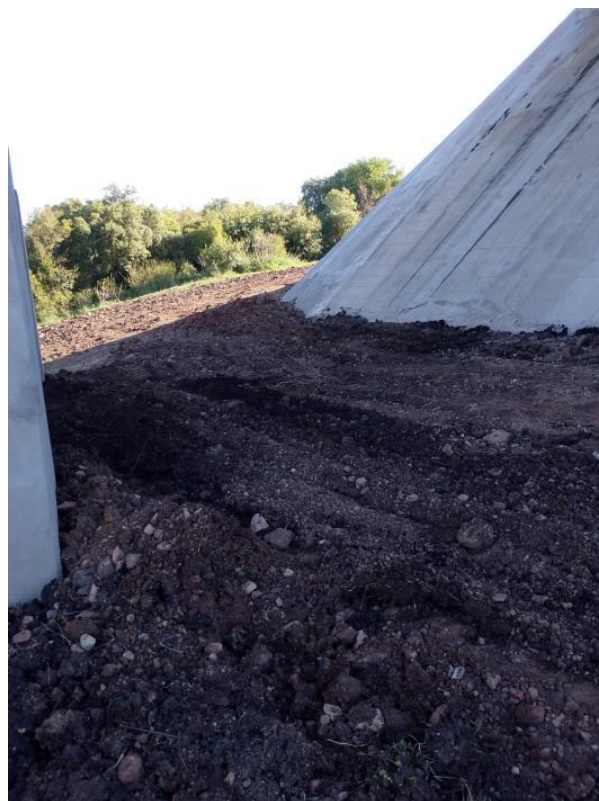
Foto 12.4-2, P02. Se removieron los ROCs a depósito en el acopio de ROCs de la cantera P05
