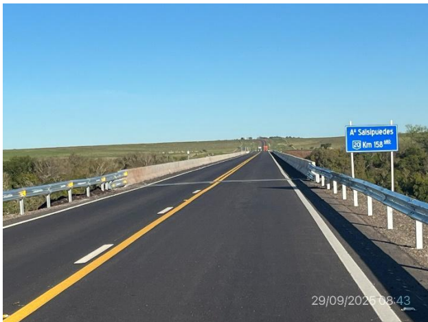
Foto 12.2-1, P02. Puente terminado sobre A° Salsipuedes. Ruta 20 progresiva 147K360.
