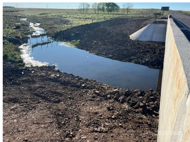
Foto 12.3-3, P03. Taludes de acceso con empastado vegetal incipiente.
