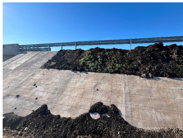
Foto 12.1-3, P01. Taludes de acceso con buena cobertura de suelo pasto.
