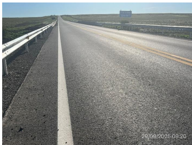
Foto 12.1-6, P01. Puente abierto al tránsito y con señalización definitiva
