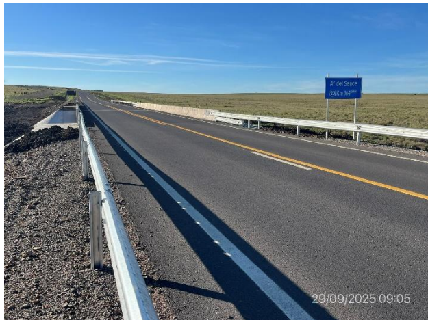
Foto 12.3-1, P03. Puente terminado sobre A° Sauce. Ruta 20 progresiva 152K980.
