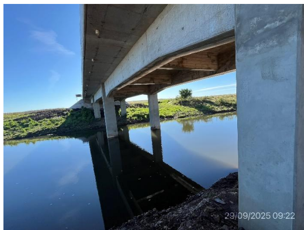
Foto 12.1-4, P01. Curso de agua en buenas condiciones de escurrimiento.
