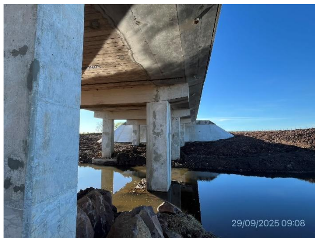
Foto 12.3-4, P03. Curso de agua en buenas condiciones de escurrimiento.
