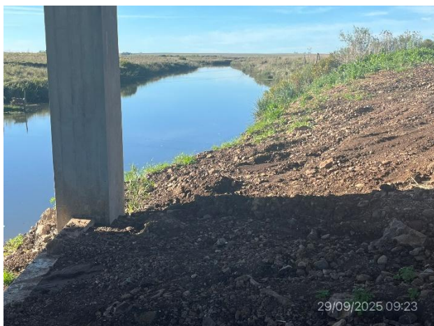
Foto 12.1-5, P01. La ataguía granular fue totalmente retirada.
