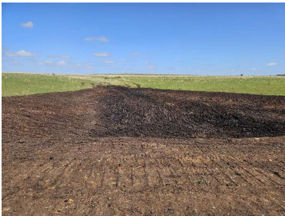
Imagen 9 - Talambo construcción finalizada
