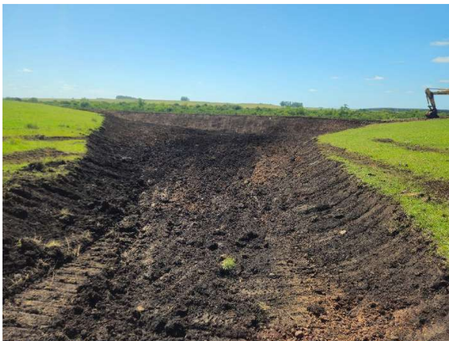
Imagen 8 – Talambo construcción finalizada
