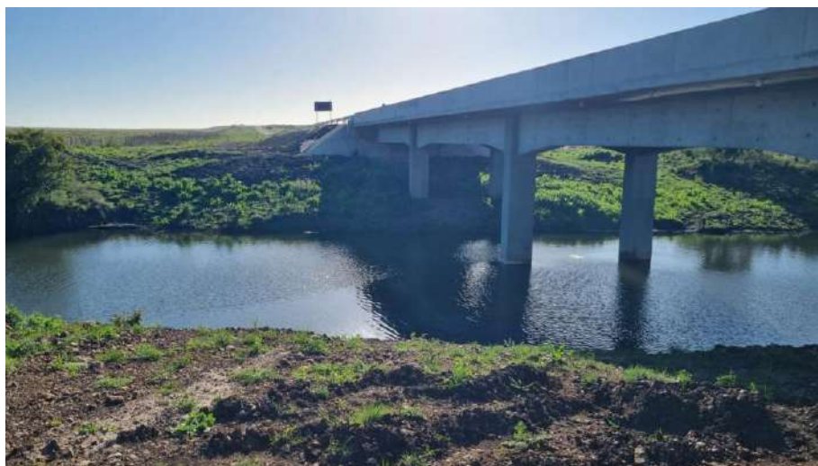
Imagen 6 – Puente sobre A° De Los Molles
