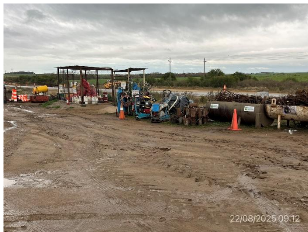
Foto 12.2-8, P02. Obrador SACEEM, plataforma de maniobras y acopio de materiales ordenada y limpia.
