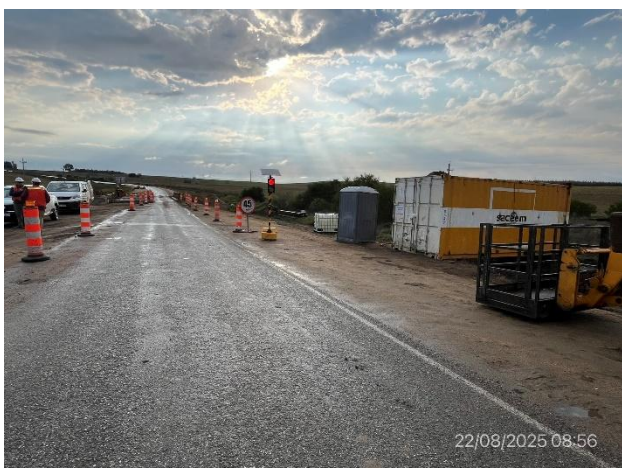
Foto 12.2-17, P03. Puente sobre A° Tornero Chico y campamento provisorio. Ruta 6 progresiva 128K810.
