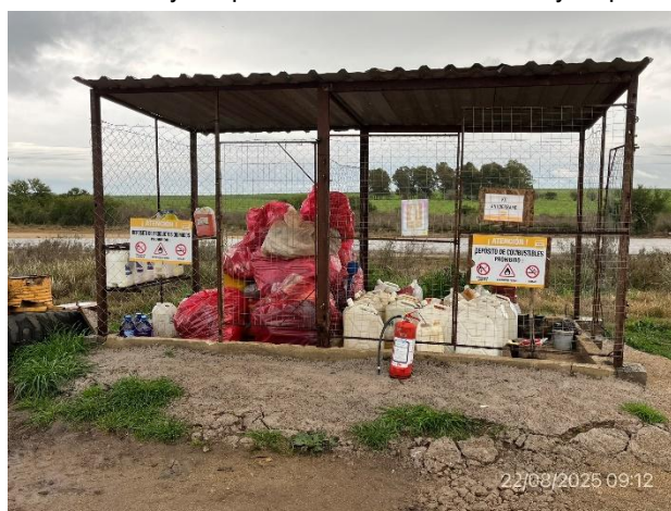
Foto 12.2-10, P02. Obrador SACEEM, recinto techado y envallado para acopio de residuos peligrosos y productos químicos.
