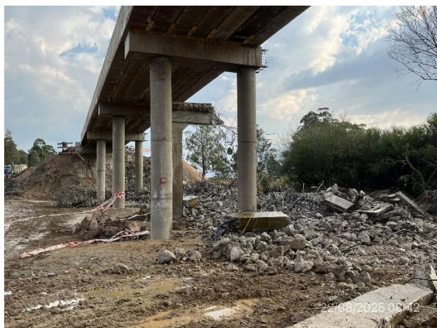
Foto 12.2-29, P04. Demolición del antiguo puente en proceso.
