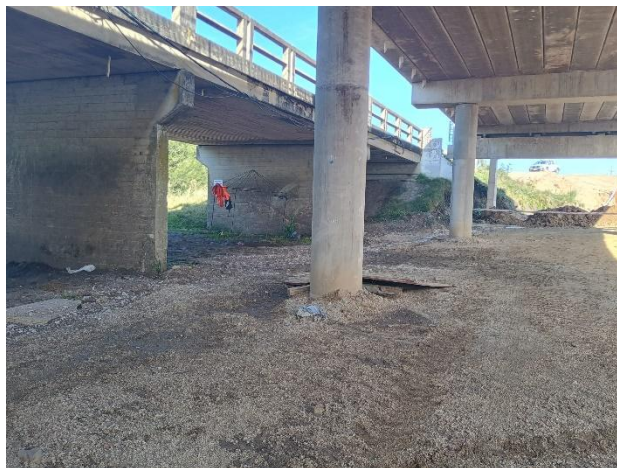
Foto 12.3-2, P01. Se retiraron los residuos de hormigón y la explanada quedó limpia.
