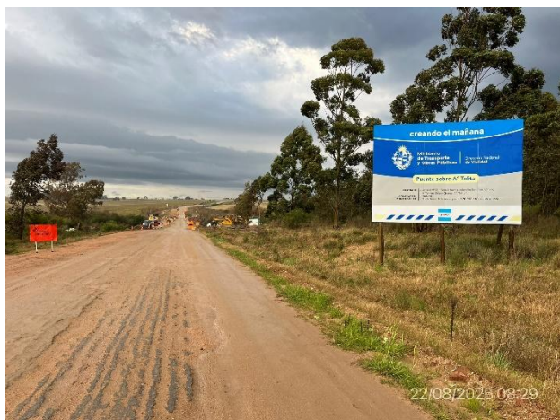
Foto 12.2-23, P04. Nuevo puente sobre A° Talita y campamento provisorio. Ruta 6 progresiva 136K140.
