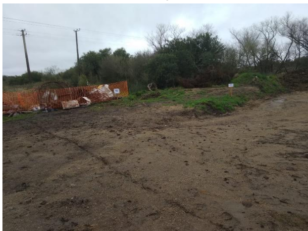
Foto 12.4-3, P01. Puente sobre Río Santa Lucía Chico. Se ajustó la indicación del área inundable.
