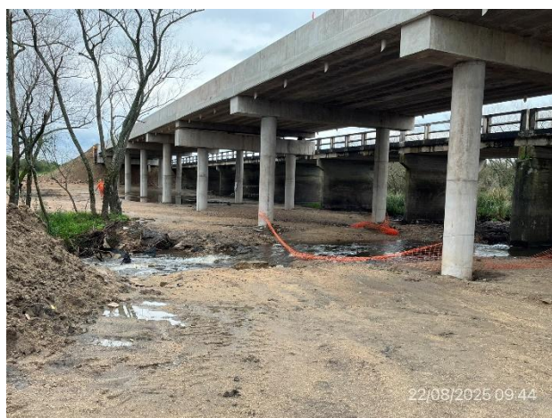
Foto 12.2-4, P01. Obras terminadas a nivel inferior. Cimentaciones, pilares, y vigas dintel terminadas.
