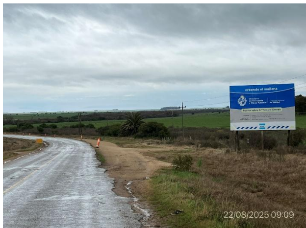
Foto 12.2-7, P02. Puente en obra sobre A° Tornero Grande y obrador principal SACEEM. Ruta 6 progresiva 122K130.
