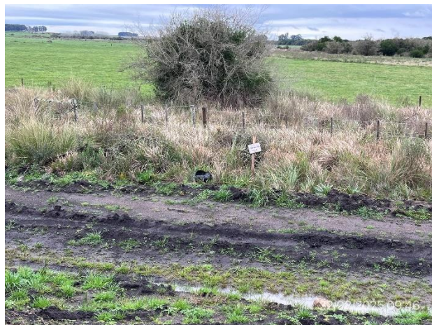
Foto 12.2-2, P01. Puente en obra, zona de máxima creciente incorrectamente demarcada
