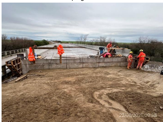
Foto 12.2-3, P01. Tablero terminado. Zona de trabajo con buenas condiciones de orden y limpieza
