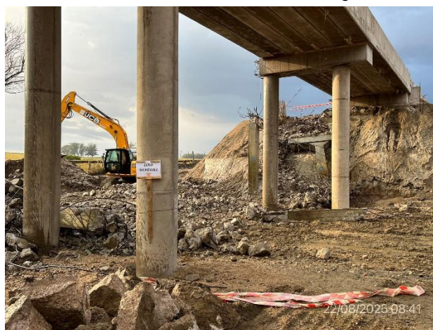
Foto 12.2-28, P04. Demarcación correcta de zona de máxima creciente.
