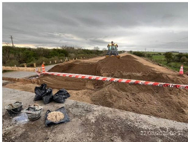
Foto 12.2-14, P02. Puente en obra, ejecución de terraplenes de acceso.
