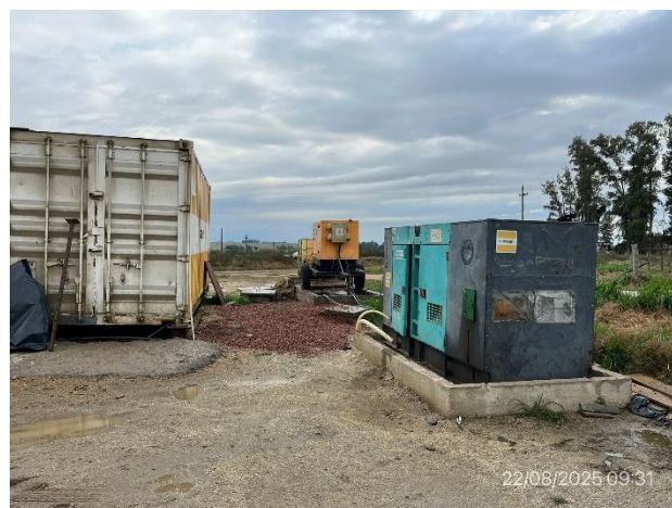
Foto 12.1-2, P05. Explanada de trabajo en buenas condiciones de orden y limpieza
