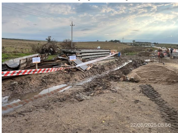
Foto 12.2-21, P03. Explanada de maniobras y de acopio de materiales ordenada.
