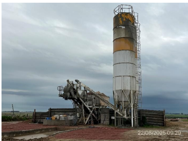
Foto 12.1-1, P05. Planta de hormigón. Padrón rural 8649, 2ª SC. de Florida. Ruta 6 progresiva 120K700 a (+).
