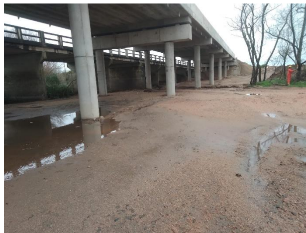
Foto 12.4-4, P01. Puente sobre Río Santa Lucía Chico. Se retiraron los residuos dispersos. La planicie de inundación quedó en buenas condiciones.
