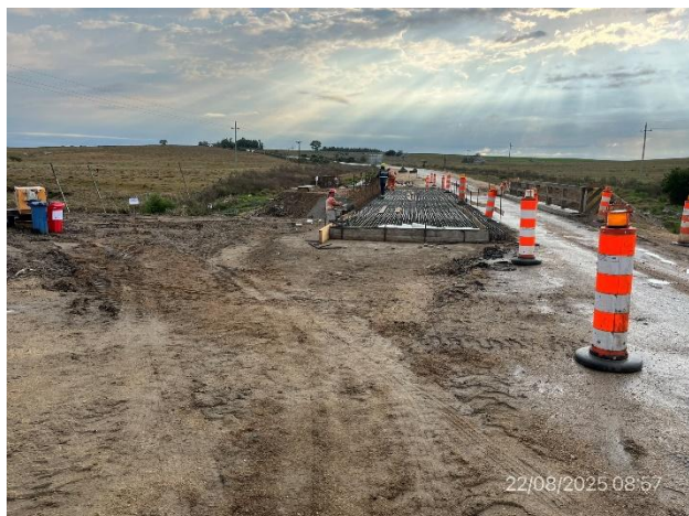
Foto 12.2-19, P03. Trabajos en tablero superior en media calzada. Está disponible la infraestructura para acopio de residuos segregados en origen.
