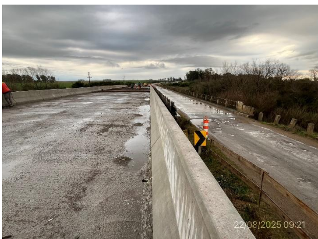
Foto 12.2-15, P02. Está para ejecutarse la demolición del antiguo puente de Ruta 6.
