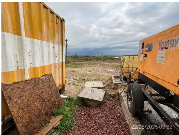
Foto 12.1-3, P05. Depósito impermeable para aguas servidas
