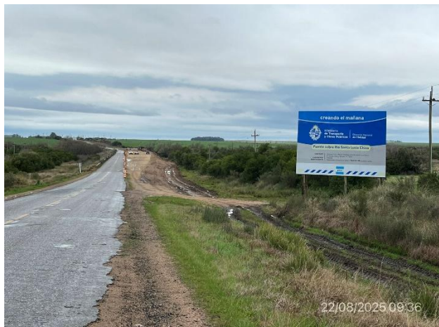
Foto 12.2-1, P01, Puente en obra sobre Río Santa Lucía Chico. Ruta 6 progresiva 119K660.
