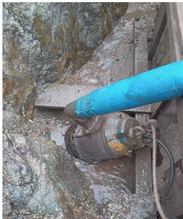
Foto 12.3-3, P02. Se sustituyó la motobomba por una bomba eléctrica.
