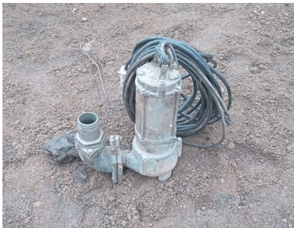
Foto 12.3-1, P01. Se sustituyó la motobomba por una bomba eléctrica.
