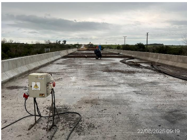
Foto 12.2-13, P02. Puente en obra sobre A° Tornero Grande. Estructura en hormigón con importante grado de avance.
