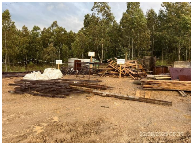
Foto 12.2-25, P04. Campamento provisorio, explanada de maniobras y de acopio de materiales ordenada. Buenas condiciones de limpieza.
