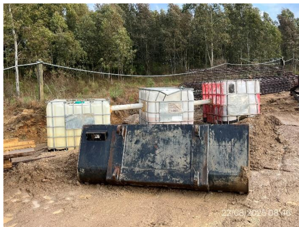
Foto 12.2-26, P04. Campamento provisorio, sistema para decantación de aguas provenientes del lavado de herramientas en contacto con hormigón.
