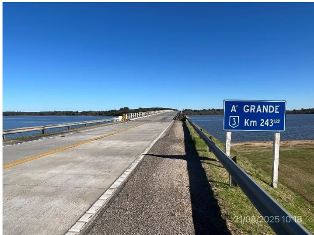
Foto 12.1-1, P01 . Inicio del tramo en el A° Grande. Ruta 3,, progresiva 243K000.
