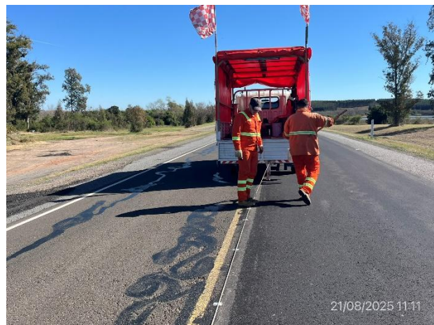
Foto 12.1-8, P08. Tareas de demarcación horizontal en ejecución.
