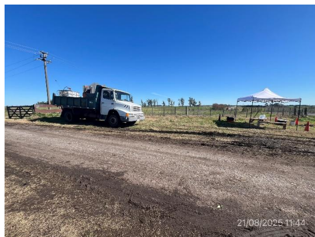
Foto 12.1-12, P07. Frente de obras, campamento provisorio. Faja pública de Ruta 3 progresiva 301K000 a (-).
