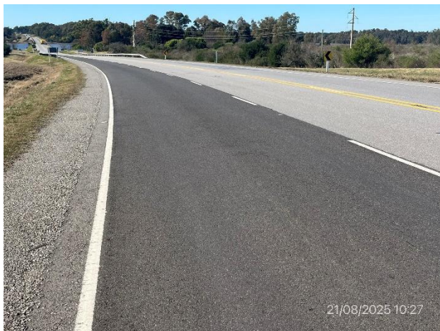
Foto 12.1-3, Ruta 3, trabajos de mantenimiento mayor ejecutados. Tramo de 3ª vía de senda a (+) ejecutada.
