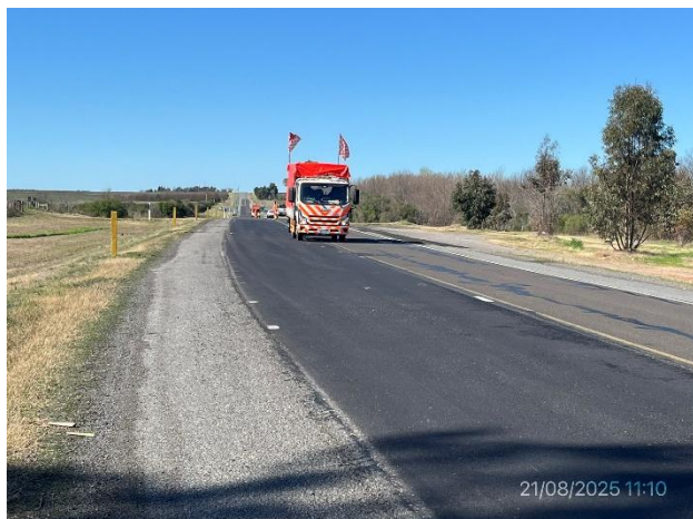
Foto 12.1-7, P08. Frente de obras de señalización, subcontratista Bordonix SA. Ruta 3 progresiva 271K800.
