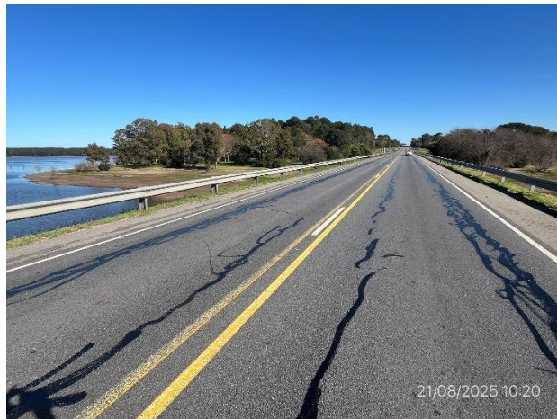
Foto 12.1-2, Ruta 3. Trabajos de mantenimiento rutinario ejecutados, sellado de fisuras ejecutado.
