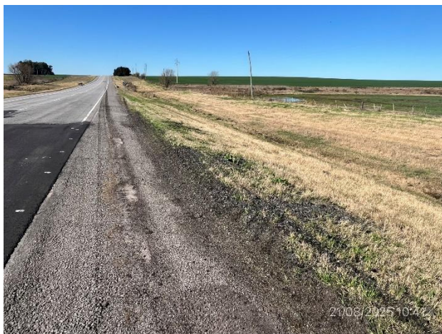
Foto 12.1-15, Ruta 3. Sector de recapado terminado, quedan ROCs en faja pública, senda a (+).
