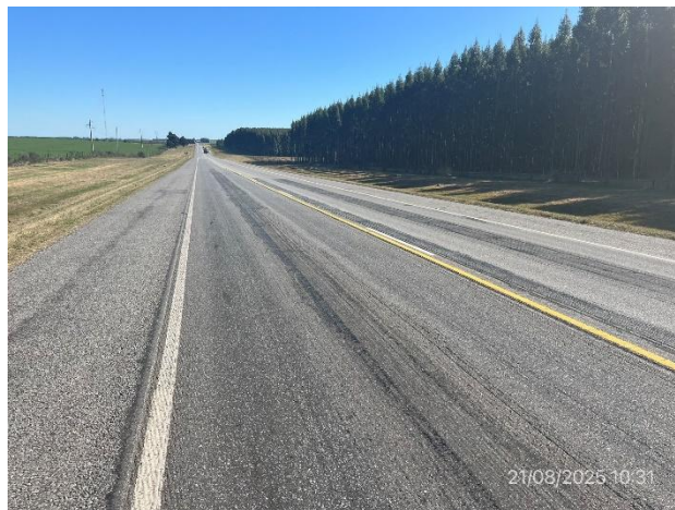
Foto 12.1-4, Ruta 3. Tramo de calzada con fresado ejecutado.
