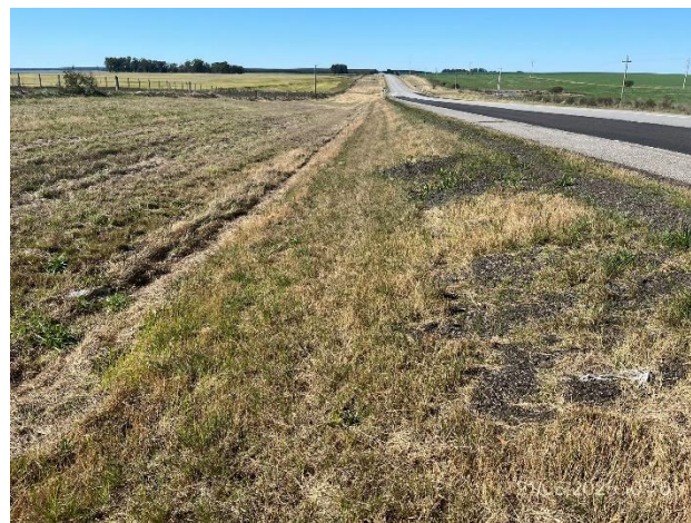
Foto 12.1-16, Ruta 3. Sector de recapado terminado, quedan ROCs en faja pública, senda a (-).
