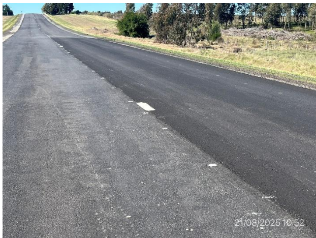
Foto 12.1-5, Ruta 3. Tramo de calzada con recapado ejecutado en sendas a (+) y a (-).
