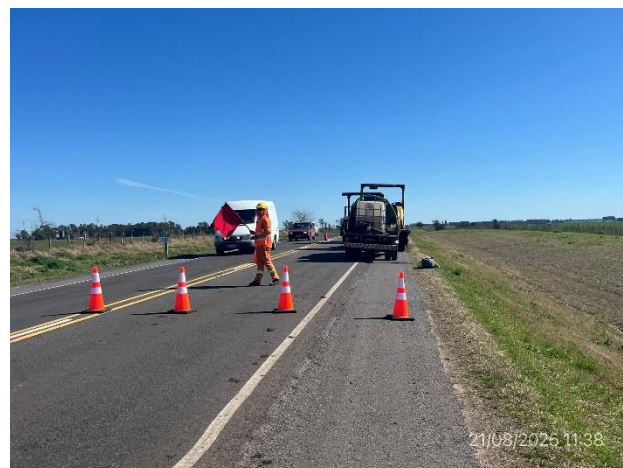
Foto 12.1-9, P07. Frente de obras de recado de mezcla asfáltica. Ruta 3 progresiva 301K000.
