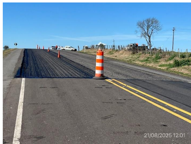
Foto 12.1-10, P07. Frente de obras, tramo de sendas a (+) y a (-) con fresado ejecutado.
