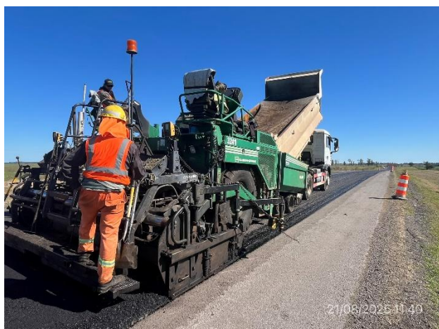
Foto 12.1-11, P07. Frente de obras, tendido de mezcla asfáltica en ejecución.
