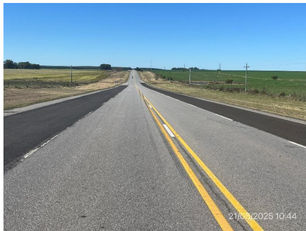
Foto 12.1-6. Ruta 3, trabajos de mantenimiento mayor ejecutados. Tramo de 3ª vías en ambas sendas ejecutadas.
