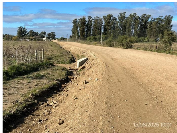
Foto 12.1-2. Ruta 82. Recargo granular ejecutado, pendiente ejecución de carpeta de rodadura en Cape Seal.
