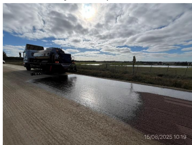
Foto 12.1-6. P06 frente de obra. Tendido de capa de liga en emulsión asfáltica en ejecución.
