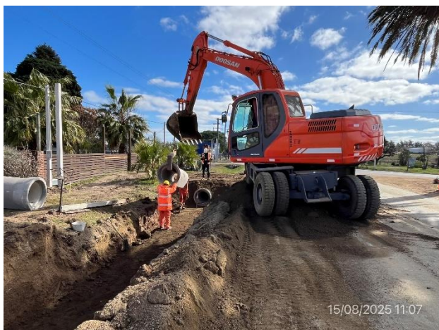
Foto 12.2-5, P08. Drenajes en ejecución.
