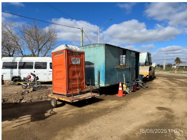
Foto 12.2-3, P08. Campamento provisorio, servicios de bienestar e infraestructuras para acopio temporal de residuos correctos.
