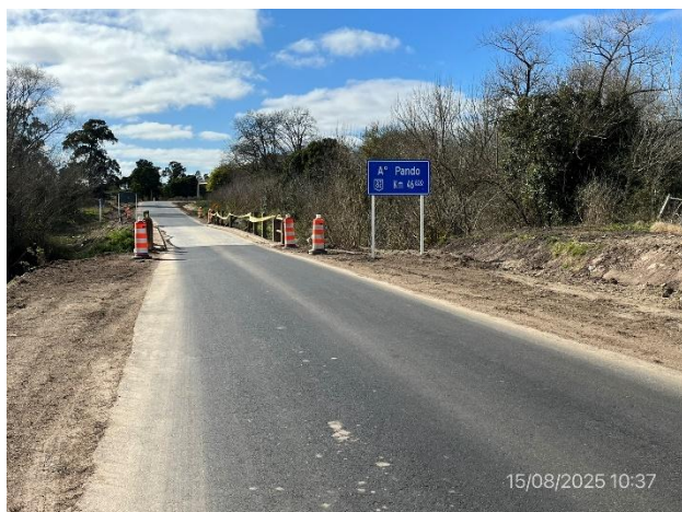
Foto 12.1-9. Ítem 1, tramo de Ruta 82 progresiva 46K800. Puente angosto sobre A° Pando.
