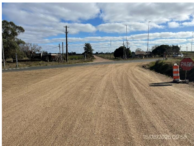
Foto 12.1-1, P02. Fin de tramo Ítem 2, Ruta 82 progresiva 57K900. Empalme con Ruta 86.
