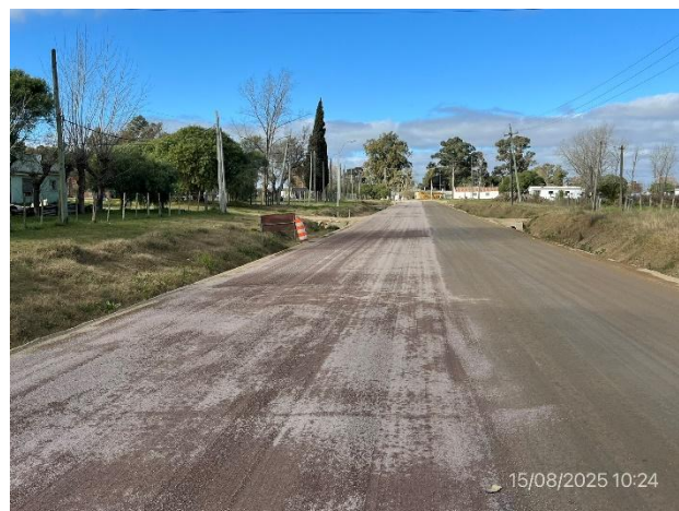
Foto 12.1-4. P05, frente de obra. Cementado de base granular en ejecución
