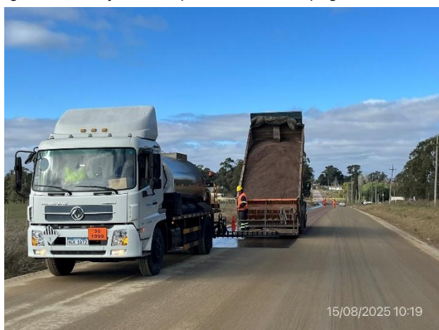
Foto 12.1-5. P06, frente de obra. Tendido de capa de rodadura en Cape Seal en ejecución.
