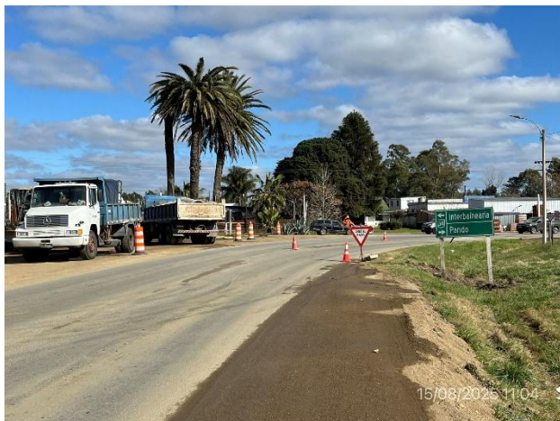
Foto 12.2-1, P08. Ítem 3. Rotonda en construcción y campamento provisorio. Empalme de Ruta 87 con Ruta 34 progresiva 43K300.
