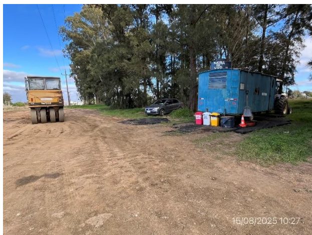
Foto 12.1-11, P07. Campamento provisorio Ítems 1 y 2. Faja pública de Ruta 82 progresiva 49K700 a (-).
