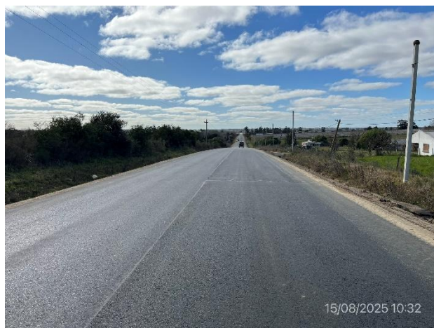
Foto 12.1-8, Ítem 1, tramo de Ruta 82 con carpeta asfáltica ejecutada. Pendientes obras de señalización a cargo de DNV – MTOP.
