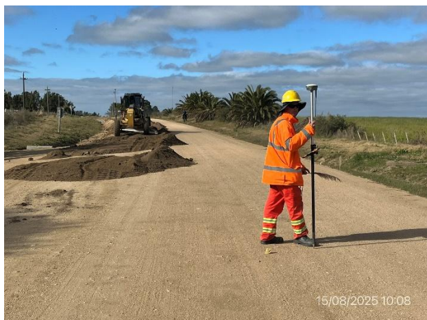
Foto 12.1-3. P05, frente de obra. Perfilado de recargo granular en ejecución, procedimientos apegados al PGA.
