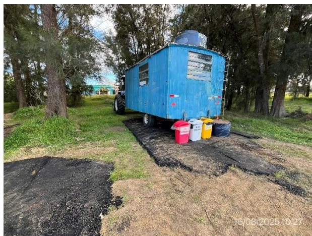
Foto 12.1-12, P07. Estación de acopio de residuos segregados por corriente de generación y tanque reservorio de agua no potable.
