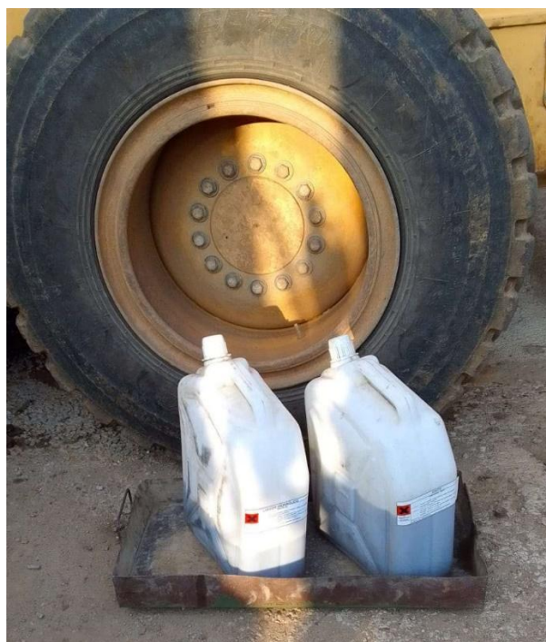
Foto 12.2-2, P03. Se rotularon los bidones de combustible y se los colocó sobre bandeja estanca
