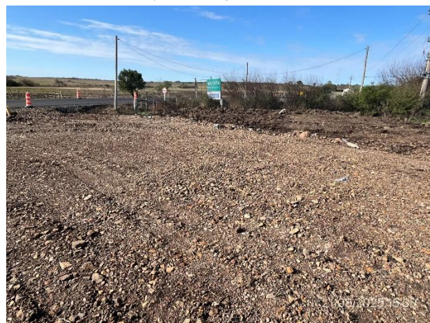
Foto 12.1-6, P01. Campamento en faja pública desmantelado. Zona libre de residuos
