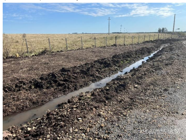
Foto 12.1-4, P01. Rotonda terminada, sector con drenajes adecuados y tapiz vegetal en crecimiento.
