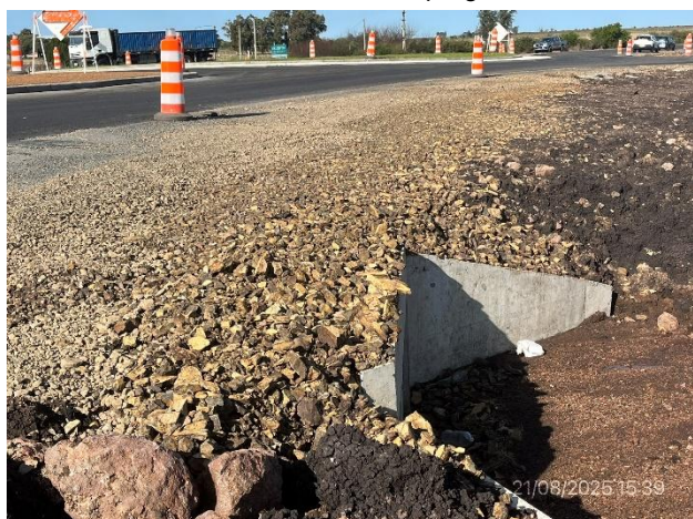
Foto 12.1-3, P01. Rotonda, alcantarilla bajo Ruta 31 terminada.
