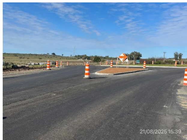
Foto 12.1-2, P01. Rotonda terminada. La señalización es provisoria, pendiente ejecución de señalización definitiva.
