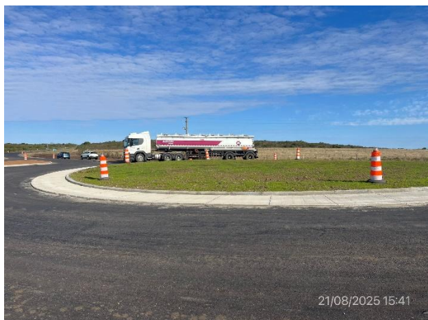
Foto 12.1-1, P01. Nueva rotonda terminada, empalme de Ramal de Ruta 31 con Ruta 31 progresiva 99K000
