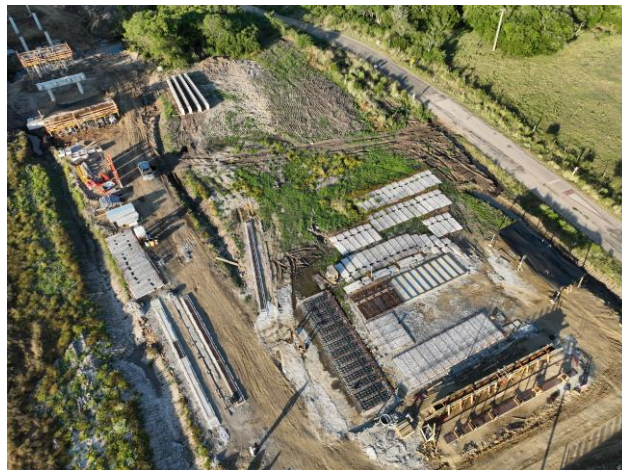
Obrador puente Mataojo
