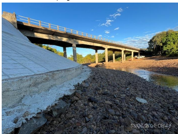
Foto 12.1-3, P01. Cuarto de cono Este con enrocado de protección ejecutado.
