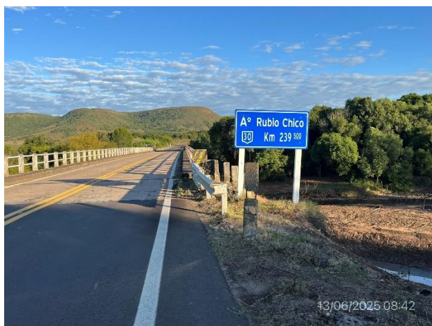
Foto 12.1-1, P01. Puente sobre el A° Rubio Chico. Ruta 30 progresiva 239K200.
