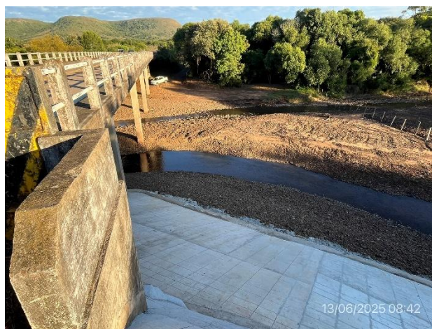
Foto 12.1-2, P01. Cuarto de cono Este con terraplén recargado y protección ejecutada.
