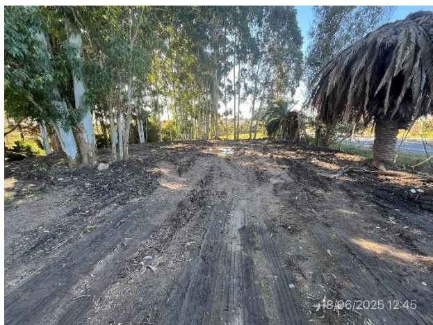
Foto 12.2-3. P02. Depósito de relleno para nivelación con autorización de DNV – MTOP.
