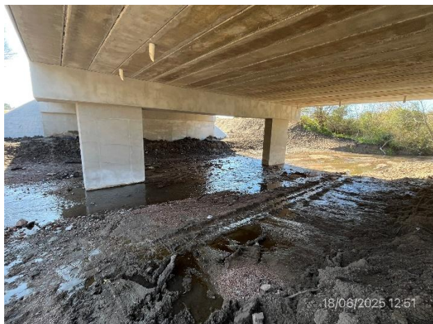
Foto 12.1-3, P01. Ataguía granular desmantelada y estructuras terminadas. Explanada de inundación limpia.
