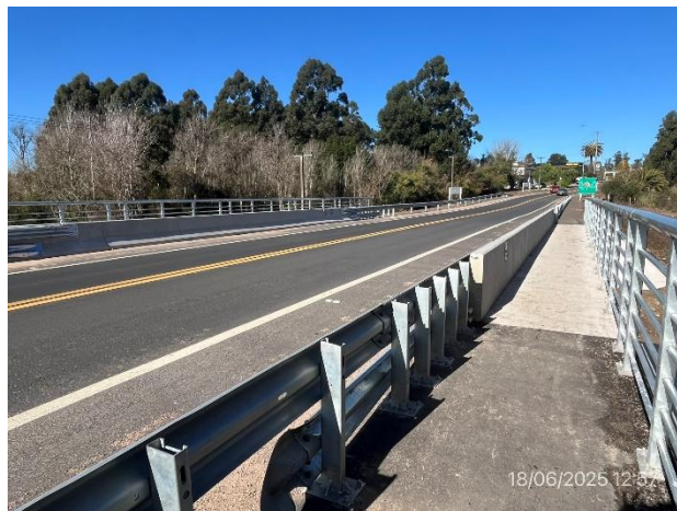
Foto 12.1-2, P01. Obra ejecutada, nueva carpeta de rodadura en mezcla asfáltica y señalización concluida.
