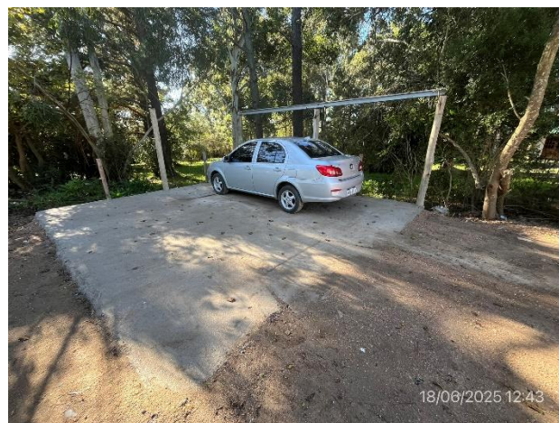
Foto 12.2-2. P02. Obrador. Quedan como mejoras a beneficio del propietario una plataforma de hormigón y un pavimento granular.
