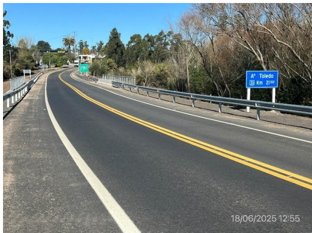
Foto 12.1-1, P01, Nuevo puente sobre A° Toledo. Ruta 33 progresiva 21K200.
