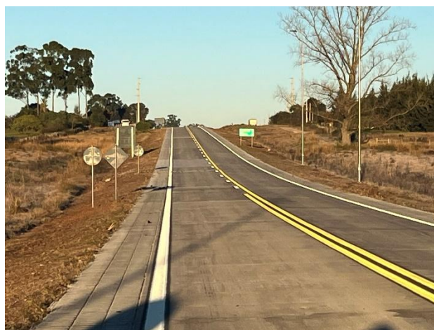
Foto 12.2-2. Bypass a Young de Ruta 25. Obra terminada y abierta al tránsito, nueva calzada en hormigón.
