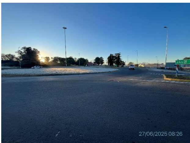
Foto 12.2-1, P01. Inicio de tramo en bypass de Ruta 25. Empalme con Ruta 3 progresiva 308K200.
