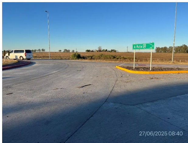
Foto 12.2-6, P02. Fin de tramo en bypass de Ruta 25. Empalme con Ruta 25 progresiva 25K150.
