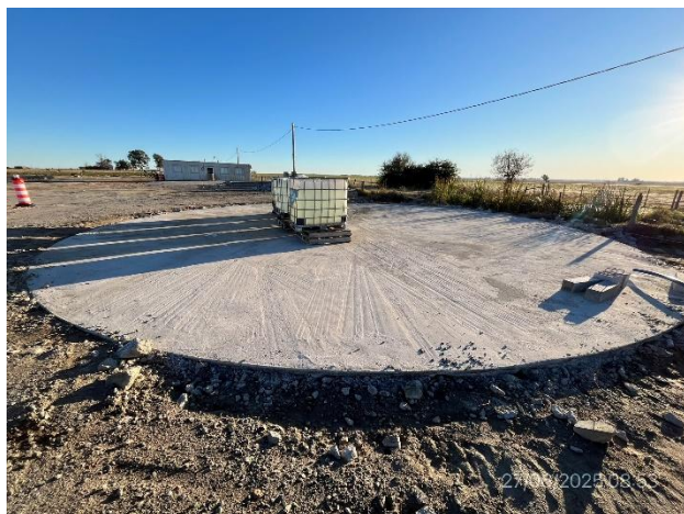
Foto 12.1-3, P03. Cimentación de tanque australiano, queda como mejora a beneficio del propietario
