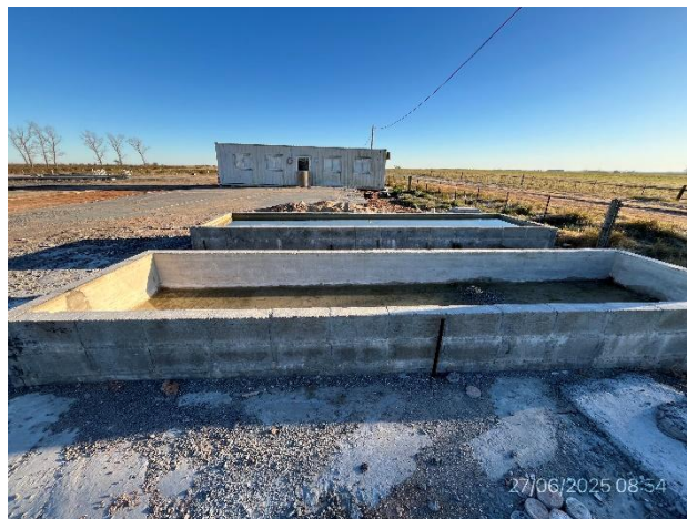
Foto 12.1-2, P03. Piletas de hormigón, quedan como mejora a beneficio del propietario
