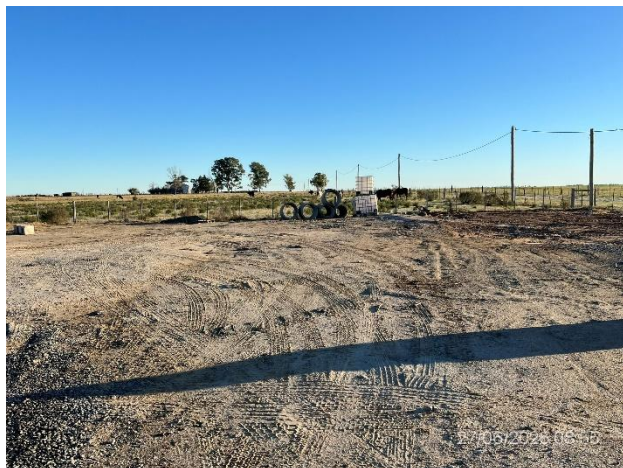
Foto 12.1-1, P03. Obrador y planta de hormigón en proceso de abandono. Ruta 25 progresiva 12K500 a (-).
