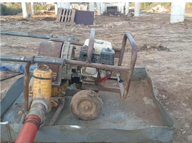
Foto 12.5-5, P03. Puente sobre A° Rocha. Se instaló la motobomba sobre bandeja para prevención de derrames.
