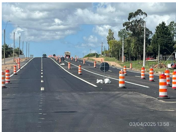
Foto 12.1-1, P01. Inicio de tramo. Ruta 9 progresiva 105K800.
