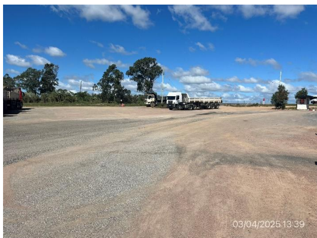
Foto 12.2-1. P03. Planta asfáltica y obrador. Ruta 9 progresiva 113K000 a (-). Padrón N°12343, 3ª SC de Maldonado.
