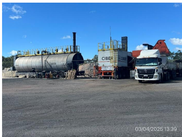
Foto 12.2-2. P03. Planta asfáltica en buenas condiciones de orden y limpieza.
