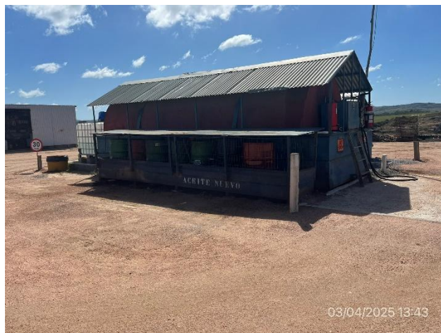
Foto 12.2-10. P03. Obrador. Tanque de combustible y tarrinas de lubricantes bajo techo y con envallado perimetral.
