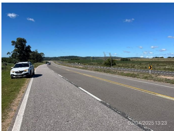
Foto 12.1-3, Ruta 9. Banquinas, señalización y obras de defensas metálicas terminadas.
