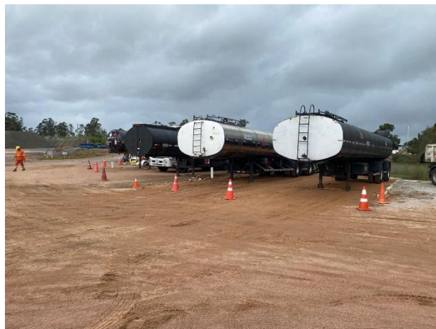
Foto 12.3-4. P03, Planta asfáltica. Se realizó la ampliación de la explanada de estacionamiento de cisternas de emulsión. Fotografía remitida el 08/04/2025.
