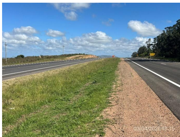
Foto 12.1-4, Ruta 9. Cantero central, buenas condiciones de drenaje y tapiz vegetal abundante.
