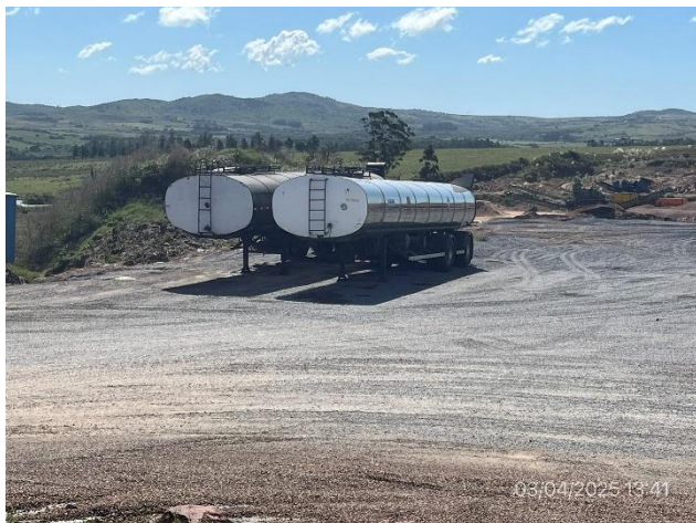
Foto 12.2-7. P03. Obrador. Cisternas de emulsión asfáltica estacionadas en sector sin envallado perimetral.
