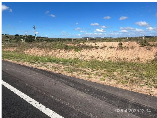
Foto 12.1-5. Ruta 9, progresiva 119K700 a (+). Sector de faja pública con erosiones por escurrimiento pluvial.
