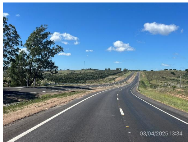
Foto 12.1-2. Ruta 9, duplicación de ruta terminado y abierto al tránsito en ambas sendas.
