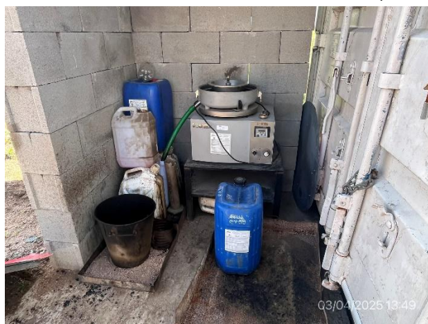
Foto 12.2-6. P03. Obrador. Laboratorio de asfaltos, percloroetileno usado sobre bandeja impermeable y techado.
