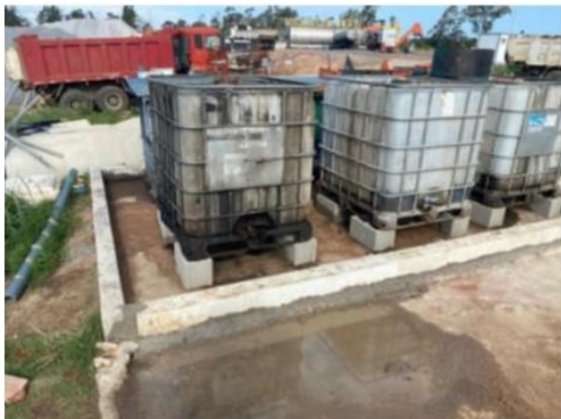
Foto 12.3-1. P03, Obrador. Se realizó cordón perimetral en la explanada de acopio de lubricantes. Fotografía remitida el 27/09/2024.
