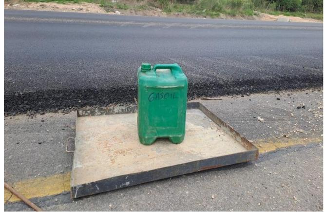
Foto 12.3-6. 10/04/2025. P13. Subcontratista Solstar, pasaje peatonal. Se agregó bandeja para prevención de derrames a bidón de combustible.
