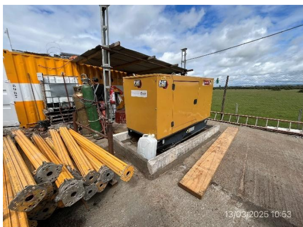
Foto 12.1-5, P01. Campamento provisorio, buenas condiciones de orden y limpieza.
