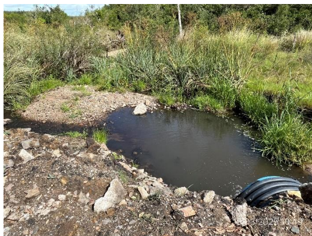
Foto 12.1-4, P01. Ataguía granular y cauce entubado
