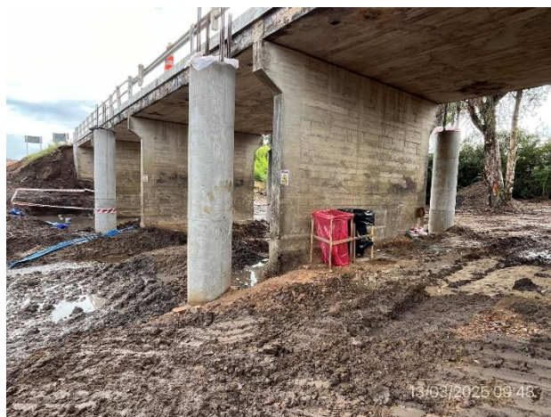
Foto 12.1-20, P03. Nuevas pilas ejecutadas a ambos lados del puente existente.
