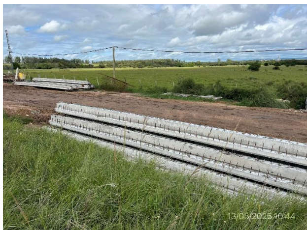
Foto 12.1-13, P02. Campamento provisorio, acopio de viguetas prefabricadas para tablero del puente
