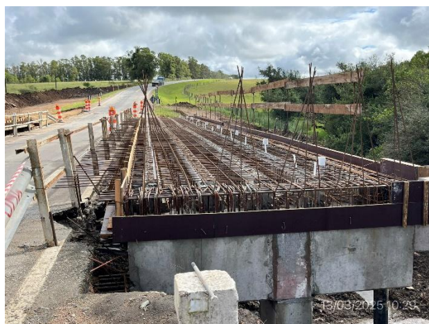
Foto 12.1-10, P02. Zona de ensanche en ejecución con nuevas pilas ejecutadas y viguetas instaladas
