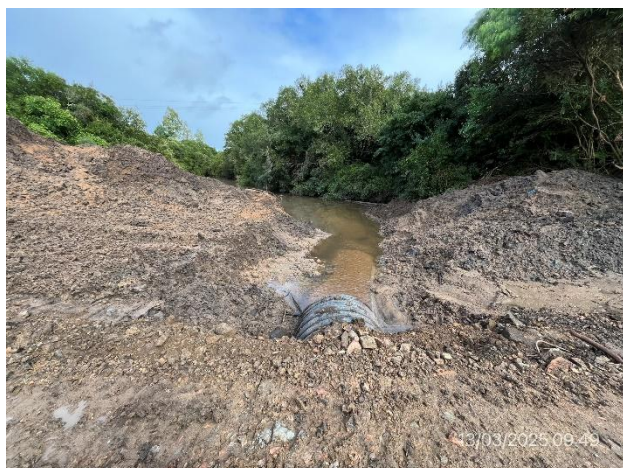
Foto 12.1-19, P03. Ataguía granular y cauce entubado
