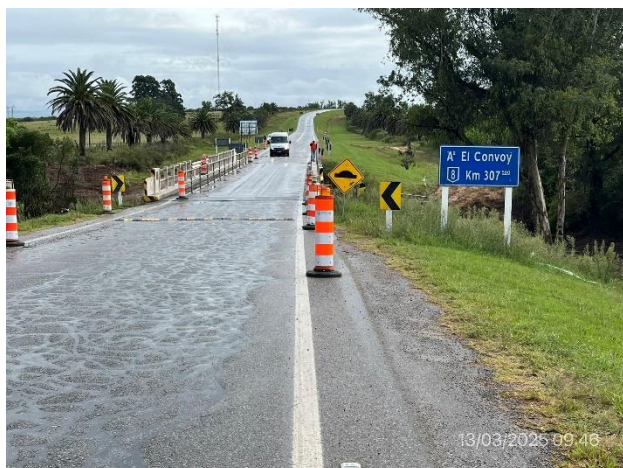
Foto 12.1-17, P03. Nuevo Puente en obra sobre Arroyo El Convoy y campamento principal. Ruta 8 progresiva 307K570
