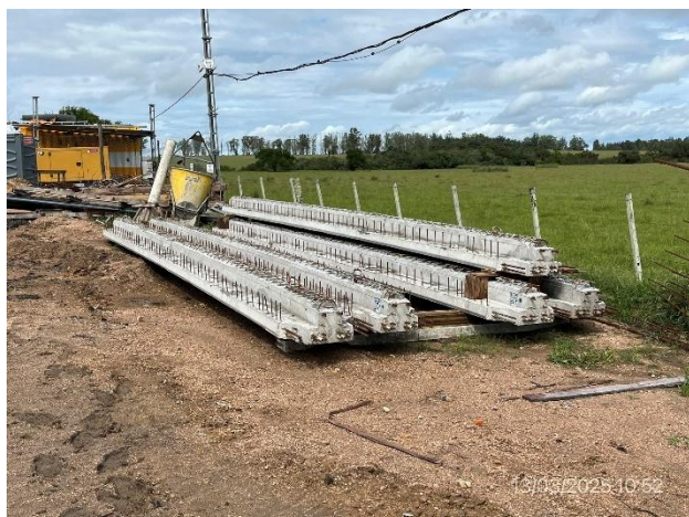
Foto 12.1-7, P01. Sector de acopio de vigas prefabricadas.
