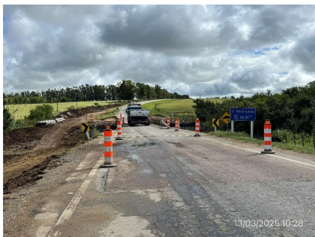
Foto 12.1-9, P02. Nuevo Puente en obra sobre Arroyo Paso de la Arena. Ruta 8 progresiva 305K070
