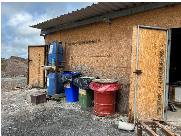
Foto 12.2-5, P04. Infraestructura para el acopio de residuos segregados por corriente de generación.
