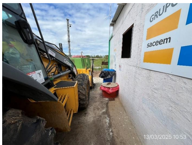
Foto 12.1-6, P01. Estación de acopio de residuos segregados por corriente de generación
