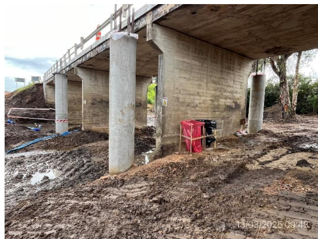
Foto 12.1-18, P03. Estación de acopio de residuos segregados por corriente de generación
