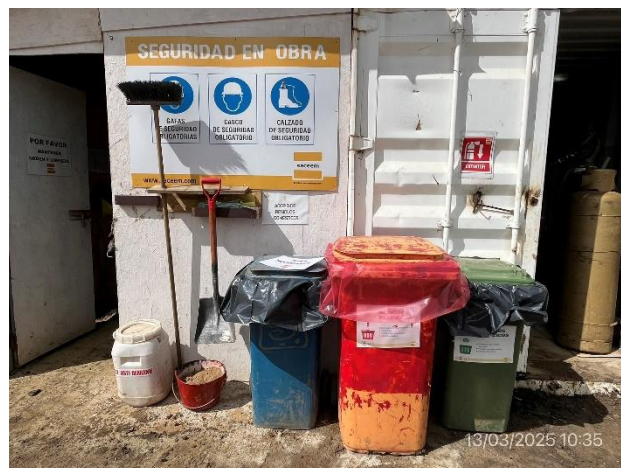
Foto 12.1-14, P02 Campamento provisorio, estación de acopio de residuos segregados por corriente de generación. Está presente el kit antiderrame.
