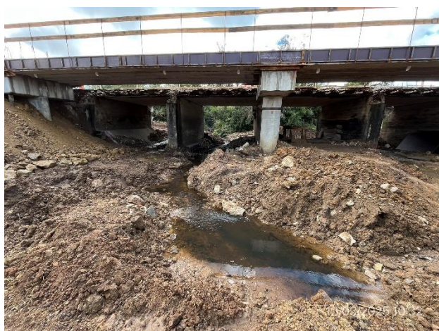
Foto 12.1-11, P02. Atagüía granular y cauce entubado
