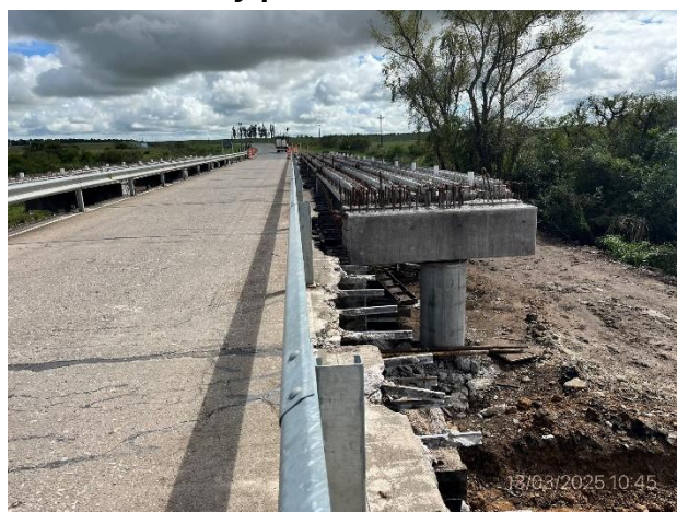
Foto 12.1-2, P01. Zona de ensanche en ejecución con nuevas pilas ejecutadas y viguetas instaladas
