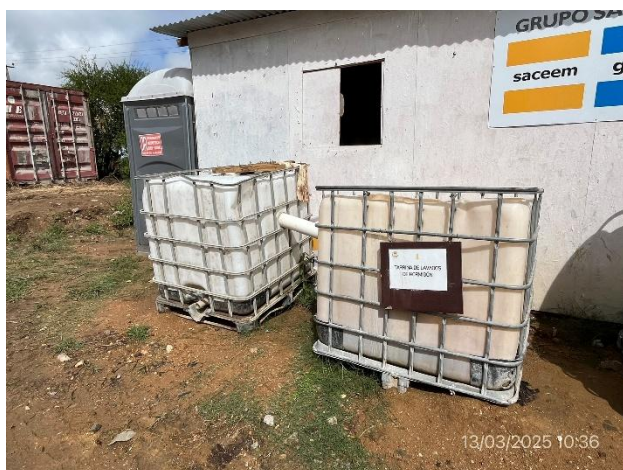
Foto 12.1-15, P02. Campamento provisorio, sector de lavado de herramientas con restos de hormigón
