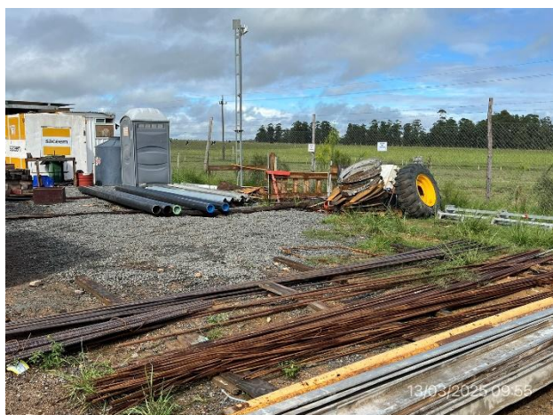
Foto 12.1-21, P03. Campamento principal. Explanada de acopio de tuberías, armaduras y encofrados.
