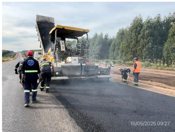
Foto 12.1-4, P06. Frente de obra, Ruta 90 progresiva 40K300. Tendido de mezcla asfáltica en ejecución.
