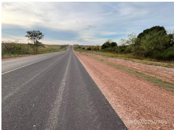
Foto 12.1-3, Ruta 90. Sector con banquina ejecutada, pendientes adecuadas para favorecer empastado.
