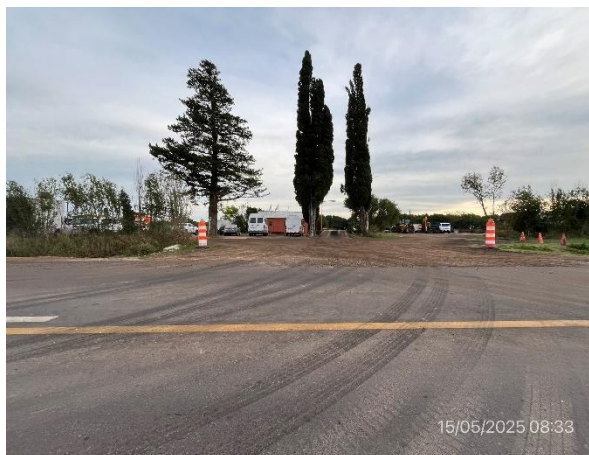
Foto 12.2-1, P03. Obrador y planta asfáltica. Ruta 90 progresiva 31K200 a (-).
