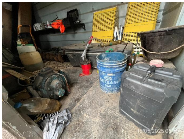
Foto 12.2-8, P03. Obrador, pañol de la planta asfáltica. Hay bidones y tarrinas con lubricantes y combustible fuera del sector envallado preparado para ese fin.
