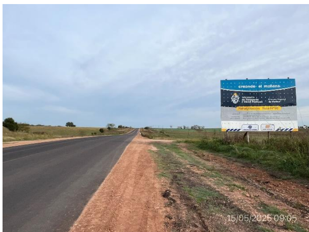
Foto 12.1-1, P01. Inicio de tramo. Ruta 90 progresiva 31K000.
