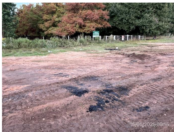
Foto 12.1-6, P06. Frente de obra, campamento móvil con residuos oleosos pendientes de recolección.
