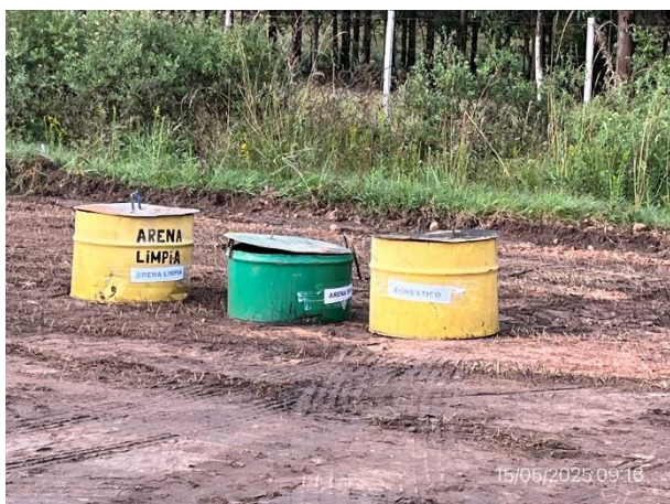
Foto 12.1-5, P06. Frente de obra, campamento móvil con infraestructura correcta para acopio temporal de residuos.
