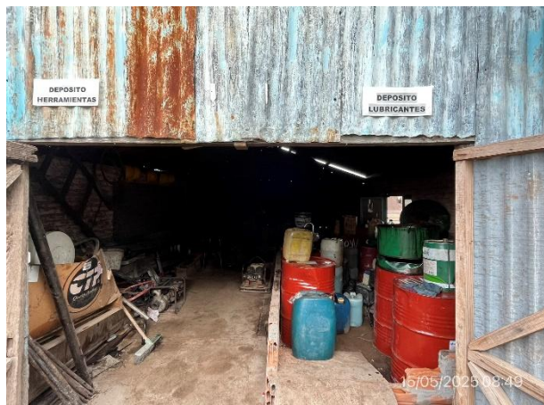
Foto 12.2-7, P03. Obrador, recinto cerrado techado y envallado para alojar tarrinas con hidrocarburos.
