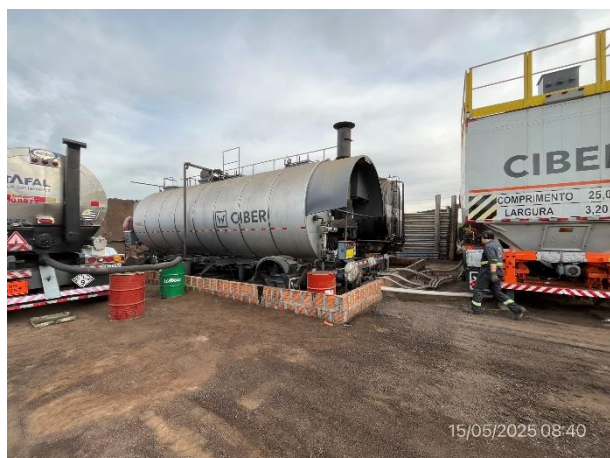
Foto 12.2-3, P03. Planta asfáltica, cisterna de asfalto con envallados perimetrales correctos.
