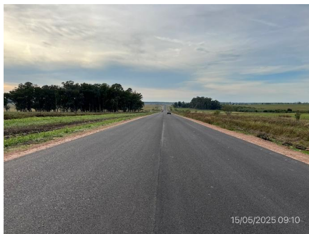
Foto 12.1-2, Ruta 90. Sector con carpeta de rodadura terminada, pendiente de ejecutar obra de señalización.
