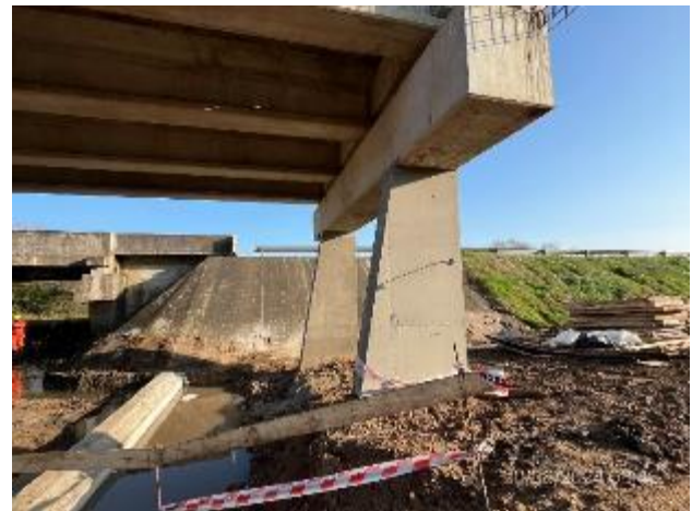
Foto 12.3-2, P03. Estribo de puente senda a (+) terminado.
