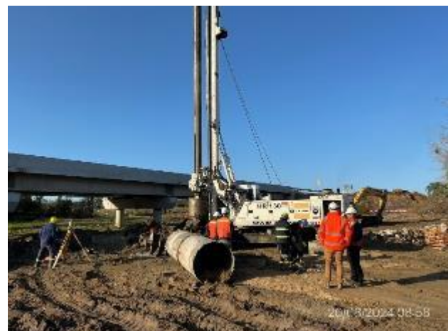
Foto 12.2-4, P02. Pilotaje por medio de entubamiento recuperable en ejecución.
