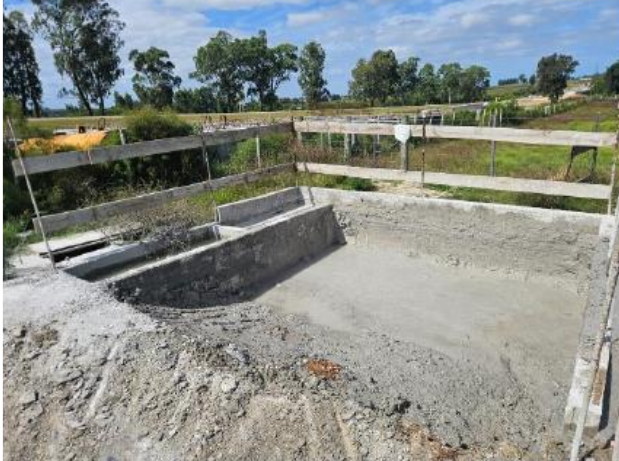
Foto 12.4-1, P04. Obrador SACEEM. Se limpiaron derrames de hormigón, dentro y alrededor de la pileta de lavado de mixer.
