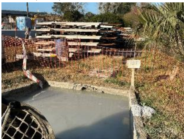
Foto 12.2-9, P02. Campamento provisorio, pileta de decantación de aguas de lavado de herramientas.
