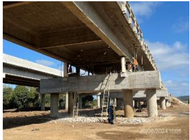
Foto 12.1-2, P01. Ejecución de tareas de elevación de tablero existente por medio de gatos.
