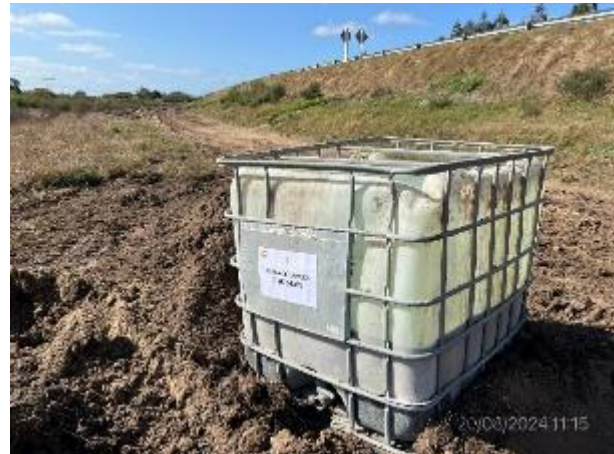
Foto 12.1-12, P01. Campamento provisorio, sector de lavado de herramientas con restos de hormigón.
