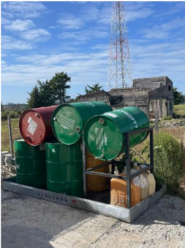
Foto 12.4-3, P04. Se colocó bandeja metálica para contención de productos químicos.
