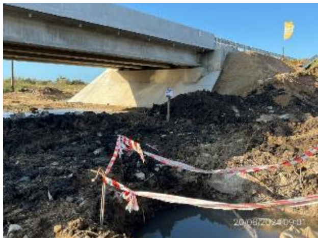
Foto 12.2-5, P02. Demarcación correcta de cota de máxima inundación.
