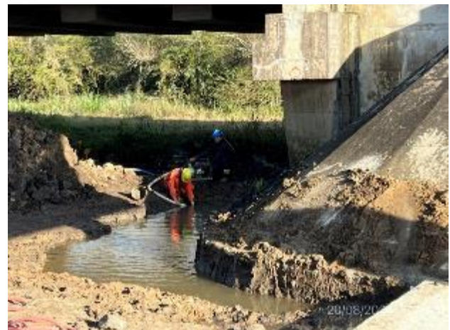
Foto 12.3-6, P03. Desagote de excavaciones por medio de motobomba dotada de bandeja para contención de eventuales derrames.
