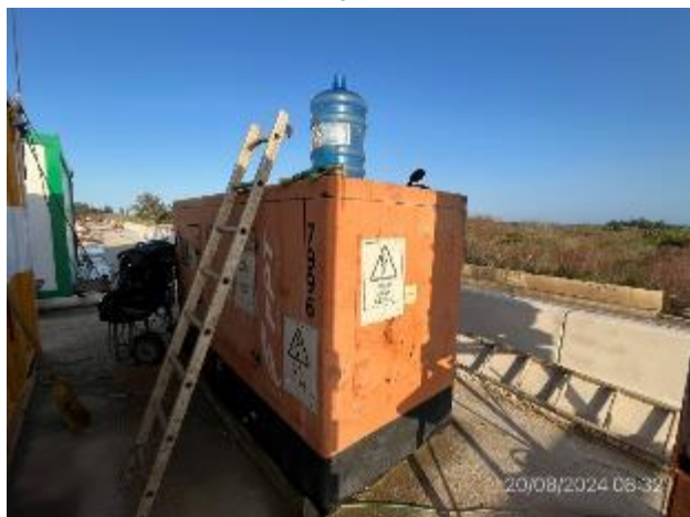
Foto 12.3-11, P03. Generador eléctrico con bandeja inferior para contención de eventuales derrames.
