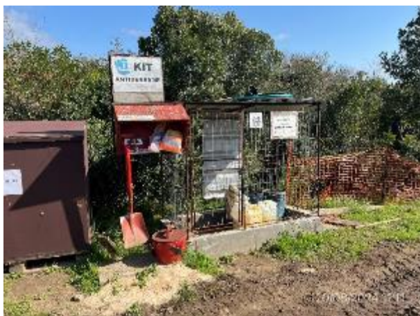
Foto 12.1-9, P01. Campamento provisorio, envallado correcto para acopio de hidrocarburos y KIT para gestión de derrames.
