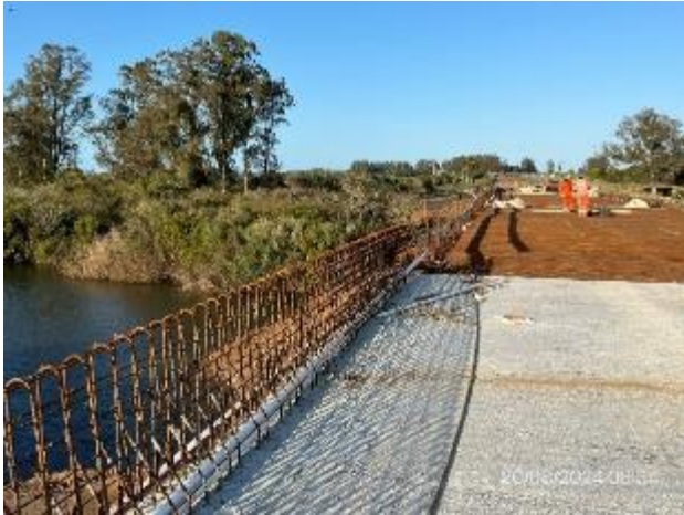
Foto 12.3-3, P03. Armaduras en construcción de vigas New – Jersey de borde.
