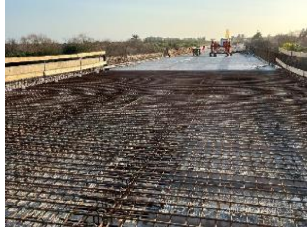
Foto 12.3-4, P03. Preparación de armaduras en tablero superior.
