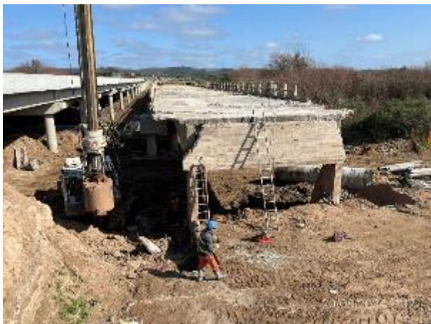
Foto 12.1-3, P01. Frente de obra de pilotaje, falta la infraestructura para acopio temporal segregado de residuos.
