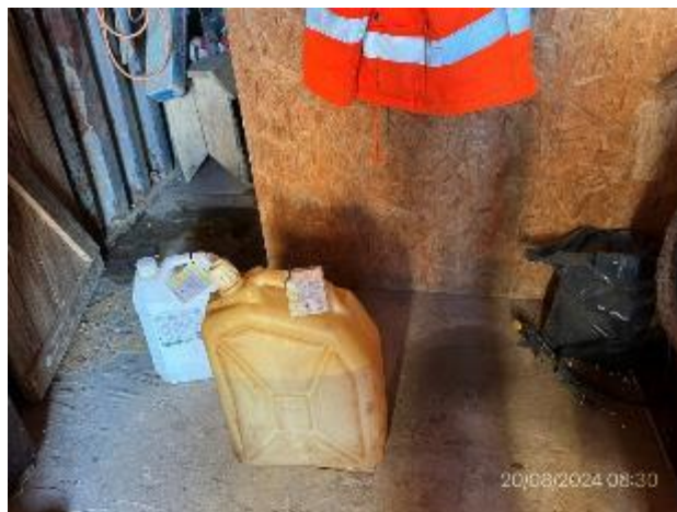
Foto 12.3-12, P03. Pañol, bidones con hidrocarburos alojados fuera de los sectores envallados.
