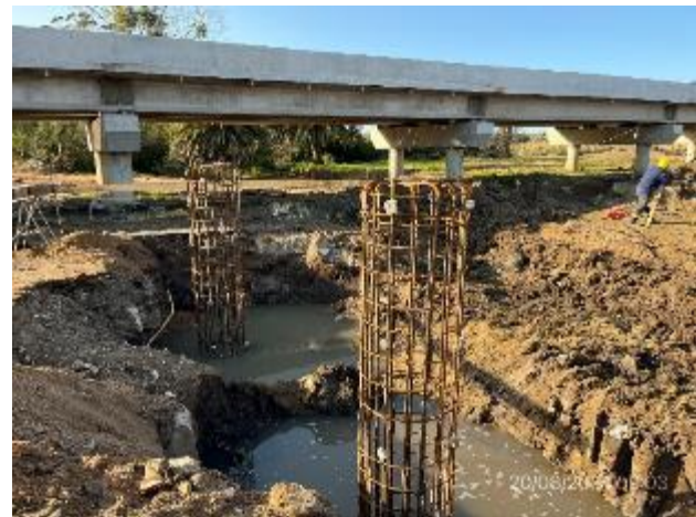
Foto 12.2-2, P02. Cabezales ejecutados y armaduras de pilares colocadas.
