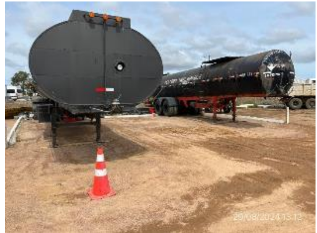
Foto 12.2-14. P03, Planta asfáltica. Cisternas de emulsión asfáltica alojadas en recinto impermeable y envallado.
