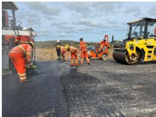
Foto 12.1-8, P06. Cuadrilla de tendido de asfalto ejecutando la tarea en buenas condiciones de orden y limpieza.
