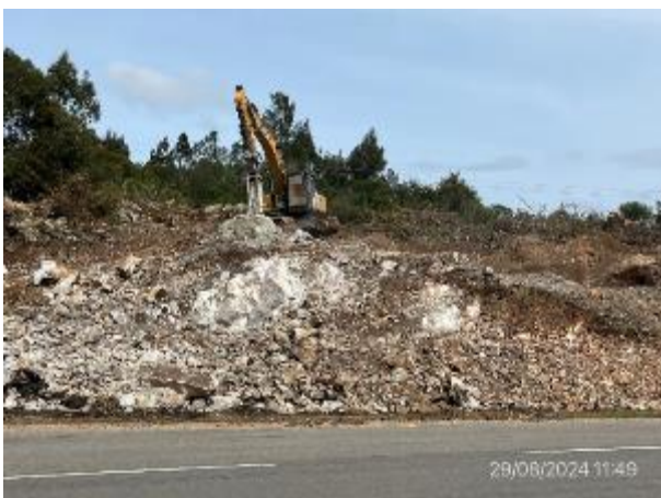
Foto 12.1-11, P10. Desmonte de macizo rocoso, transportado a tren de trituración de GVESA.
