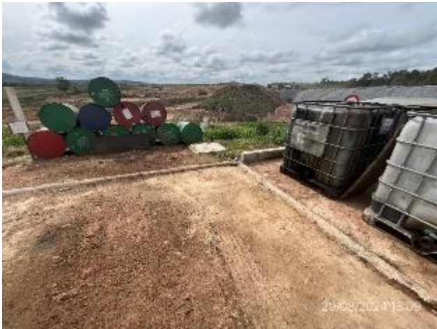
Foto 12.2-13. P03, Obrador. Sector de acopio de lubricantes, envallado insuficiente para contención del volumen alojado.
