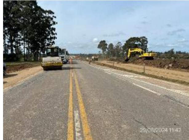
Foto 12.1-8, P09. Apertura de caja y preparación de subrasante en ejecución.
