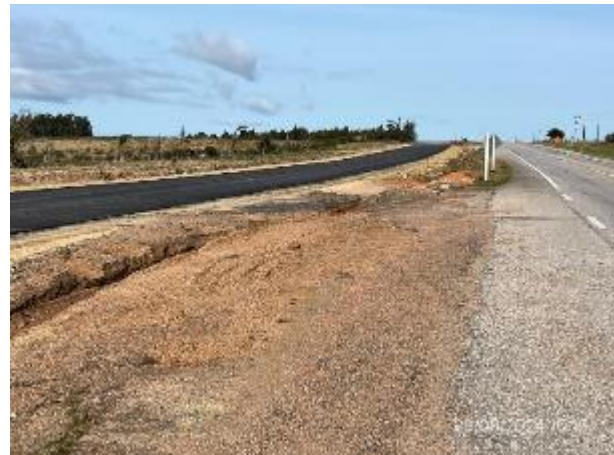
Foto 12.1-2, Ruta 9. Tramo parcial con nueva senda ejecutada cerrada al tránsito, sin señalización horizontal.
