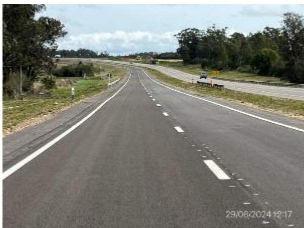
Foto 12.1-11, Ruta 9. Tramo parcial con carpeta de rodadura drenante ejecutada y señalización horizontal ejecutada.
