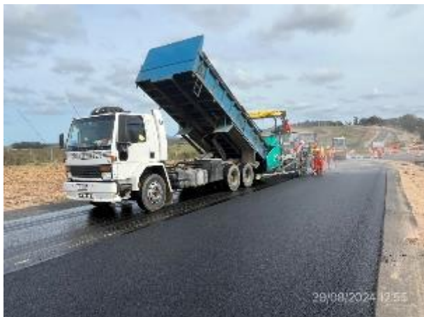
Foto 12.1-7, P06. Maniobra de tendido de mezcla en ejecución. Buenas condiciones generales de limpieza.
