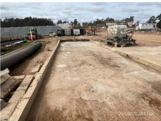
Foto 12.2-11. P03, Obrador. Pileta de lavado de camiones con superficie impermeable y pendientes adecuadas hacia cámara de decantación.
