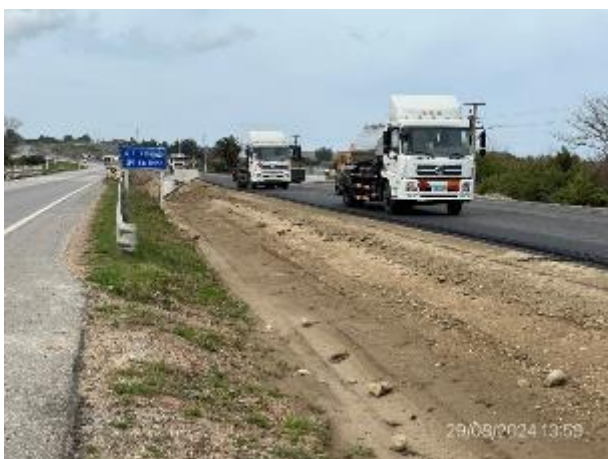
Foto 12.1-3, P05. Frente de obra, tendido de mezcla asfáltica intermedia. Ruta 9 progresiva 109K400 a (-).
