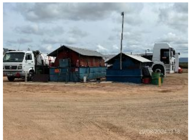
Foto 12.2-18. P03, Planta asfáltica. Dos tanques surtidores de combustible en locales techados y con envallado perimetral.
