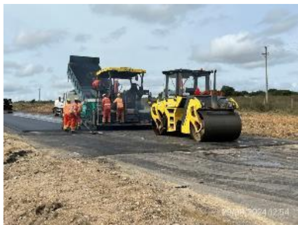
Foto 12.1-6, P06. Frente de obra, tendido de mezcla asfáltica drenante. Ruta 9 progresiva 114K600 a (-).
