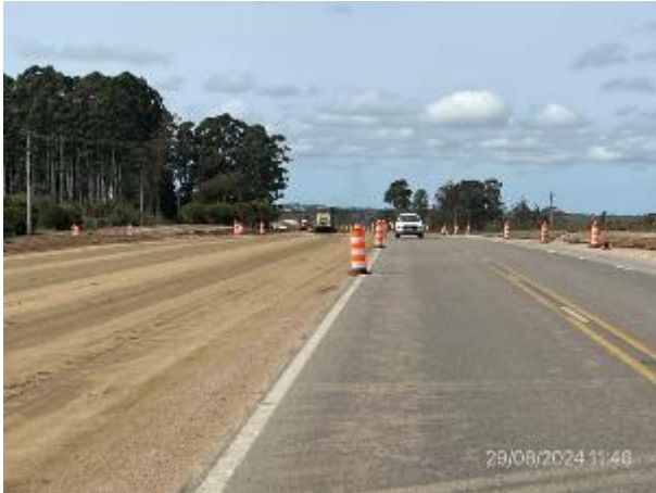
Foto 12.1-7, P09. Base granular en proceso de compactación.
