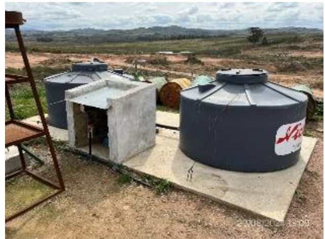
Foto 12.2-10. P03, Obrador. Perforación para explotación de aguas subterráneas y reservorios para agua no potable.
