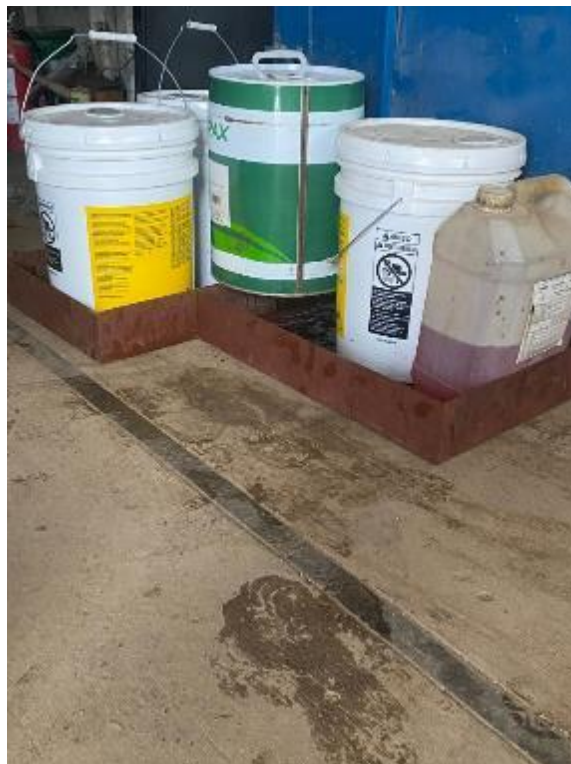
Foto 12.4-2. P03, Planta asfáltica, nuevas bandejas impermeables.
