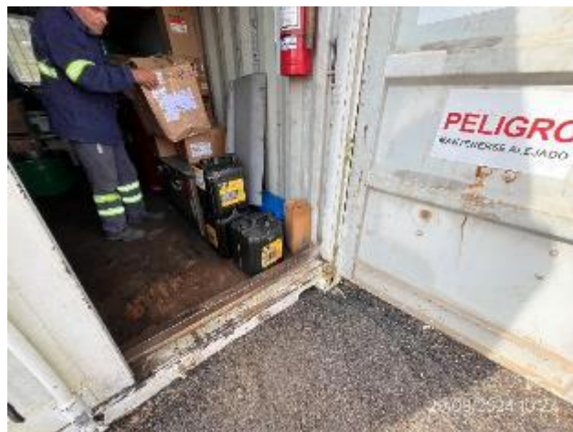
Foto 12.2-8, P03. Obrador, contenedor cerrado y con zócalo impermeable, pañol y acopio de lubricantes.
