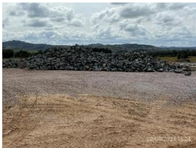
Foto 12.2-24. P03, tren de trituración. Acopio de piedra bruta proveniente de desmontes en roca ejecutados por GVESA sobre la futura traza de segunda senda.
