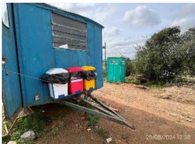
Foto 12.3-6. P04, escasa capacidad de acopio de residuos segregados por corriente de generación. No hay elementos para gestión de contingencias ambientales.
