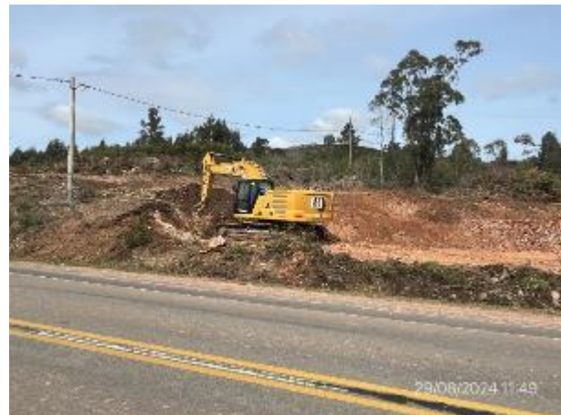
Foto 12.1-10, P10. Apertura de caja a nivel de subrasante, senda a (+).
