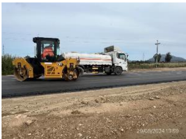
Foto 12.1-5, P05. Maniobra de compactación de mezcla en ejecución.
