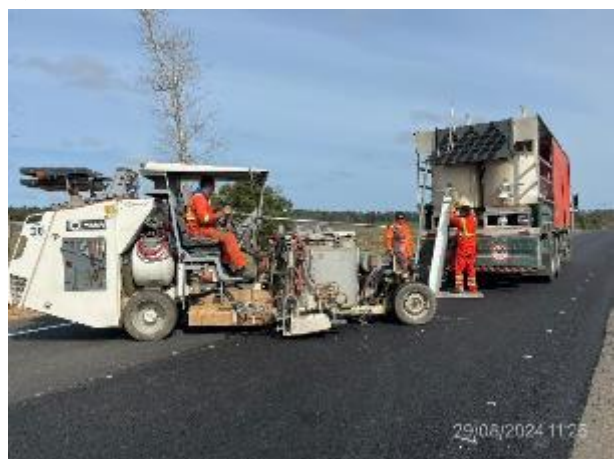
Foto 12.1-4, P08. Frente de obra de señalización horizontal. Ruta 9 progresiva 146K800.
