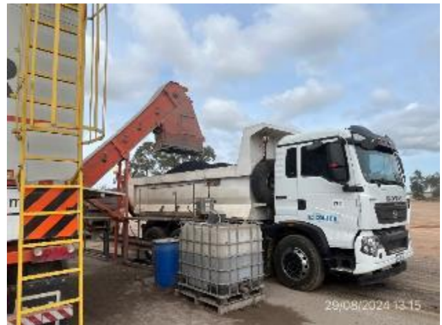
Foto 12.2-16. P03, Planta asfáltica. Transporte de mezcla asfáltica a punto de destino.
