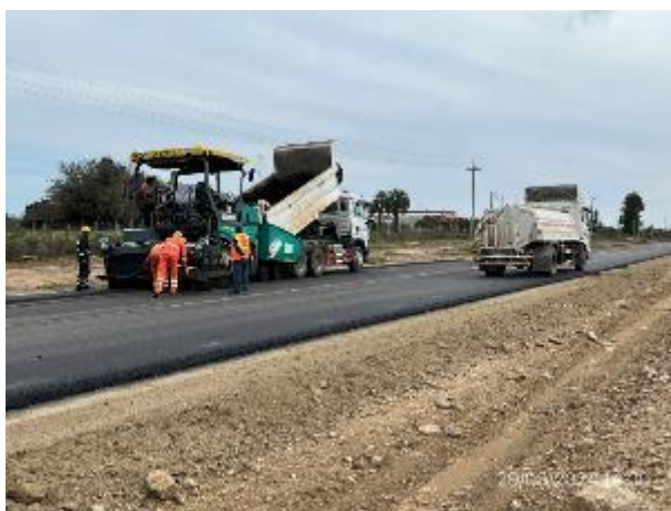
Foto 12.1-4, P05. Maniobra de tendido de mezcla en ejecución. Buenas condiciones generales de limpieza.
