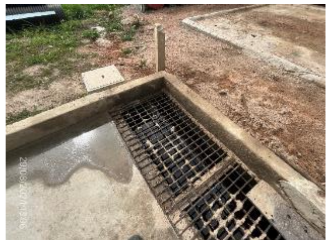
Foto 12.2-12. P03, Obrador. Pileta de lavado de camiones, cámara de decantación.
