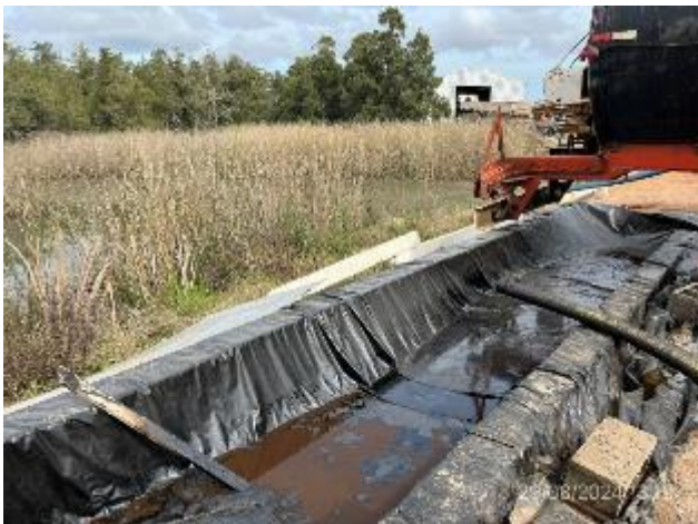
Foto 12.2-15. P03, Planta asfáltica. Pileta de digestión de hidrocarburos.
