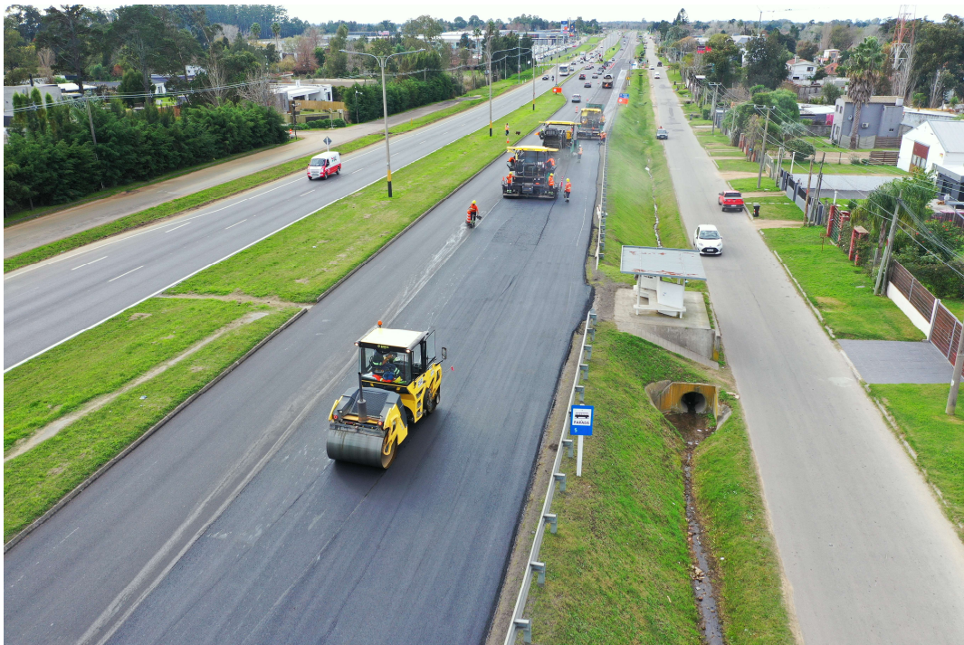
Imagen 3 - Tendido de asfalto
