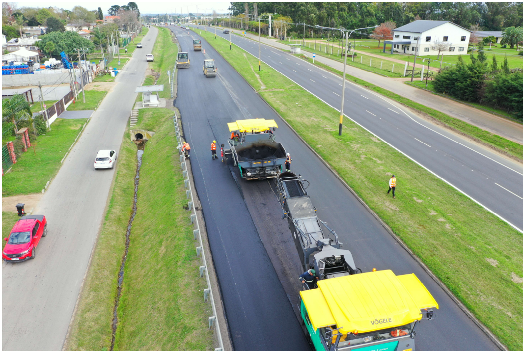
Imagen 3 - Tendido de asfalto
