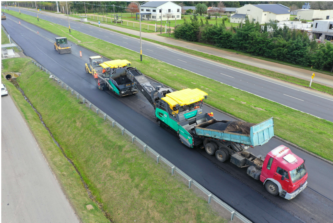
Imagen 4 - Tendido de asfalto
