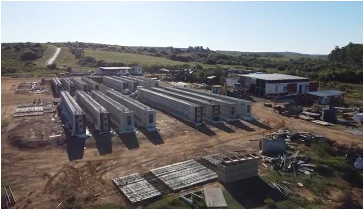
Imagen N°2: Instalaciones del obrador (oficinas, comedor, baños, pañol de herramientas, recinto de productos químicos y combustibles, sitio de prefabricados de hormigón, etc).
