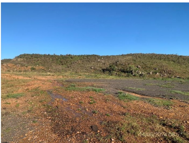
Foto 12.1-11, P05. Taludes suavizados con suelo vegetal, explanada granular compactada permanece como eventual mejora a beneficio del propietario
