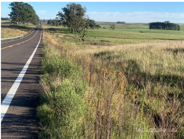
Foto 12.2-3, Ruta 27. Faja pública con pendientes adecuadas y buena cobertura vegetal.
