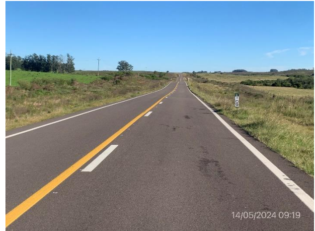
Foto 12.2-2, P01. Início de tramo, Ruta 27 progresiva 109K000. Señalización horizontal terminada.
