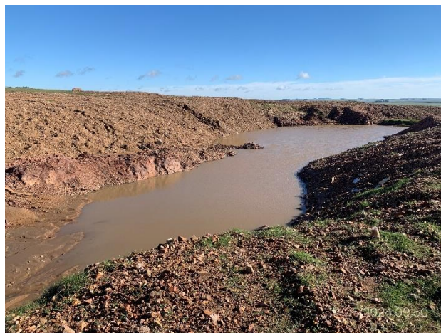
Foto 12.1-14, P06. Cantera, taludes adecuados en frente de explotación.
