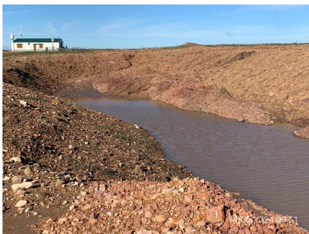
Foto 12.1-15, P06. Cantera, tajamar natural queda eventualmente como mejora a beneficio del propietario.
