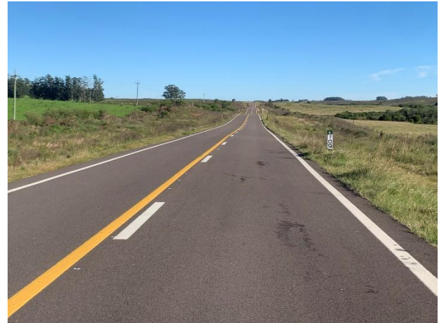
Foto 12.2-2, P02. Fin de tramo, Ruta 27 progresiva 109K000. Carpeta de rodadura y señalización horizontal terminada.
