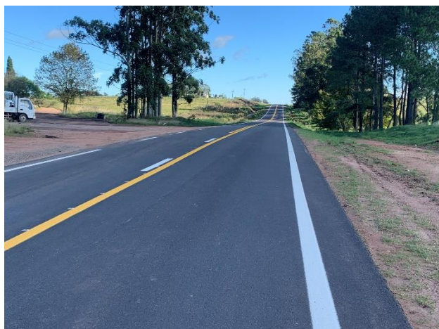
Foto 12.2-5, P01. Inicio de tramo. Ruta 27 progresiva 75K000.
