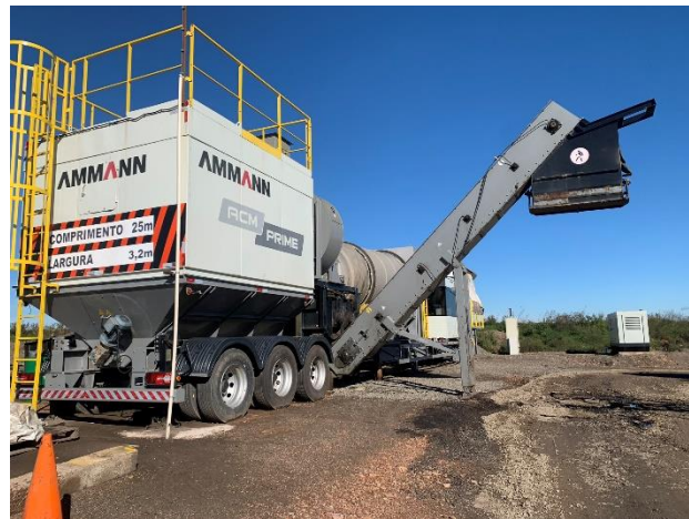
Foto 12.1-2, P04. Planta asfáltica sin actividad
