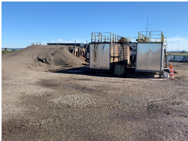
Foto 12.1-1, P04. Obrador y Planta asfáltica de Grinor SA. Faja Pública de Ruta 27 progresiva 61K100 a (-).
