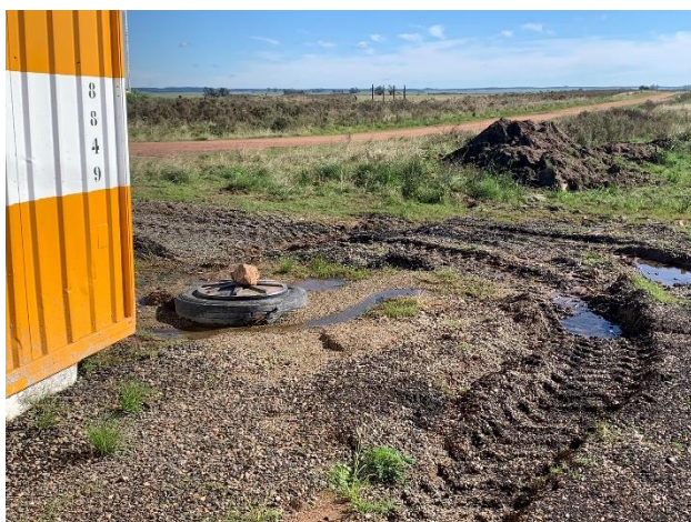
Foto 12.1-9, P04. Obrador, depósito impermeable para recolección de aguas servidas.
