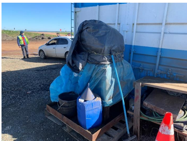
Foto 12.1-7, P04. Obrador, residuos de percolretileno usado acopiado en tarrinas tapadas y bandeja estanca.
