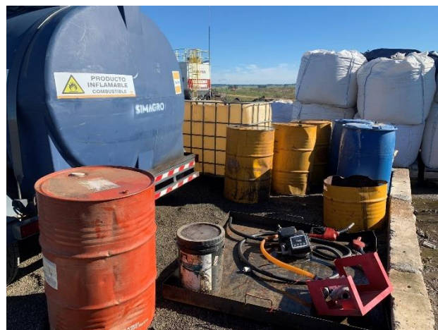
Foto 12.1-4, P04. Obrador, tarrinas y depósito de combustible en recinto con envallado defectuoso.
