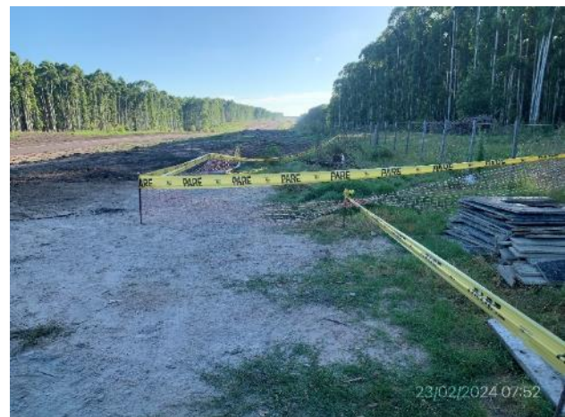
Foto 12.2-10, P03. Restos de ROCs a ser removidos
