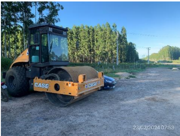
Foto 12.2-7, P03. Obrero secundario con desmontaje en proceso. Faja pública de nueva traza de Ruta 20, progresiva 111K200 a (+).
