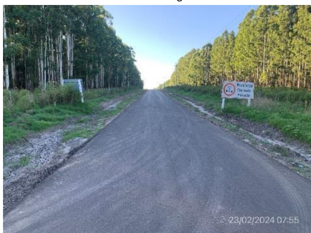
Foto 12.2-5, Ruta 20, progresiva 110K000. Nuevo acceso a Pueblo Grecco, carpeta de rodadura en mezcla asfáltica.
