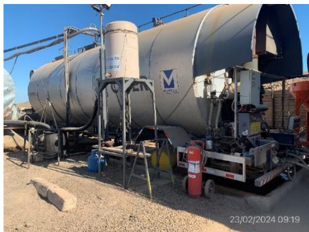
Foto 12.1-4, P05. Planta asfáltica. Envolvado perimetral correcto.
