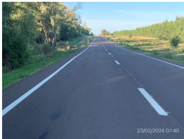
Foto 12.2-2, Ruta 20. Tareas terminadas, variante de tramo terminado y nueva carpeta de rodadura ejecutada. Señalización horizontal terminada.
