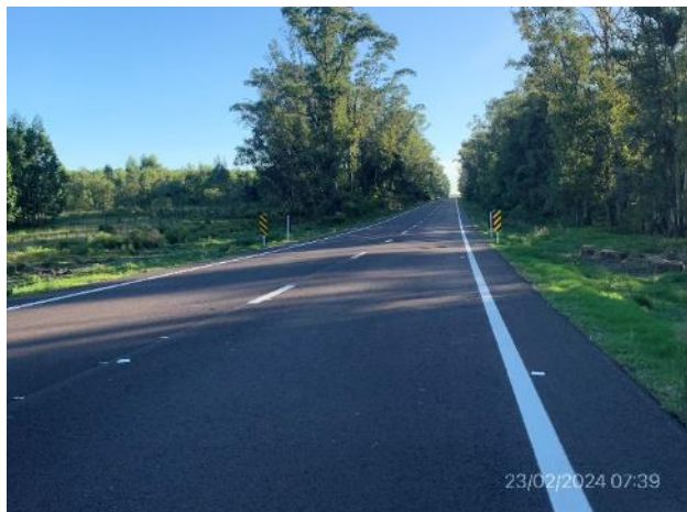
Foto 12.2-1, P01. Inicio de tramo. Ruta 20, progresiva 104K650.
