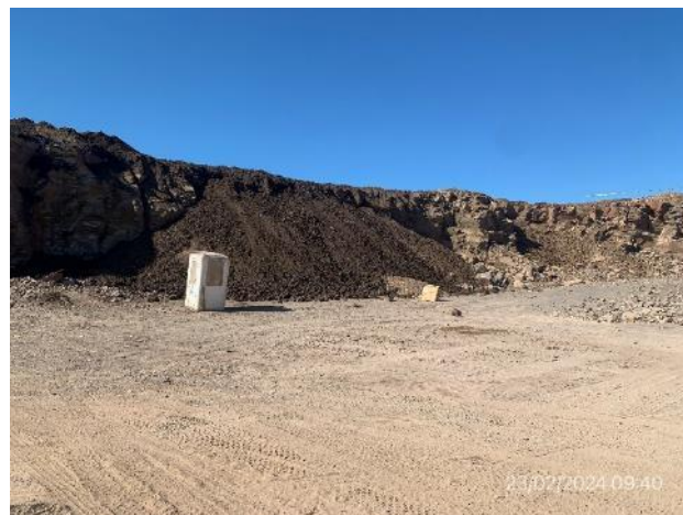
Foto 12.1-10, P06. Cantera de basalto, tareas extractivas finalizadas
