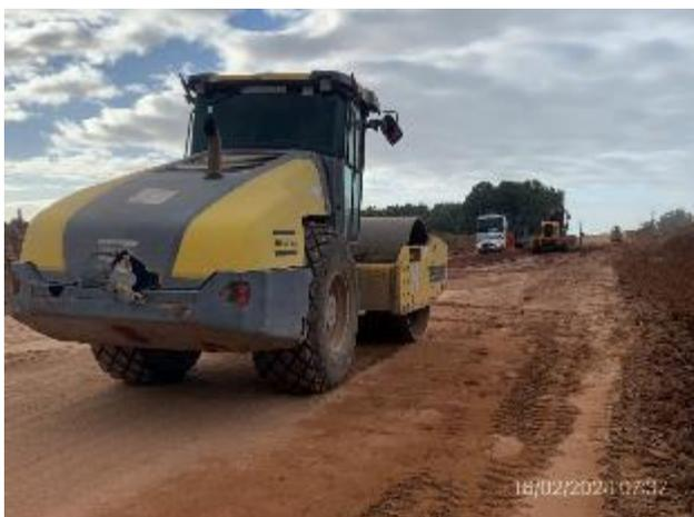
Foto 12.2-3, P09. Ruta 6, frente de obras. Ruta 6 progresiva 283K300. Movimiento de suelos en proceso, Subcontrato Rural Vial SA.
